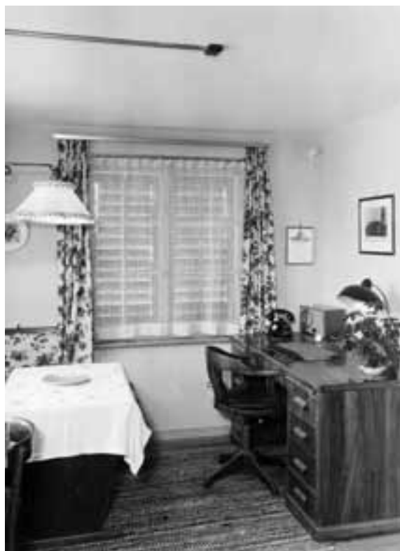
Das «Büro» des Stationierten in Stammheim um 1959. Auf dem Pult das Empfangsgerät für den Polizeirundspruch.
