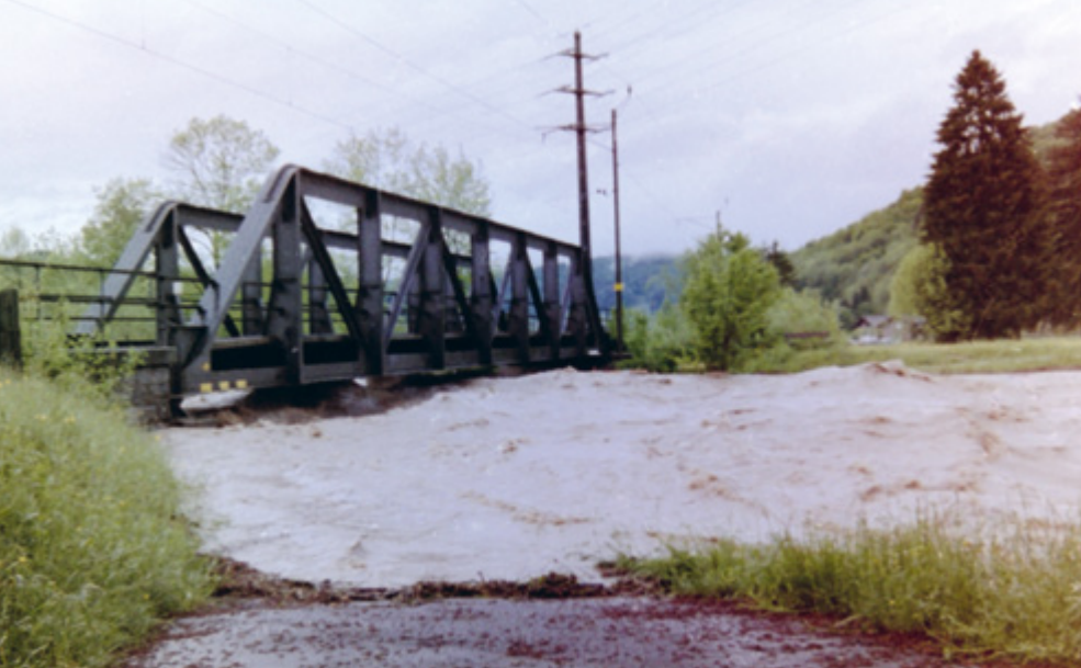
Das Abflussvermögen der Töss am Limit: Ein grösseres Hochwasser als 1999 würde die SBB- und die Sommerau-Brücke überfluten.
