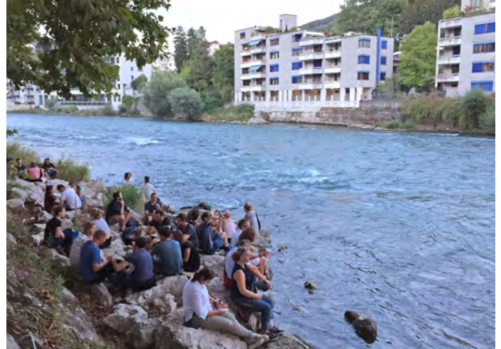
Blockteppich, eine flächige Ansammlung von Steinblöcken, als uferstrukturierendes Element, das auch als Aufenthaltsbereich genutzt wird an der Limmat in Baden. © André Seippel
