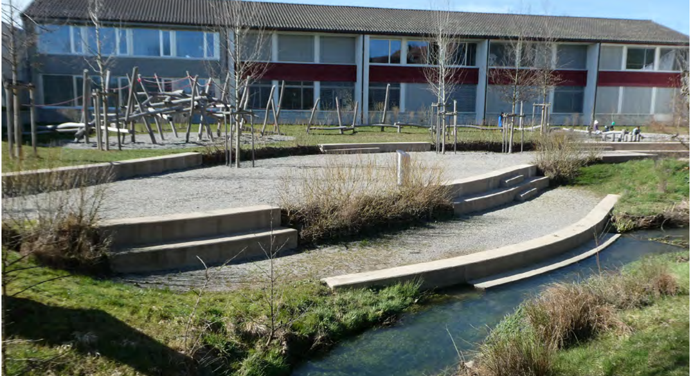
Längsvernetzung ist an der Surb in Niederweningen möglich. Im Bereich der Stufen hat es jedoch exponierte Stellen (rote Pfeile). Die Büsche bieten Sichtschutz und Verstecke für Kleintiere (grüne Fläche). © André Seippel
