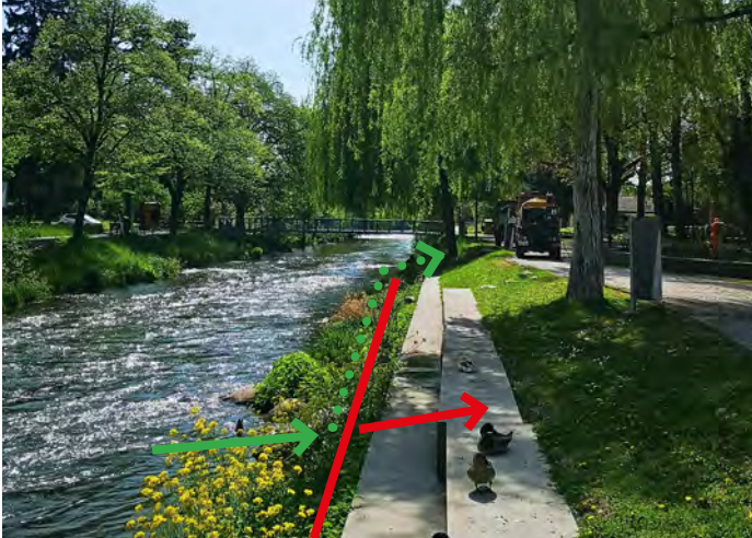
Der Wasser-Land-Übergang ist durch Schroppen (grosse Steine) im Normalfall möglich (ausser bei hohen Abflüssen), wird jedoch durch die Treppenstufen unterbrochen (rote Markierungen). Über einen Umweg ist Quervernetzung möglich (grüne Markierung). © AWEL
