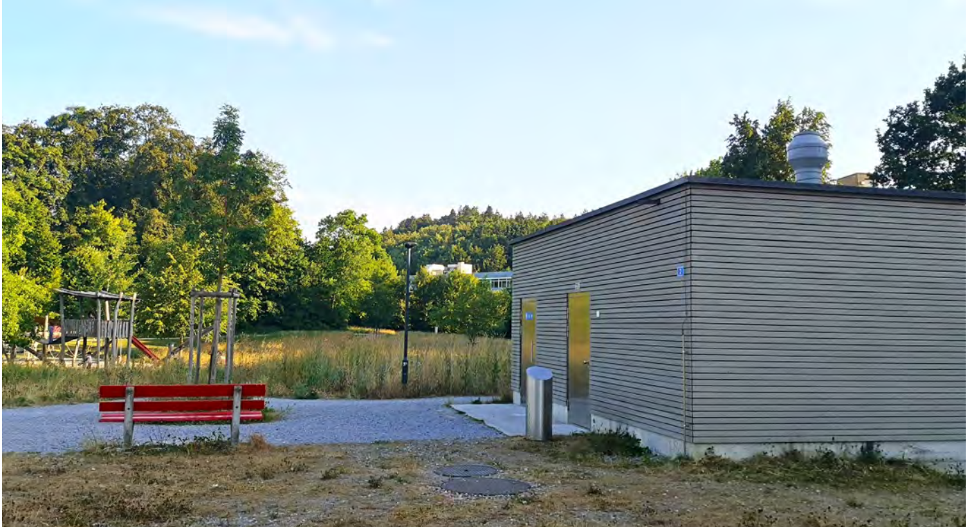
Permanente Sanitäranlage am Grändelbach in Effretikon. © AWEL
