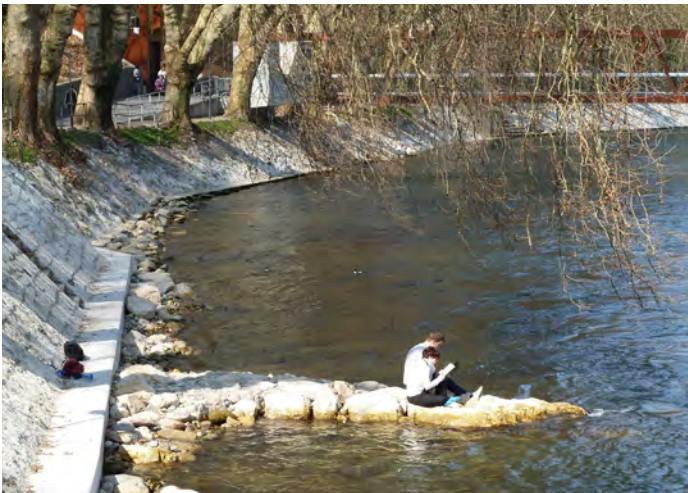
Bühne als Strukturierungselement, das an der Limmat in Baden auch als Aufenthaltsbereich genutzt wird. © André Seippel
