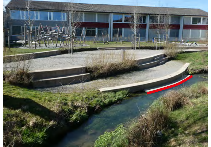
Der Übergang vom Wasser ans Land wird an der Surb in Niederweningen durch die unterste Stufe unterbrochen (rote Markierung). © André Seippel
