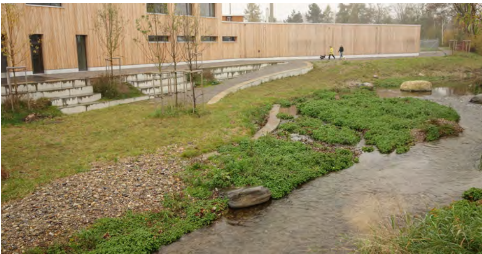
Derselbe Zugang 2020 mit verlandeter Aufweitung und verkrauteter Kiesbank. Der Zugang zum Wasser ist nicht mehr direkt gegeben. © André Seippel
