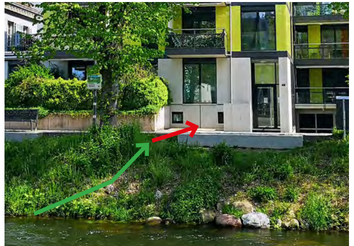
Die Quervernetzung ist hier an der Glatt in Dübendorf nur bis zur Böschungsoberkante gewährleistet (grüner Pfeil). Im Anschluss stellt die dichte Häuserreihe eine Barriere dar. Ausserhalb des Gerinneprofils besteht keine Anbindung an terrestrische Lebensräume (roter Pfeil). © AWEL
