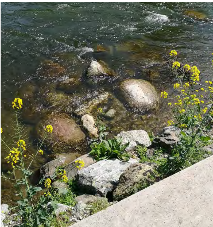
Vorgelagerte Schoppen (grosse Steine) zur Erhöhung der Strömungsvariabilität und zum Schutz vor Erosion in der Glatt beim Stadtpark Dübendorf. © AWEL
