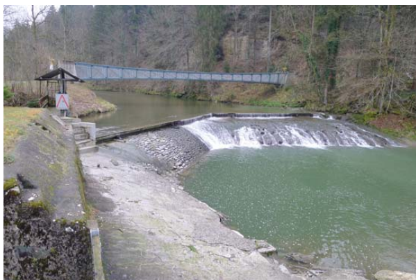
Bild A5 Feste Wehrschwelle KW Schiffli mit Wasserfassung (links im Bild). 25.11.2014.
