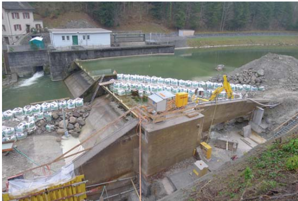
Bild A3 Stauwehr KW Waldhalde mit den zwei Klappen und der Spülöffnung (hinten links). Zur Zeit ist die Fischaufstiegshilfe im Bau. 25.11.2014.
