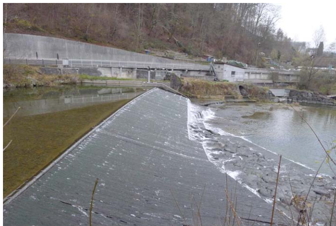
Bild A7 Wehrschwelle KW Langnau mit Sohle im Oberwasser, Wasserfassung, Maschinenhaus und Wasserrückgabe (im Hintergrund). 25.11.2014.
