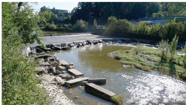
Bild A8 Wehrschwelle KW Sihl-Manegg mit mit Tosbecken und Insel im Unterwasser. 14.9.2012.
