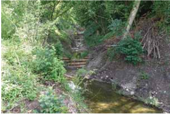
Bild 12 Neu erstellte Holzschwellen zur Sohlensicherung zwischen Unter Balm und Auslikon, Blick gegen die Fliessrichtung.
