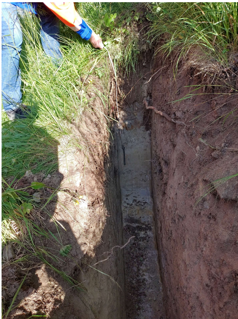
Abbildung 5: Aufnahmen eines durchgeführten Baggerschlitzes zur Baugrundbeurteilung
