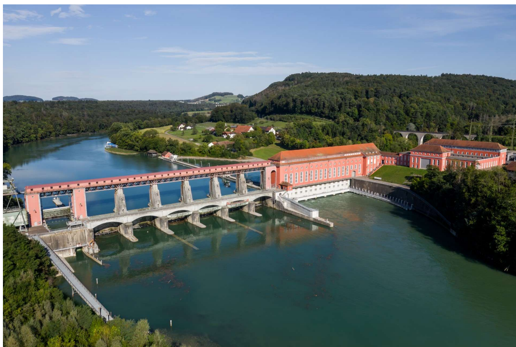
Abbildung 13 Flusskraftwerk Eglisau heute (Quelle: Christian Merz)
