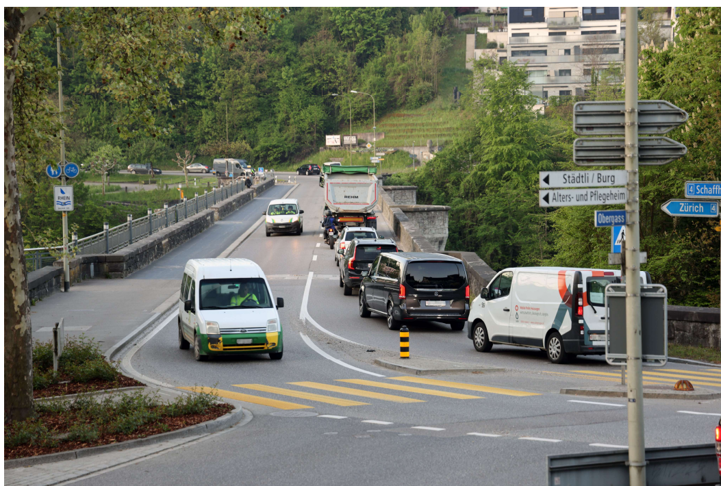
Abbildung 1 Die Hauptstrasse Nr. 4 über die Rheinbrücke in Eglisau heute (Quelle: Tiefbauamt Kanton Zürich)
