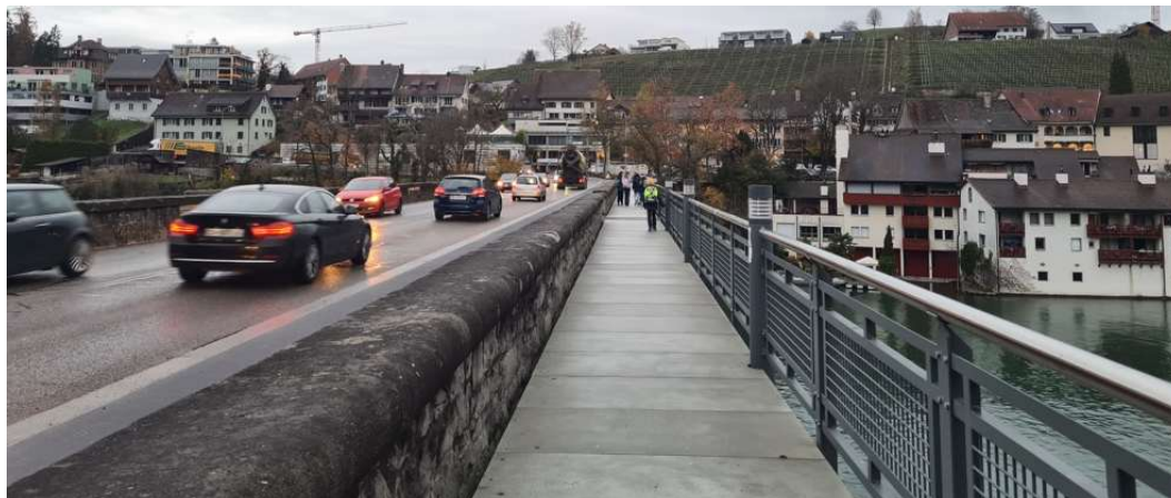
Abbildung 76 Störende Elemente an der Rheinbrücke (Quelle: Tiefbauamt / Suter von Känel Wild Planer und Architekten AG)
