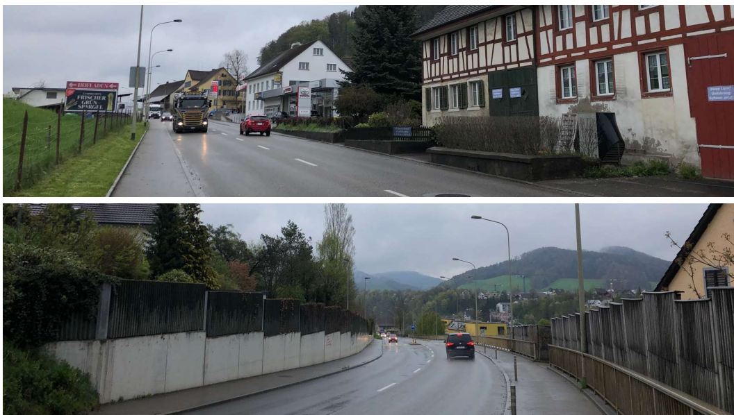
Abbildung 71 Ortsbauliche Defizite in Seglingen entlang der Zürcherstrasse und in Eglisau entlang der Schaffhauserstrasse (Quelle: Tiefbauamt / Suter von Känel Wild Planer und Architekten AG)
