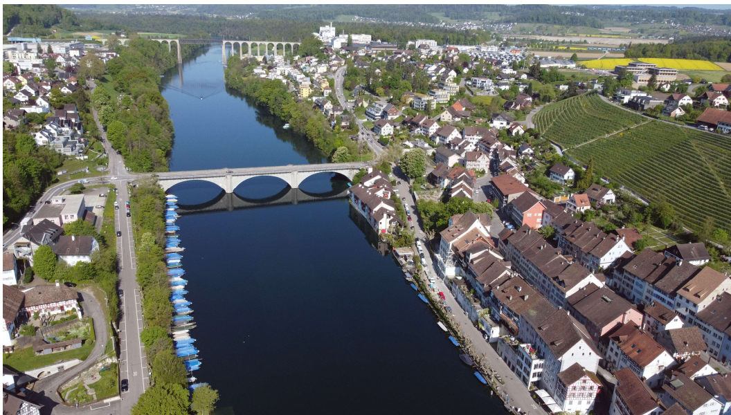
Abbildung 8 Städtli rechtsufrig und Seglingen linksufrig (Quelle: Tiefbauamt Kanton Zürich)
