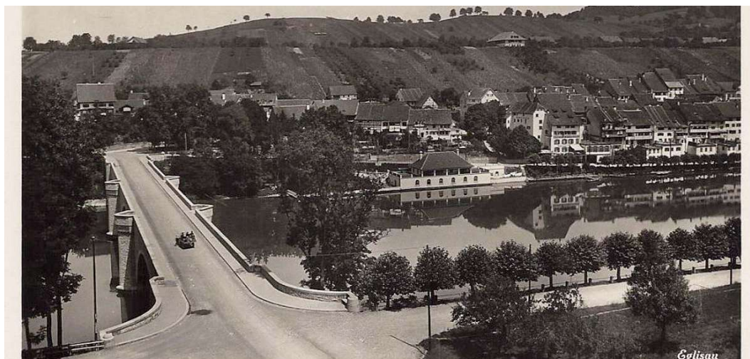
Abbildung 75 Rheinbrücke Eglisau von 1919 als sorgfältig in die Landschaft eingegliedertes Kunstbauwerk (Quelle: swiss.nailizakon)
