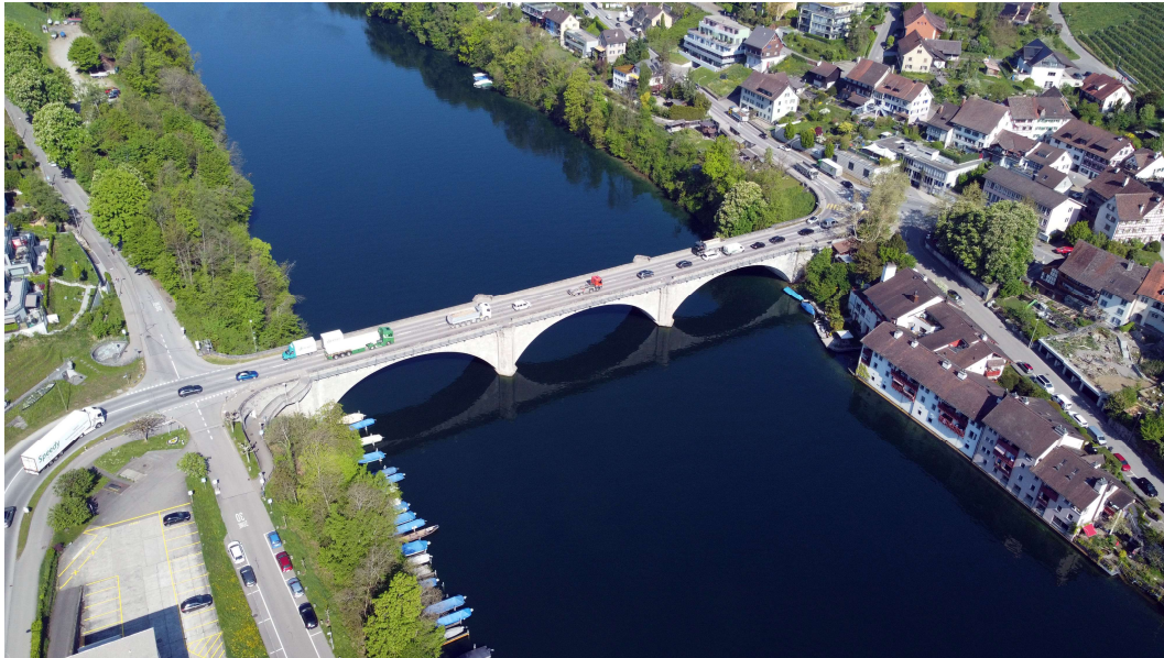
Abbildung 17 Rheinbrücke Eglisau Mai 2025 (Quelle: Tiefbauamt Kanton Zürich)
