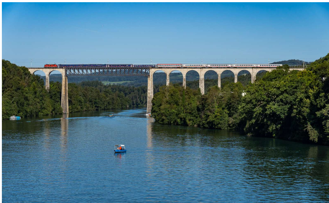
Abbildung 15 Eisenbahnbrücke Eglisau im Jahr 2024, Blick flussabwärts (Quelle: Julian Ryf)
