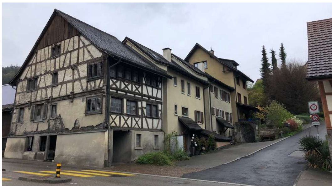
Abbildung 77 Heruntergekommene Bauten entlang der Ortsdurchfahrt von Seglingen (Quelle: Tiefbauamt / Suter von Känel Wild Planer und Architekten AG)
