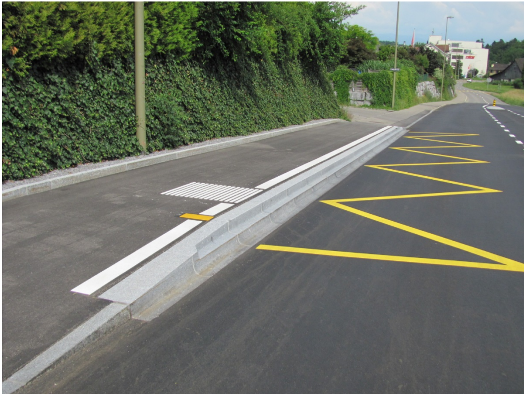
Hombrechtikon Haltestelle Hofacherstrasse: (Quelle: Kanton Zürich Tiefbauamt)
