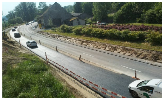
Im Betrieb stehende Verkehrspiste
