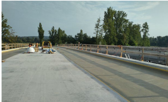
Applizierte Versiegelung im Radwegbereich
