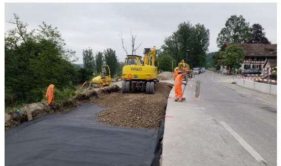
Einbau der Foundationsschicht
