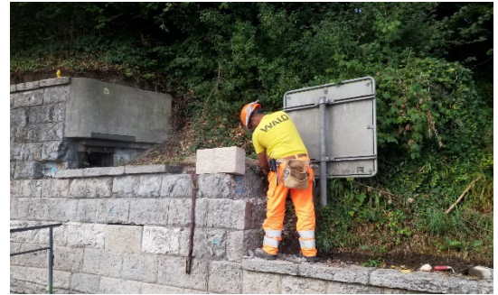
Instandsetzung der Hangmauer
