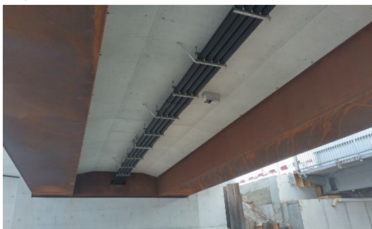
Montierte Kabelschutzrohre
