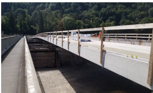
Oberwasserseitiger Konsolkopf fertiggestellt
