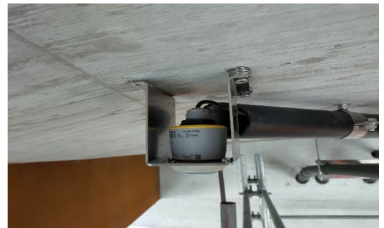
Montierter Pegelradar
