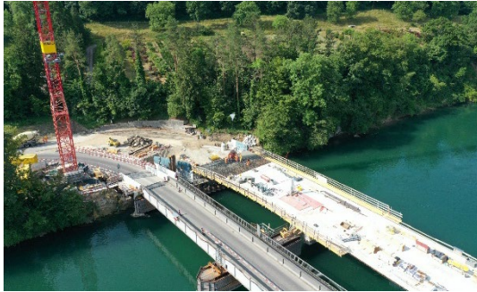
Betonieren der letzten Etappe der Fahrbahnplatte
