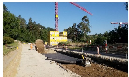
Einbau der Foundationsschicht bergseitig
