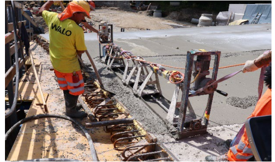
Betonieren der letzten Etappe der Fahrbahnplatte
