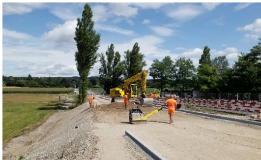
Einbau der Fundation beim Vorland Rüdlingen
