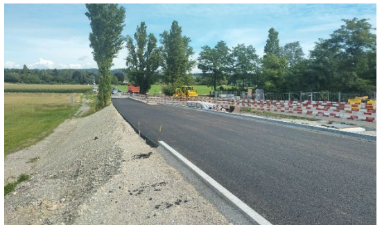
Erfolgt Belageinbau beim Vorland Rüdlingen
