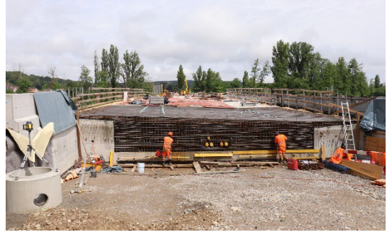
Letzte Etappe der Fahrbahnplatte bewehrt
