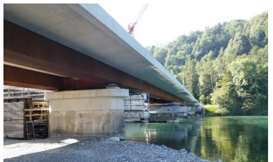
Unterwasserseitiger Konsolkopf fertiggestellt
