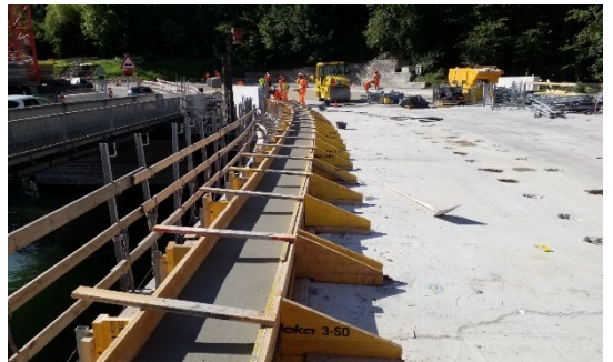
Konsolkopf betoniert
