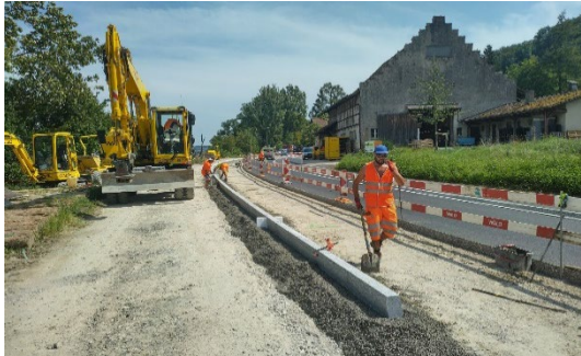
Erstellung Randabschlüsse rheinseitig
