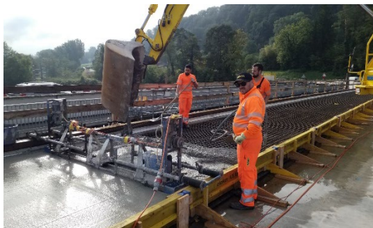
Betonieren des Betonbelags beim Radweg
