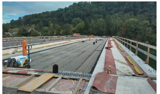
Aufgeflämmte Polymerbitumendichtungsbahn
