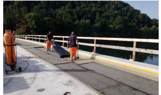
Aufflämmen der Polymerbitumendichtungsbahnen
