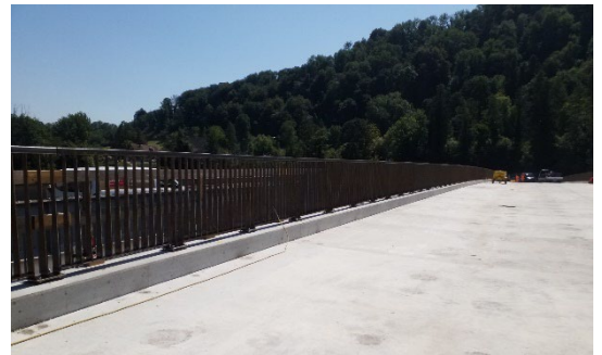
Schwarzmontage des Brückengeländers
