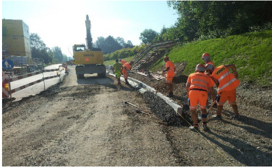
Erstellung der Randabschlüsse bergseitig
