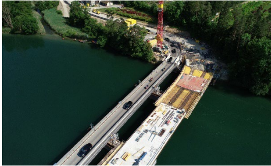
Letzte Etappen der Fahrbahnplatte geschalt
