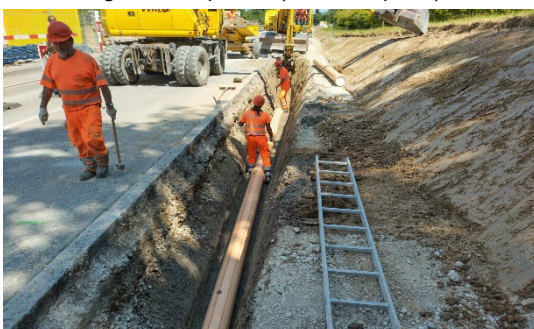
Erstellung der Strassenentwässerungsanlage
