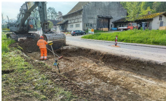
Bodenabtrag bei der rheinseitigen Trassehälfte
