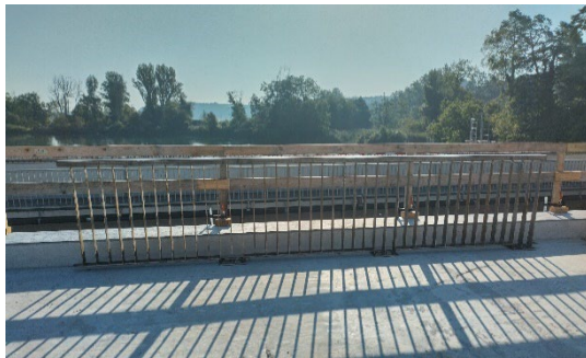
Geländerelement vor der Montage am Konsolkopf
