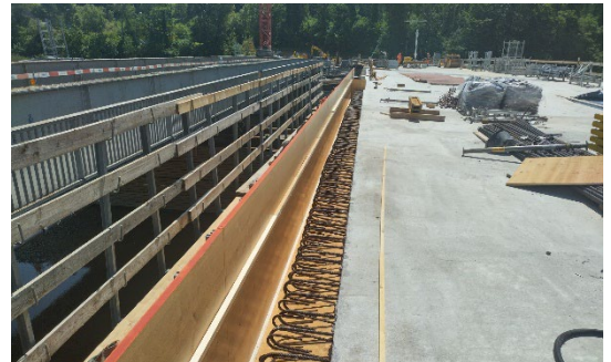
Aussenschalung des Konsolkopfs erstellt
