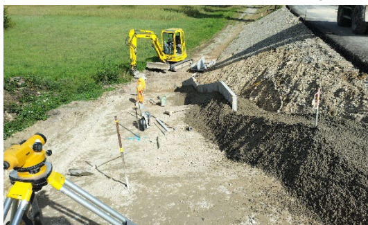
Erstellung des Treppenweg auf Seite Rüdlingen
