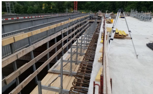
Gesimsgerüst für die Erstellung des Konsolkopfs
