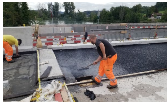
Einbau der Schutzschicht im Radwegbereich
