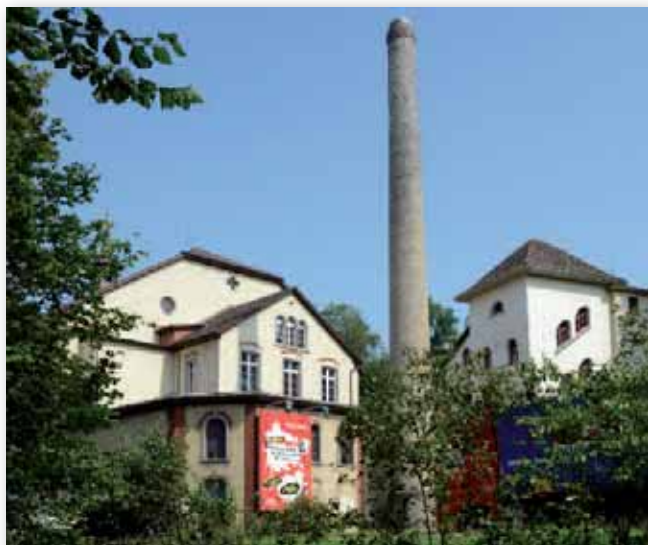
Die Gebäude der ehemaligen Baumwollspinnerei Floos am Orts- eingang von Wetzikon werden einer neuen Nutzung zugeführt.
