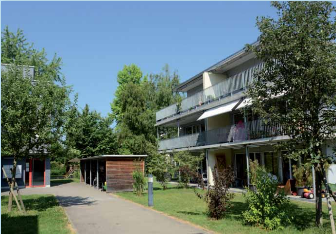
Wohnsiedlung mit geringer baulicher Dichte in Uster mit einer Ausnützungsziffer von 40%.
