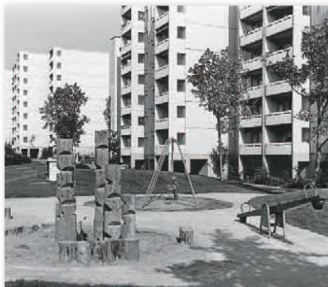
Zeitgemässer Wohnraum für Familien, Göhner-Siedlung Müllerries in Greifensee, Zustand 2013 (rechts).
