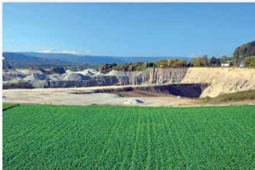
Rafzerfeld mit Kieswerk, Betriebsflächen und rekultivierten Flächen, die zu Gunsten zusätzlicher Auffüllungen wieder abgedeckt werden müssen.
