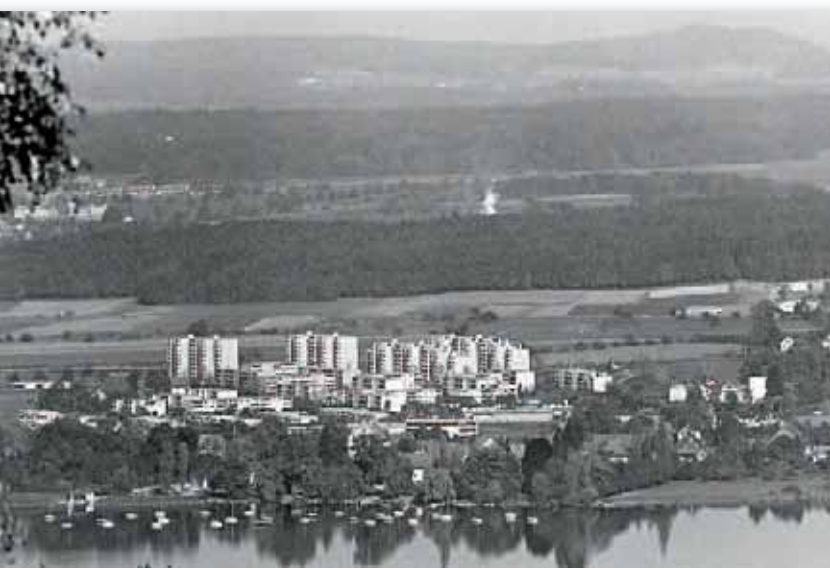
Göhner-Siedlung in Greifensee: Zeugen des Baubooms in den 1970er Jahren.
