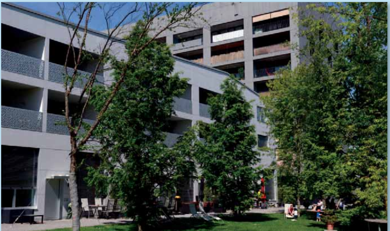
Dichte und Qualität sind keine Gegensätze: Dichtes Wohnen im neuen Stadtteil «Am Rietpark» in Schlieren mit einer Ausnützungsziffer von 220% für das Gesamtareal des Gestaltungsplans Geistlich.
