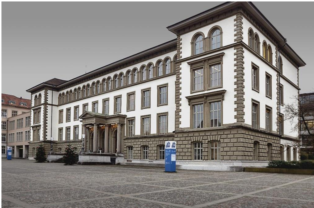
Campus T - Aussenansicht Gebäude TH, Quelle: Hodel Architekten AG
