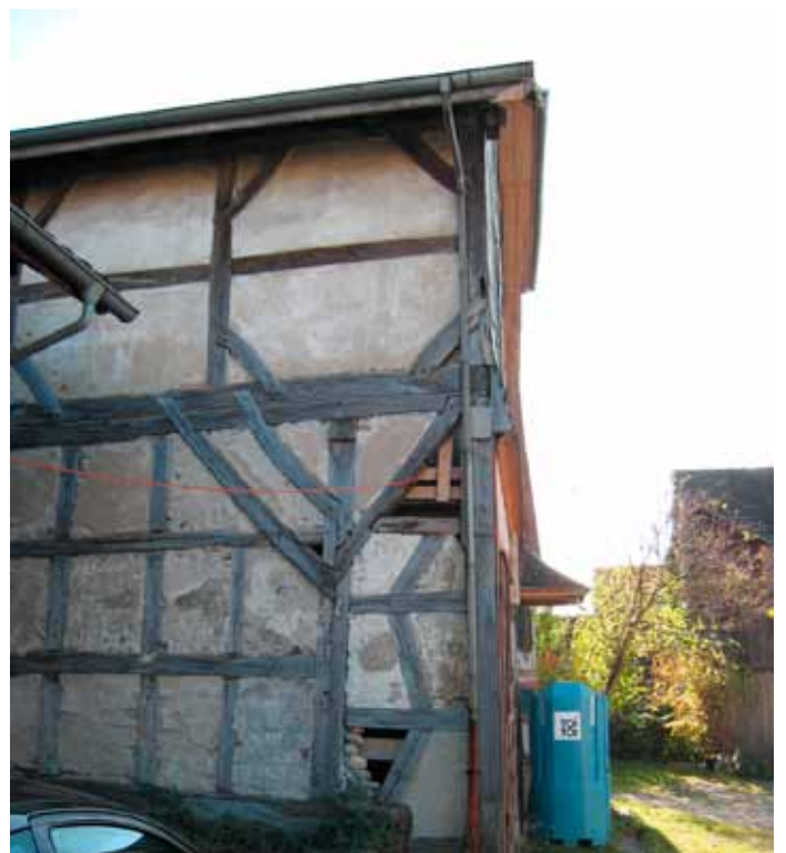
Nordfassade - Ecke Westfassade
