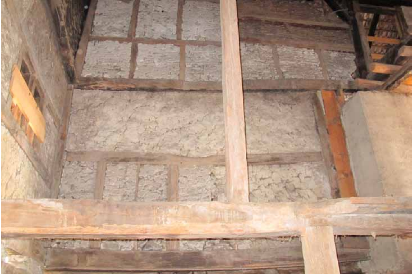
Tenn - Firstwand - Stuhlwand Nord
