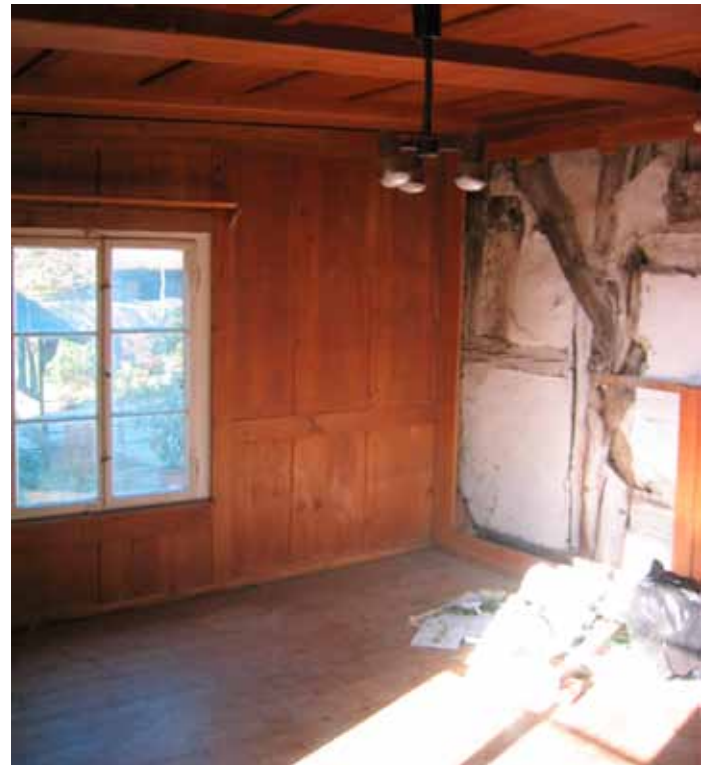
Nebenstube EG - ursprüngliche Südfassade (Aussenwand)
