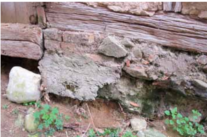
Nordfassade - Sockel mit Schwelle
