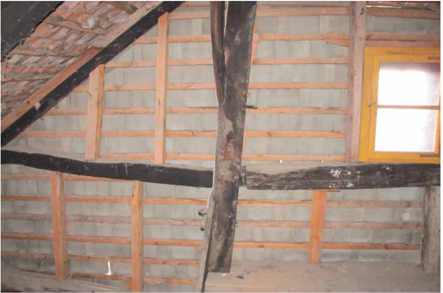
Dachraum DG - Eternitabdeckung an Westfassade
