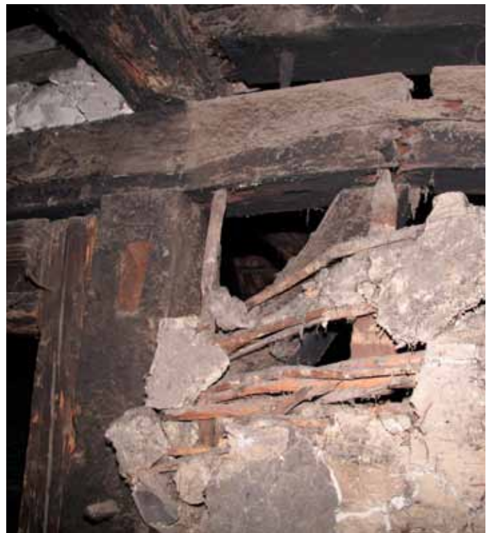
Dachraum DG - Firstbalken
