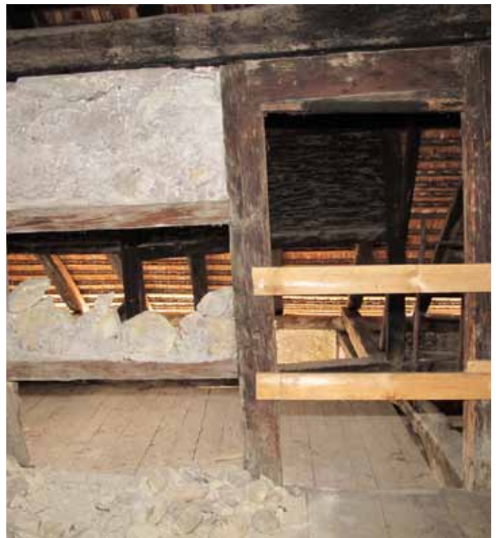
Dachraum DG Firstwand - Ausfachung
