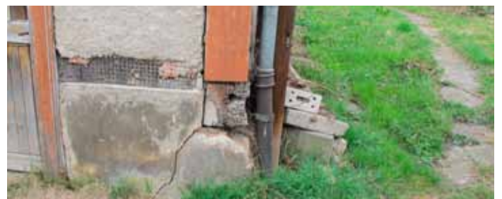
Westfassade EG - Sockel Südwest
