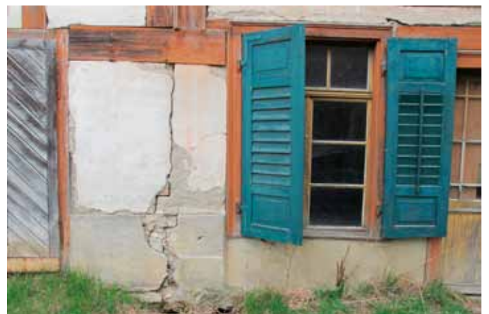
Westfassade EG - Übergang zu Anbau Süd
