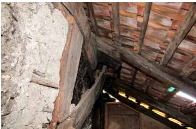
Dachraum OG - Tragkonstruktion ursprünglich Südfassade (Aussenwand)
