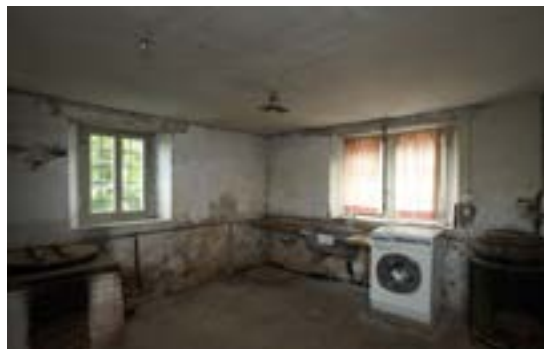
Oberes Kellergeschoss (auf Strassenniveau) mit grossen Sandsteinplatten als Boden und inneren Riegel-Wänden. Der spätere Einbau von Dusche und WC wird rückgebaut.
