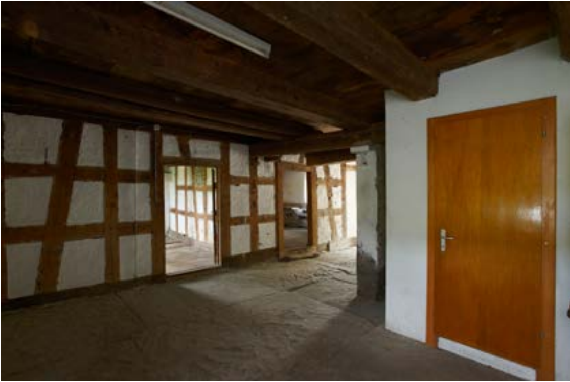
Oberes Kellergeschoss (auf Strassenniveau) mit grossen Sandsteinplatten als Boden und inneren Riegel-Wänden. Der spätere Einbau von Dusche und WC wird rückgebaut.
