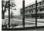
Impression Kantonsschule Rychenberg - Ensemblewirkung modernistischer Architektur mit Parkgestaltung. Der Baumbestand des ehemaligen Friedhofs ist integriert.
