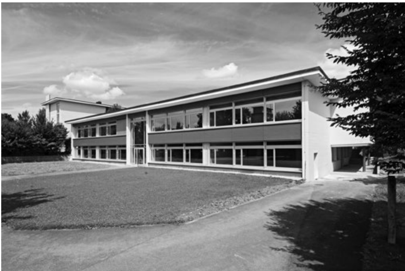
Aussenansicht Kleiner Spezialtrakt mit im Jahr 2013 erneuerten Fenstern
