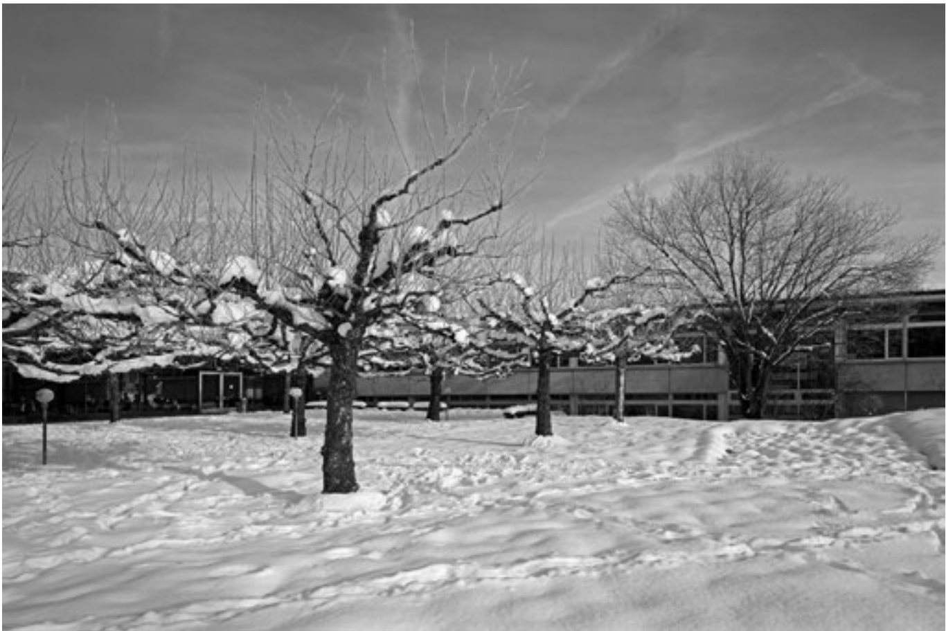
Haupttrakt mit noch nicht instandgesetzter Fassade
