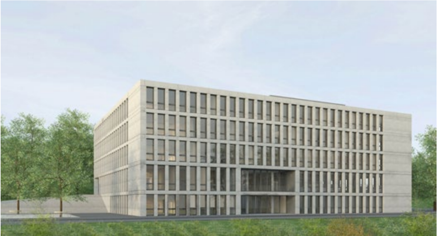
Blick von der Rosenstrasse an die Nordostfassade
