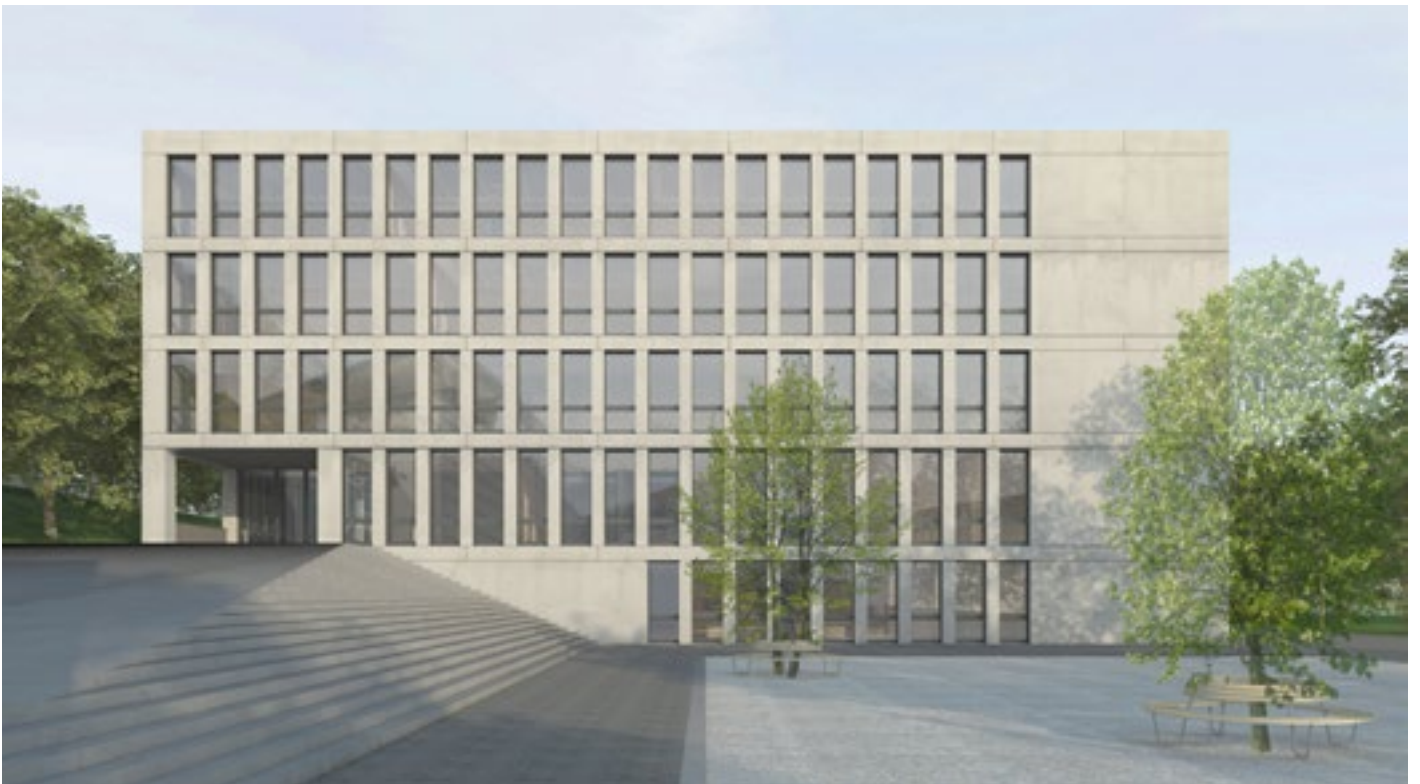
Blick vom Pausenplatz an die Südostfassade
