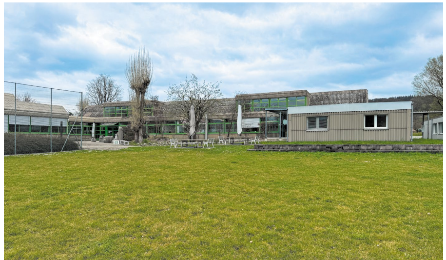
Abbildung 2: Foto Berufsschule Bülach, Südseite (Quelle: Hochbauamt Kanton Zürich, 2025)
