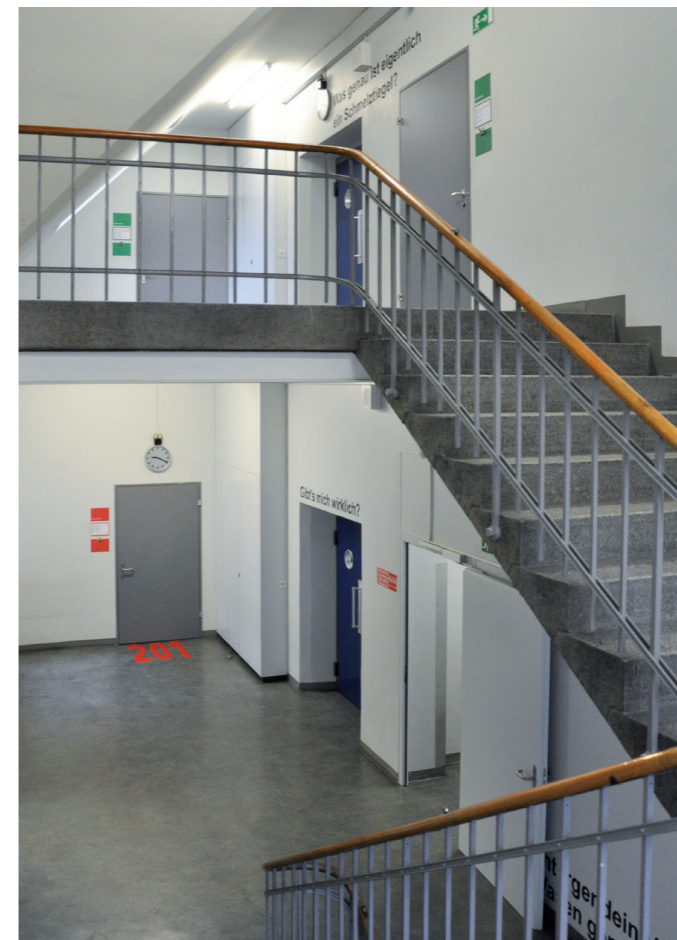
Treppenhaus mit neuen Brandschutztüren und neuer Signaletik
