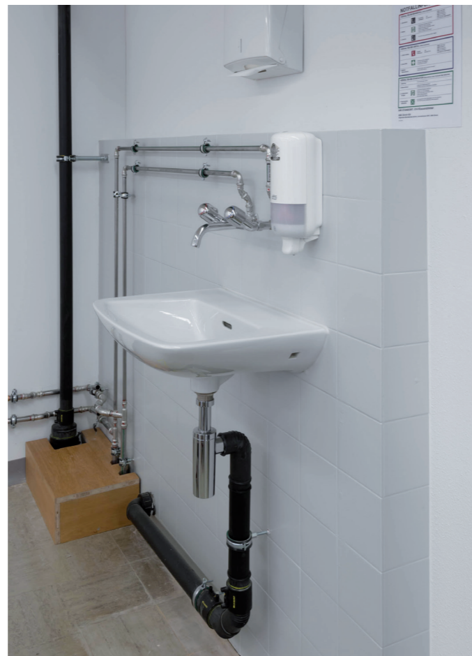
Vorbereitung Anschluss für Cuvetten Klassenzimmer 014
