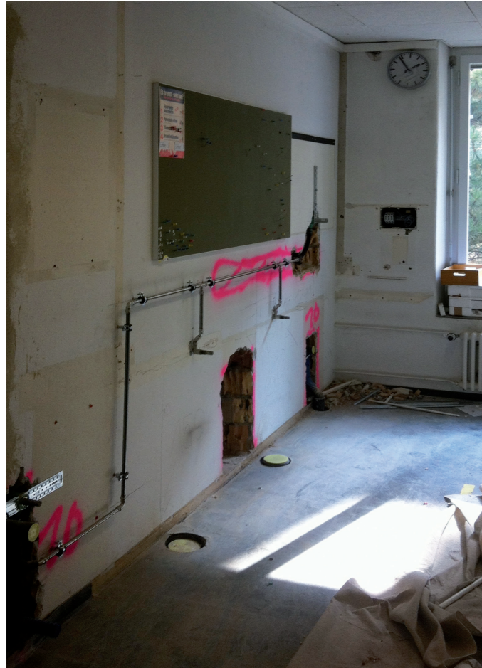
Einbau WC in Büro Hausdienst
