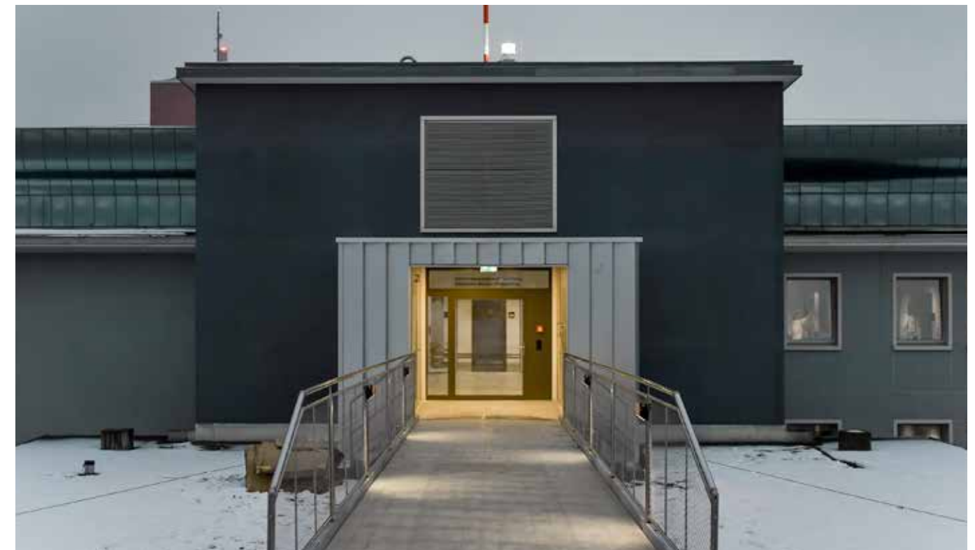
Anbau für medizinisches Equipment und Feuerwehrtensilien
