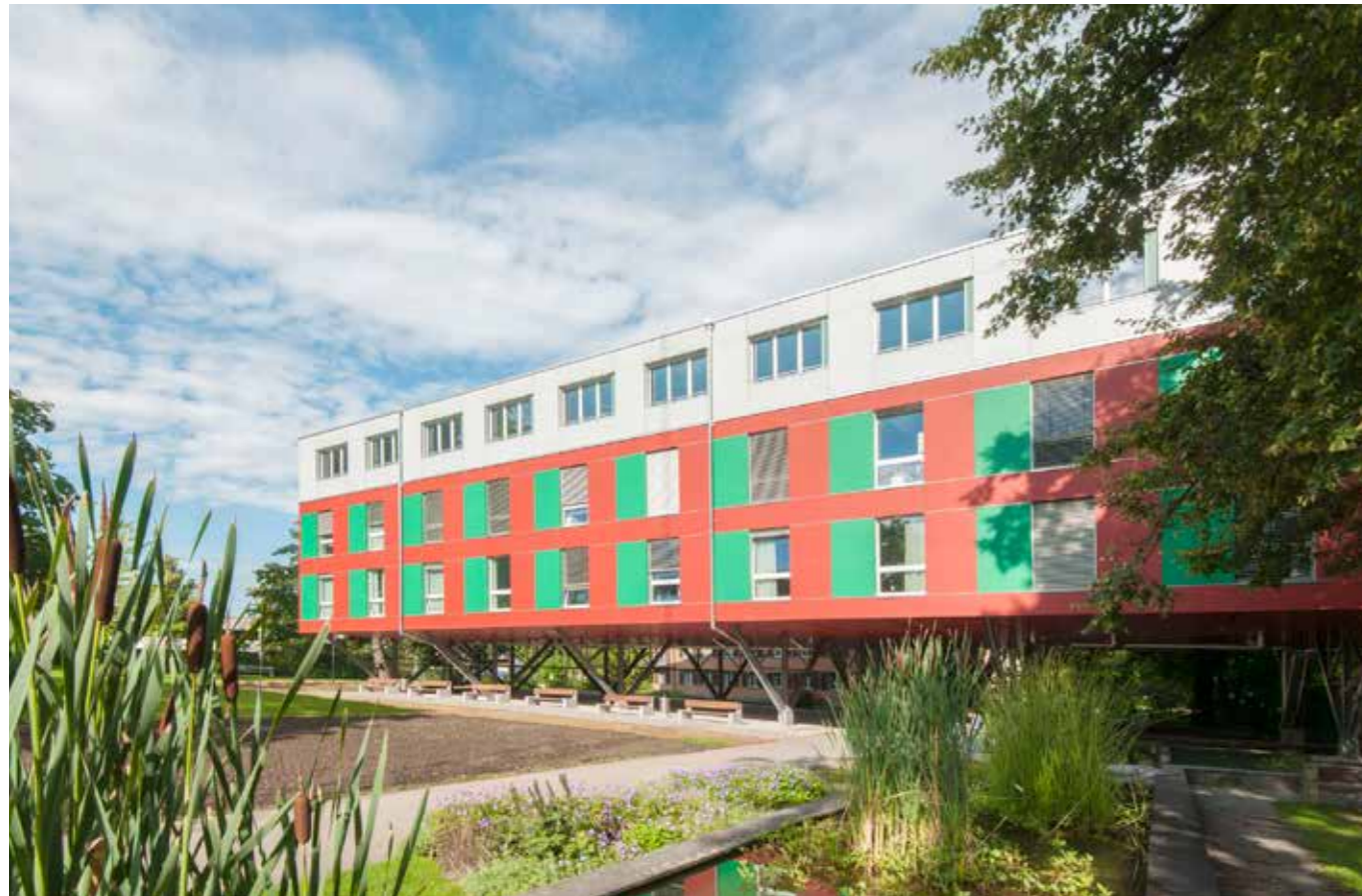
Ostfassade des aufgestockten Pavillons
