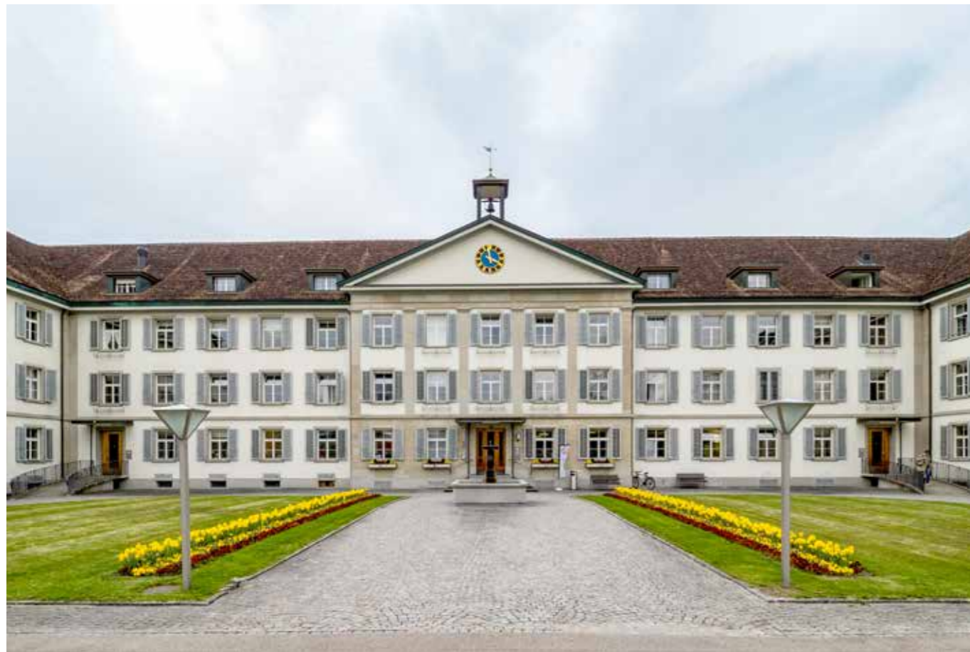
Ostfassade (vor dem Fensterersatz)
