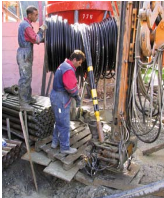
Einführen der Erdsonde ins Bohrloch
