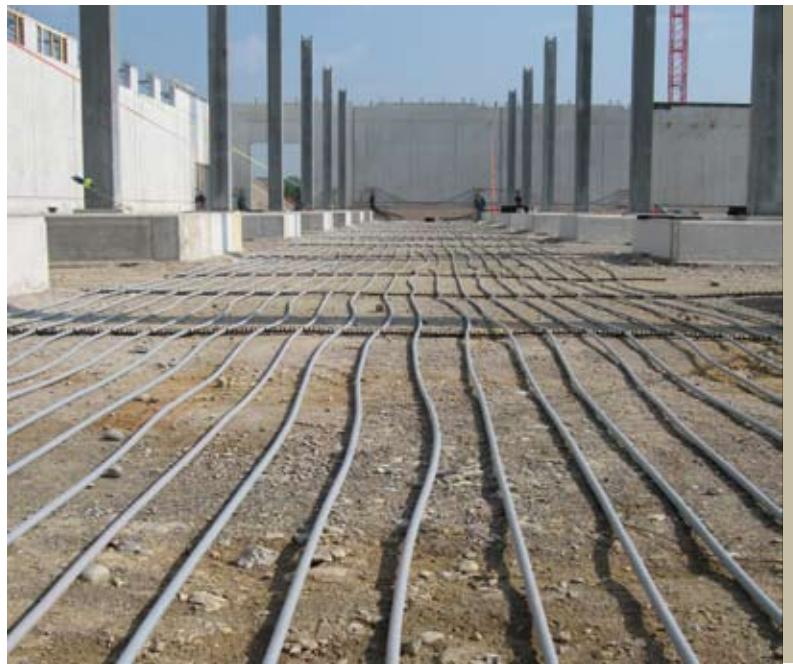
Erdregister unter Bodenplatte
