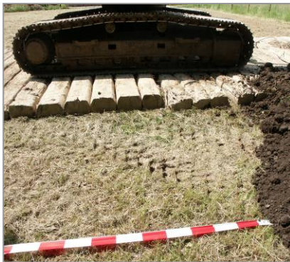
Abb. 2: von Bagger selbst über Kopf verlegt
