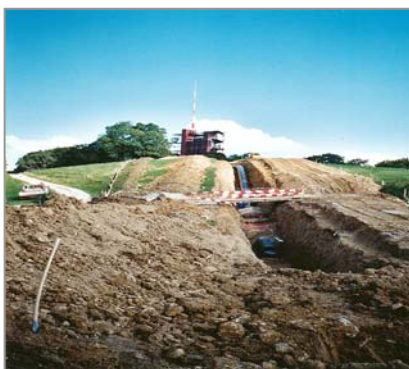
Abb. 2: Aushubpiste im offenen Feld
