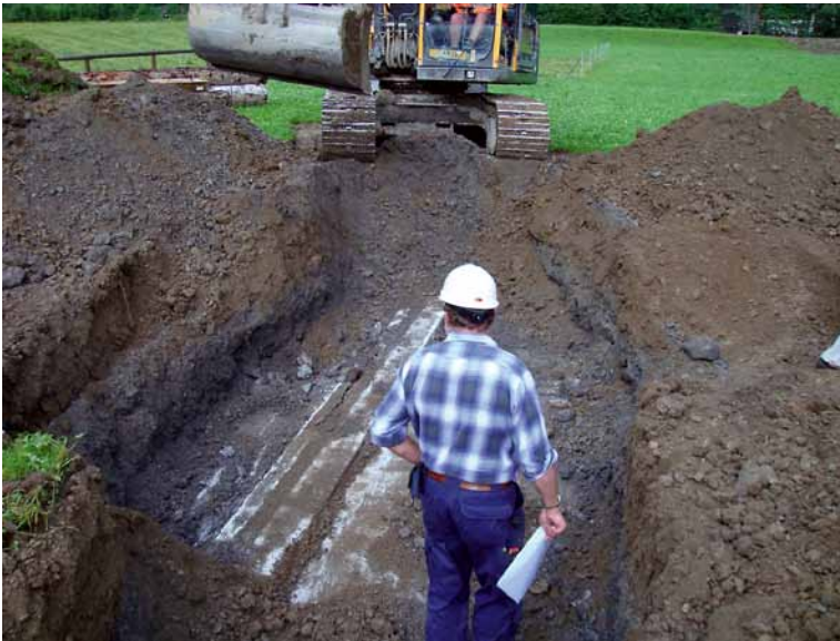
Triage von belastetem Aushub.
