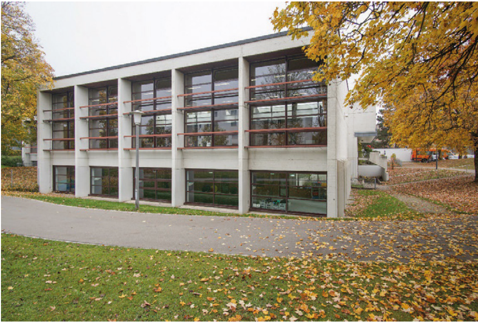
Schulanlage Feldhof, Turn- und Schwimmhalle (Vers. Nr. 01045), Ansicht von W, 09.11.2021 (Bild Nr. D104015_45).
