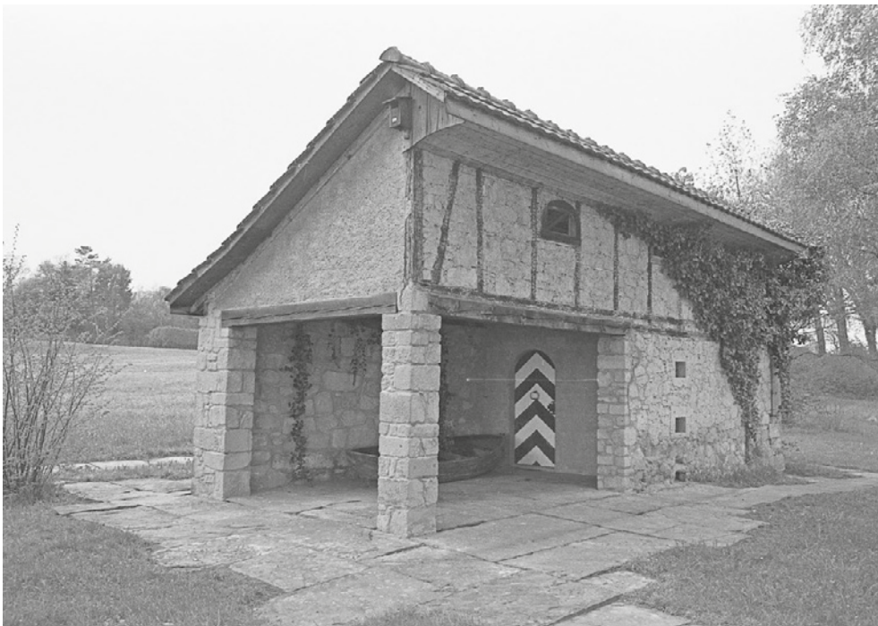
Landsitz Fluh, Gartenhaus mit Schopf (Vers. Nr. 00371), als Fischerhütte vermutl. in der ersten Hälfte des 19. Jh. erbaut und von 1909–1911 zum Gartenhaus umgebaut, Ansicht von SO, 01.01.1980 (Bild Nr. L06413_24).
