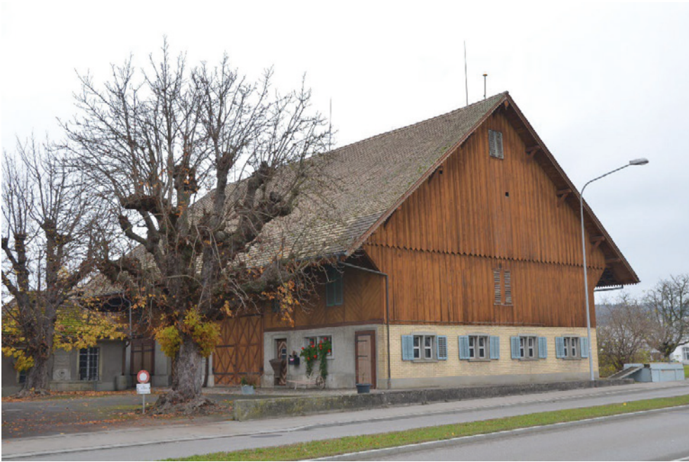
«Doktorhaus», Scheune (Vers. Nr. 00140), Ansicht von S, 16.11.2021 (Bild Nr. D102651_50).
