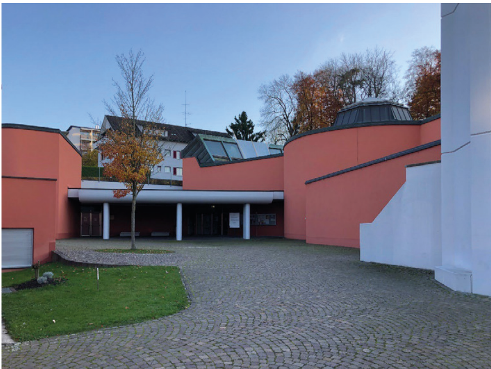
Kath. Kirchenzentrum Kloten, links Nebenkirche (062NEBKIR01731), rechts Kirche Christkönig (Vers. Nr. 01731), in der Mitte offene Eingangshalle, Ansicht von NW, 06.11.2021 (Bild Nr. D100696_55).
