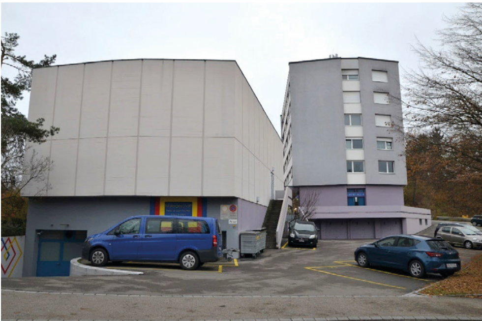
Kino «Claudia», links fensterloser Saal des Kinogebäudes (062KINO00400), rechts Wohn- und Geschäftshaus (Vers. Nr. 00400), Ansicht von O, 16.11.2021 (Bild Nr. D100671_17).
