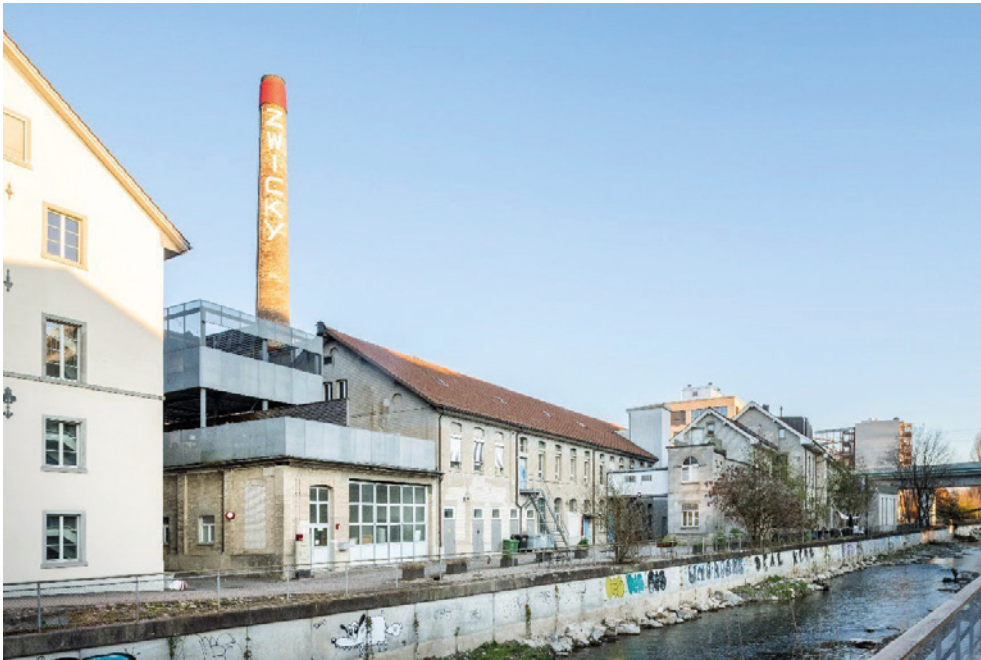
«Zwicky», von links zweite Zwirnerei (Vers. Nr. 00182), ehem. Färberei mit Hochkamin (Vers. Nr. 00185), Passerelle (069PASS00185), alte Färberei (Vers. Nr. 00190), Ansicht von SW, 06.12.2022 (Bild Nr. D100688_25).
