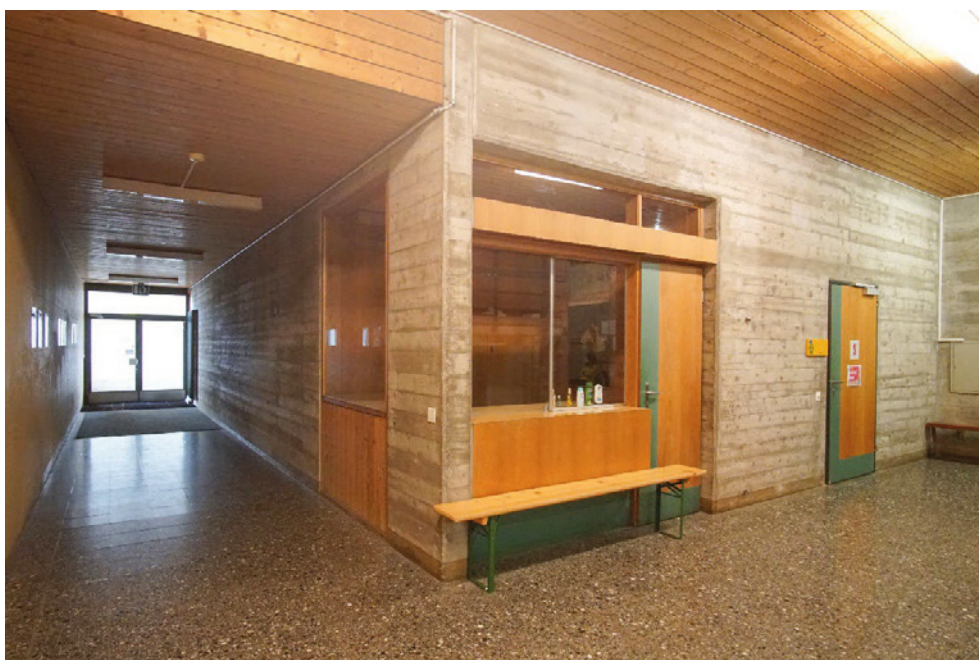
Schulanlage Feldhof, Turn- und Schwimmhalle (Vers. Nr. 01045), Bademeister-/Abwärtsloge im UG, 09.11.2021 (Bild Nr. D104015_56).
