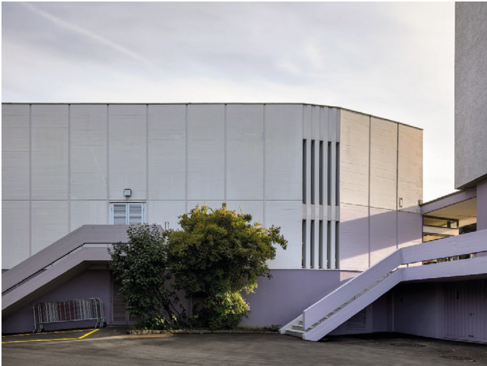
Kino «Claudia», Kinogebäude (062KINO00400) mit Nottreppe und Lichtschlitzen, rechts Betontreppe zwischen Platz und tieferliegendem Niveau, Ansicht von N, 26.09.2019 (Bild Nr. D100671_42).
