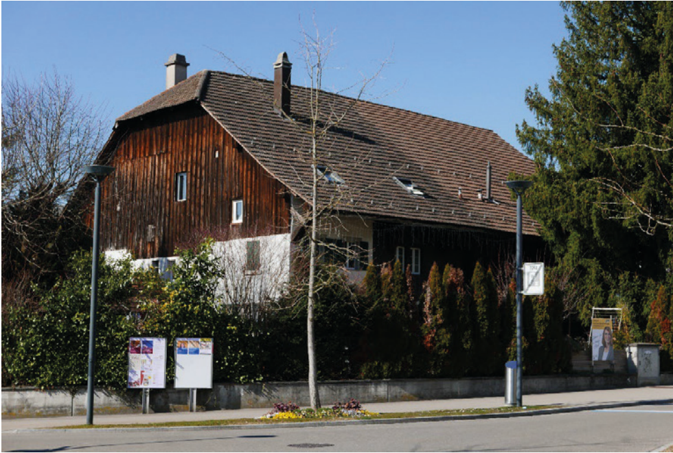
Vielzweckbauernhaus, mit einem Viertelwalmdach eingedeckte Südseite, Ansicht von SO, 04.03.2022 (Bild Nr. D100583_88).
