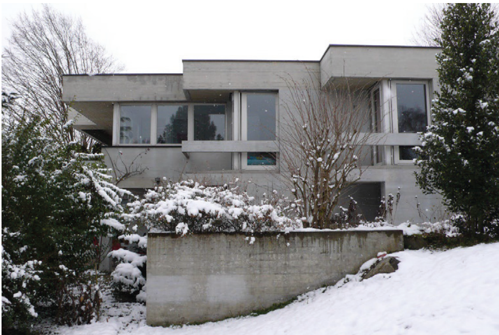
Wohnhaus Schader, Ansicht von O, 21.01.2011 (Bild Nr. D100594_09).
