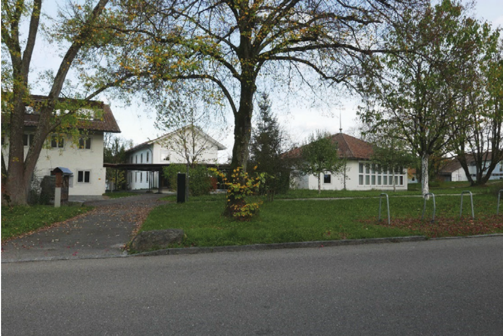
Schulanlage Halden, Zugang von der Oberhauserstrasse her (066UMGEBU00743), links Turnhallegebäude (066TURN00743), Sekundarschulhaus Trakt A (Vers. Nr. 00743), davor Pausenplatz unter Dach (066PAUSEN00743), rechts Singsaal (066SING00743), Ansicht von NW, 01.11.2022 (Bild Nr. D100693_30).
