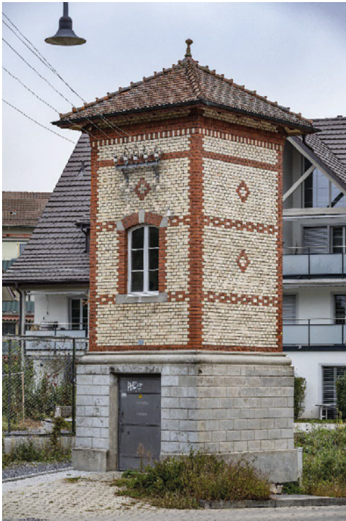
Transformatorstation Im Kirchbrunnen, Ansicht von SW, 30.09.2020 (Bild Nr. D102384_53).
