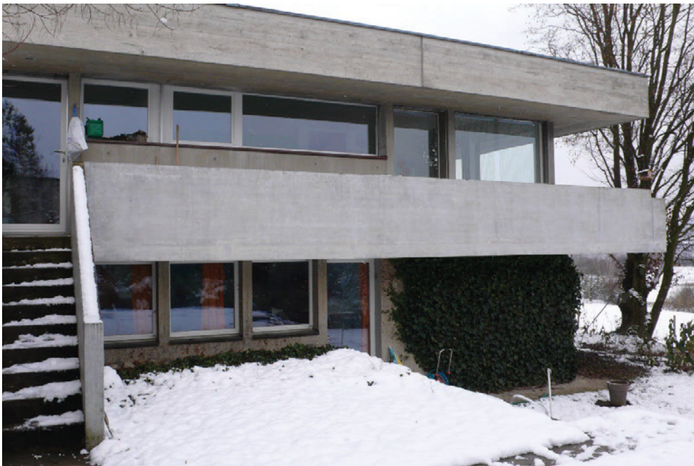
Wohnhaus Schader, Ansicht von W, 21.01.2011 (Bild Nr. D100594_10).
