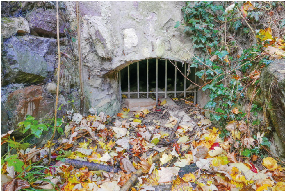
Mühle Maur, Unterwasserkanal (195WR-g0090-05), Detail des Abflusses aus der Sägerei (Vers. Nr. 00288), Ansicht von N, 05.11.2021 (Bild Nr. D101361_61).
