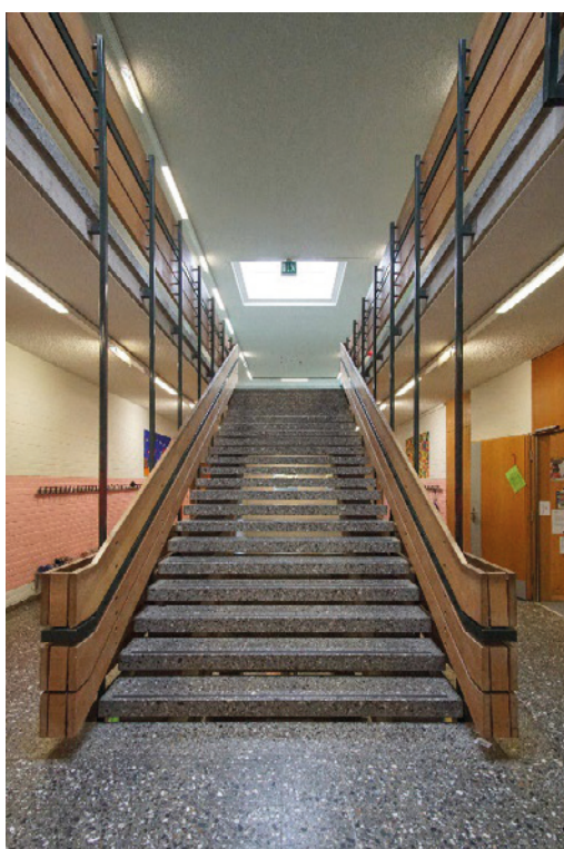
Schulanlage Feldhof, Schulhaus (Vers. Nr. 01044), Nordtrakt, Treppe vom 1. ins 2. OG, 09.11.2021 (Bild Nr. D104015_25).
