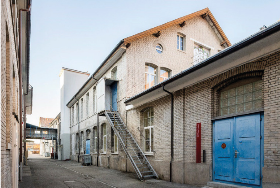
«Zwicky», von links alte Färberei (Vers. Nr. 00190), Passerelle (069PASS00185), ehem. Färberei (Vers. Nr. 00185), Ansicht von S, 06.12.2022 (Bild Nr. D100687_94).
