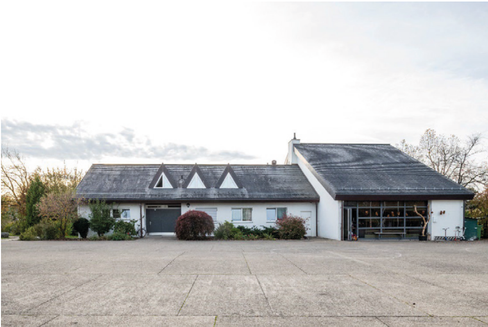
Ref. Kirchenanlage Halden, ref. Pfarrhaus (Vers. Nr. 00024), Ansicht von NO, 07.11.2022 (Bild Nr. D100676_37).
