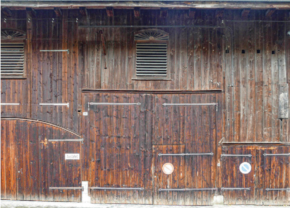
Mühle Maur, Mühlescheune (Vers. Nr. 00297), Hauptfassade mit Scheuentoren und Lüftungsöffnungen, Ansicht von SO, 05.11.2021 (Bild Nr. D101361_62).
