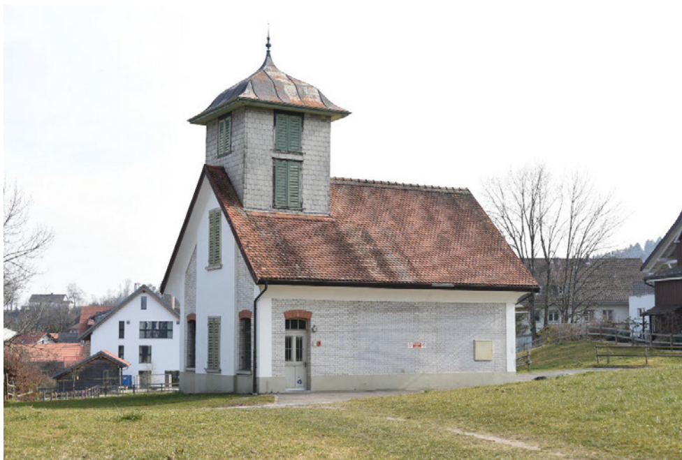
Ländliche Versorgungsbauten, Spritzenhaus (Vers. Nr. 00260), Ansicht von NW, 17.03.2022 (Bild Nr. D101104_61).
