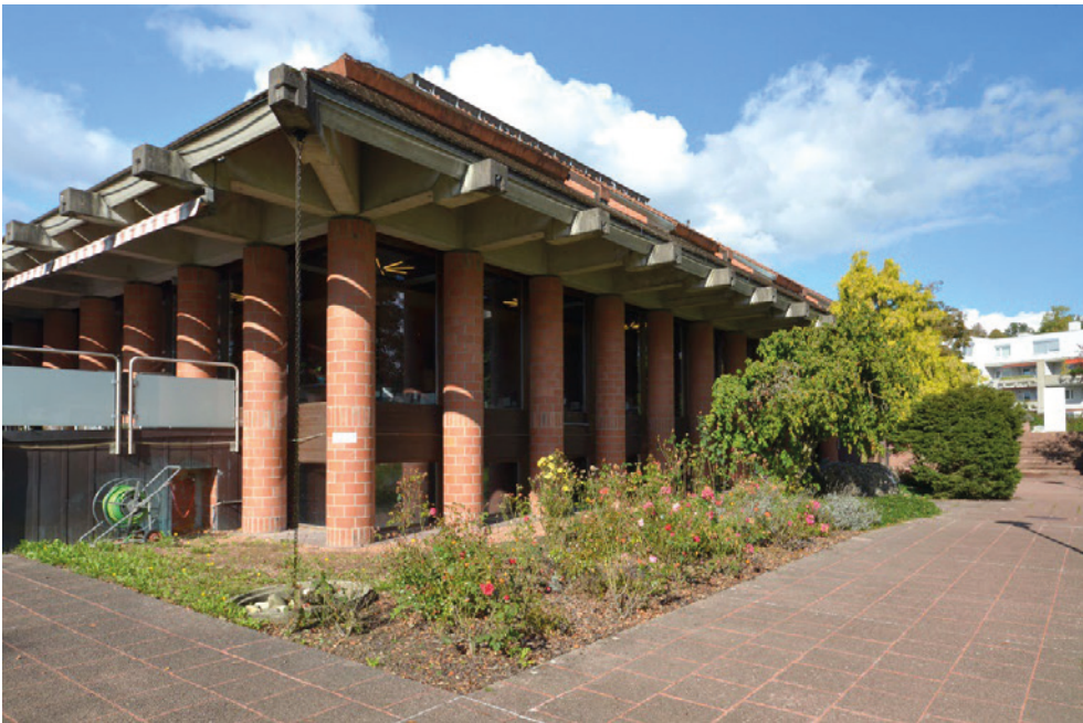
«Wallberg», Restaurant und Hotel mit Saal (Vers. Nr. 00439), Säulenarchitektur und offene Dachunterseite, Ansicht von S, 13.10.2021 (Bild Nr. D101372_53).
