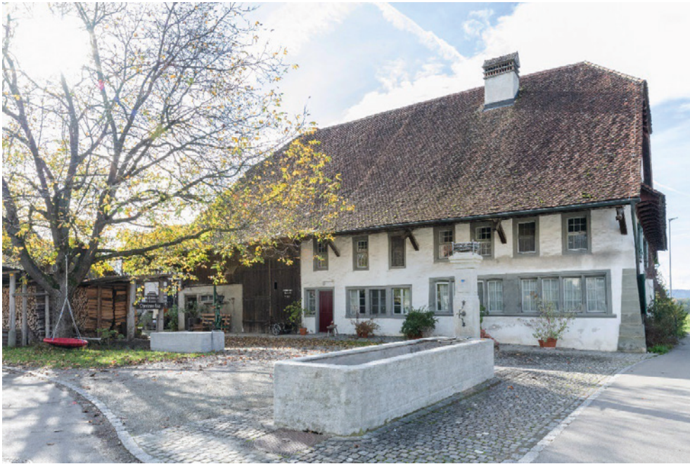
«Katzentrüthof», «Kleinjogg-Haus» (Vers. Nr. 00930), Ostfassade mit Stubenreihenfenstern im EG und Kammerfenstern im OG, davor Hofplatz (097HOF00930) mit Nussbaum und Brunnen, Ansicht von O, 01.11.2022 (Bild Nr. D102651_92).
