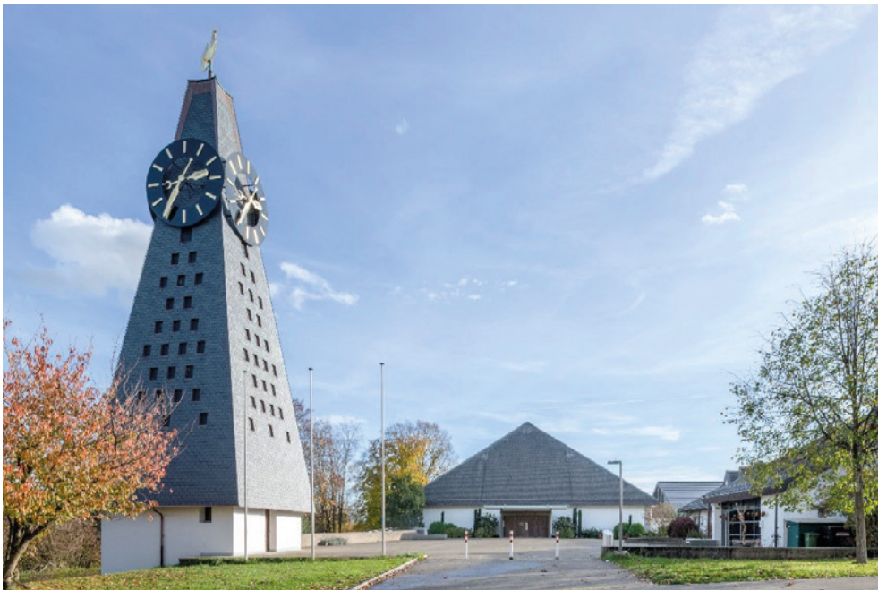
Ref. Kirchenanlage Halden, Ansicht von NW, 07.11.2022 (Bild Nr. D100676_23).
