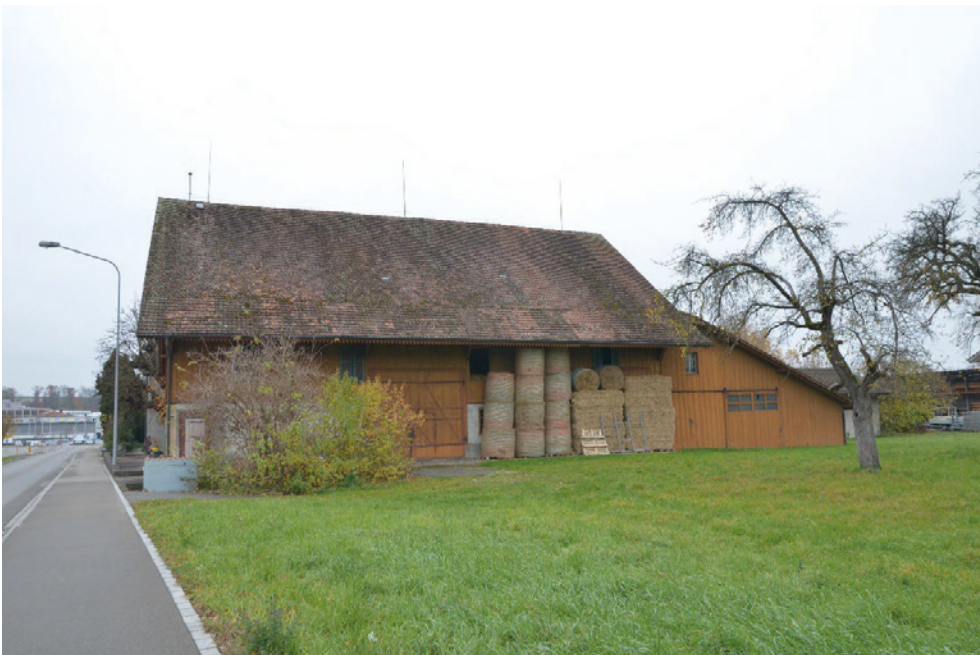
«Doktorhaus», Scheune (Vers. Nr. 00140), Ansicht von NO, 16.11.2021 (Bild Nr. D102651_43).
