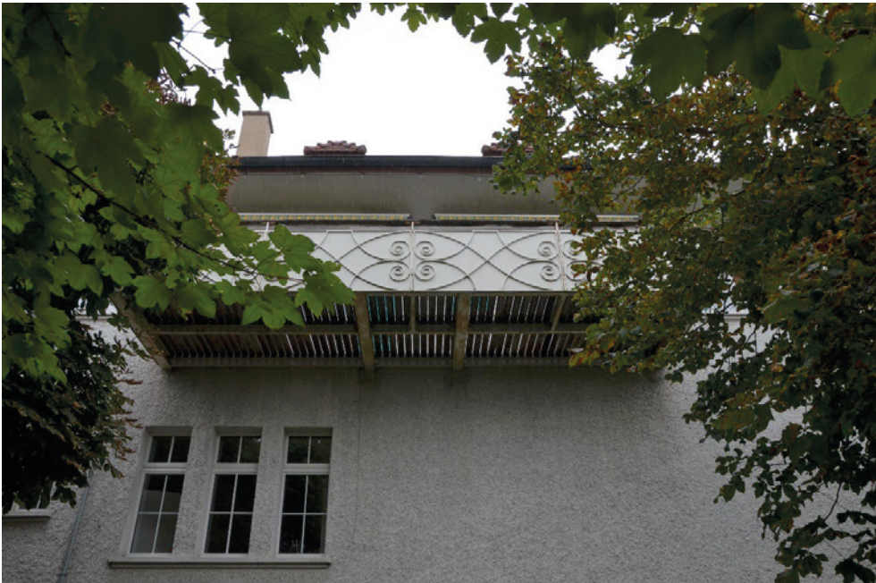
Ehem. Schulhaus, Nordwestfassade mit Balkon mit Jugendstilzierformen an der Brüstung, 15.09.2021 (Bild Nr. D101386_13).
