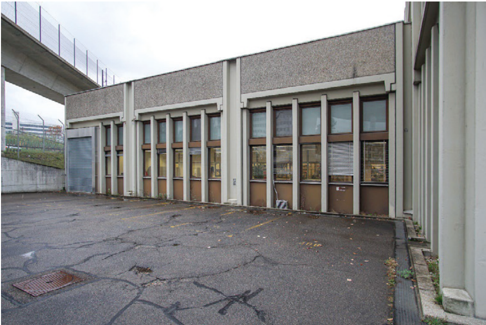
Ehem. Zentrallager, Werkstatttrakt, Nordostfassade, Ansicht von O, 22.11.2022 (Bild Nr. D104015_96).
