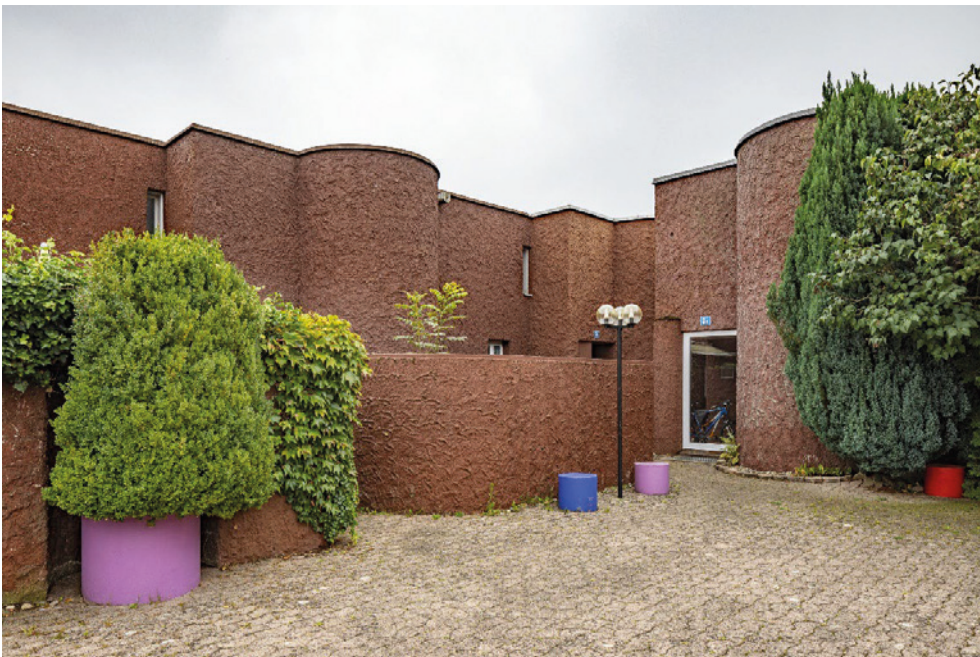
Wohnüberbauung Heuelstrasse, Hof (097UMGEBU00001), von links Reiheneinfamilienhäuser Vers. Nr. 00009–00011, Ansicht von NW, 30.09.2020 (Bild Nr. D102384_39).
