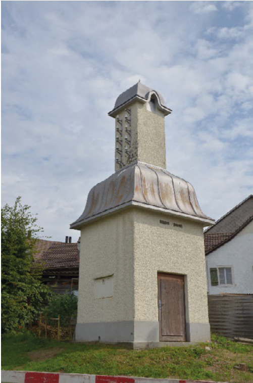
Transformatorstation Gutenswil, Ansicht von S, 15.09.2021 (Bild Nr. D101361_43).
