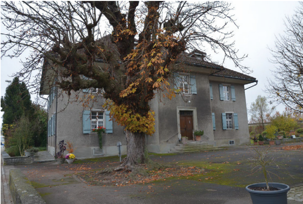
«Doktorhaus», Wohnhaus (Vers. Nr. 00139), Ansicht von NO, 16.11.2021 (Bild Nr. D102651_48).
