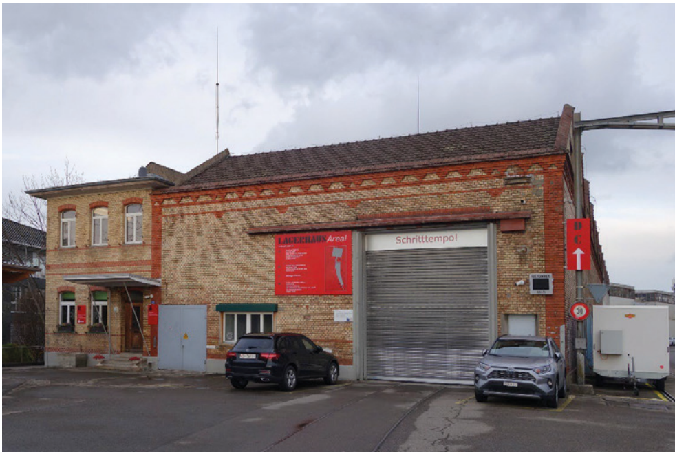
Fabrikhallen der ehem. Eisenbaugesellschaft Zürich, Montagehalle mit seitlich angebautem Verwaltungsgebäude, Ansicht von W, 05.12.2022 (Bild Nr. D101361_91).
