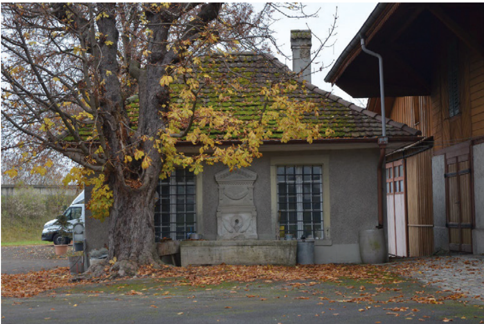
«Doktorhaus», Waschhaus (Vers. Nr. 00153), Ansicht von SO, 16.11.2021 (Bild Nr. D102651_47).
