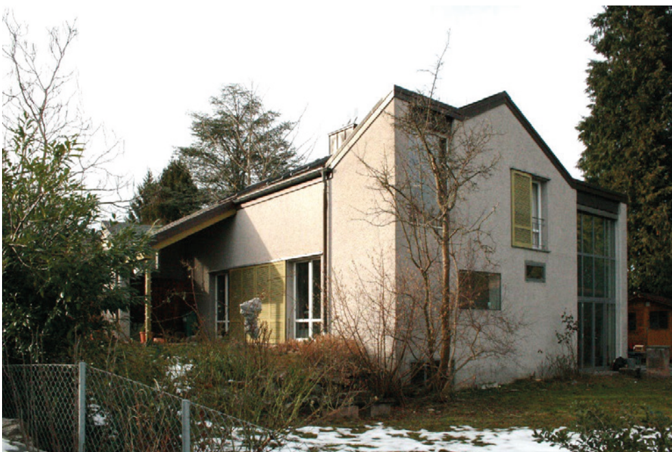
Atelierhaus, Süd- und Ostfassade, 27.01.2016 (Bild Nr. D101104_44).
