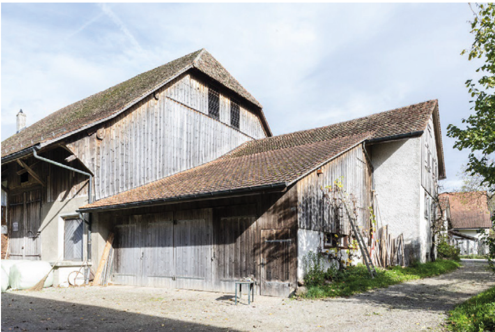
«Katzentrüthof», «Kleinjogg-Haus» (Vers. Nr. 00930), Ökonomieteil mit angebautem Speicher und Traktorgarage, Ansicht von SW, 01.11.2022 (Bild Nr. D102651_88).
