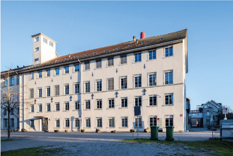
«Zwicky», von links erste Zwirnerie (069ZWIRN00180), zweite Zwirnerie (Vers. Nr. 00182), im Hintergrund alte Färberei (Vers. Nr. 00190), Ansicht von NW, 06.12.2022 (Bild Nr. D100687_84).
