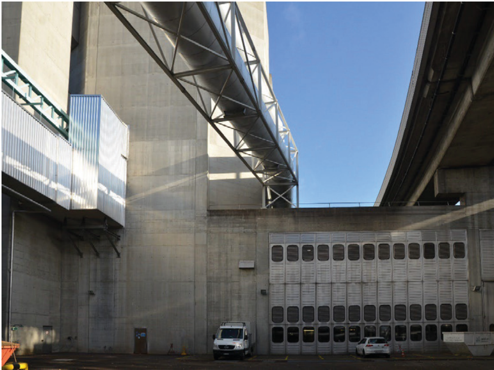
Heizkraftwerk Aubrugg, Süd Hof, links Kesselhaus (069KESSEL01953), rechts Maschinenhalle (069HALLE01953) mit den auswechselbaren modularen Aluminiumpaneelen, Ansicht von SW, 16.10.2017 (Bild Nr. D100580_69).
