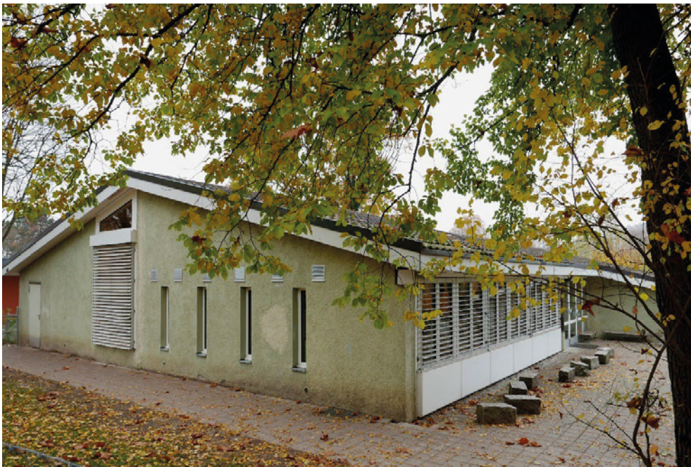
Schulanlage Halden, Doppelkindergarten (Vers. Nr. 00998), Ansicht von SO, 02.11.2015 (Bild Nr. D100592_55).
