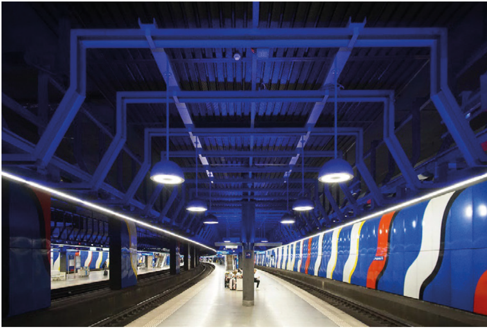
Bahnhof Zürich Flughafen, Perronanlage (062PERRON02732), Perron 1, Blick nach SW, 26.10.2022 (Bild Nr. D104016_03).
