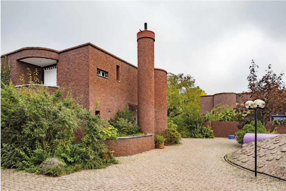
Wohnüberbauung Heuelstrasse, Hof (097UMGEBU00001), vorne ehem. Gemeinschaftshaus mit Atelierwohnung (Vers. Nr. 00026), hinten Reiheneinfamilienhaus Vers. Nr. 00024, Ansicht von SW, 30.09.2020 (Bild Nr. D102384_41).
