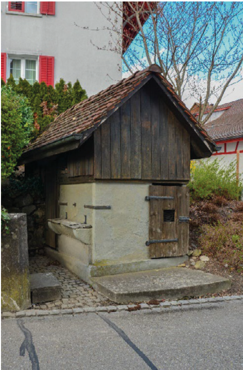
Schweinestall, Ansicht von O, 06.04.2021 (Bild Nr. D102651_36).
