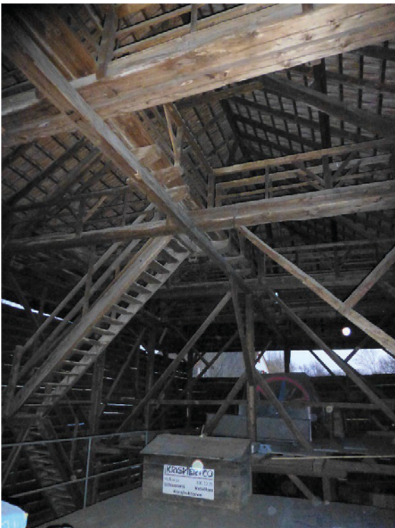
Trocknungsgebäude, Treppenanlage und Laufgänge im Dach, die zu den Tuchhängevorrichtungen über den Aussenwänden führen, 17.12.2015 (Bild Nr. D100583_57).
