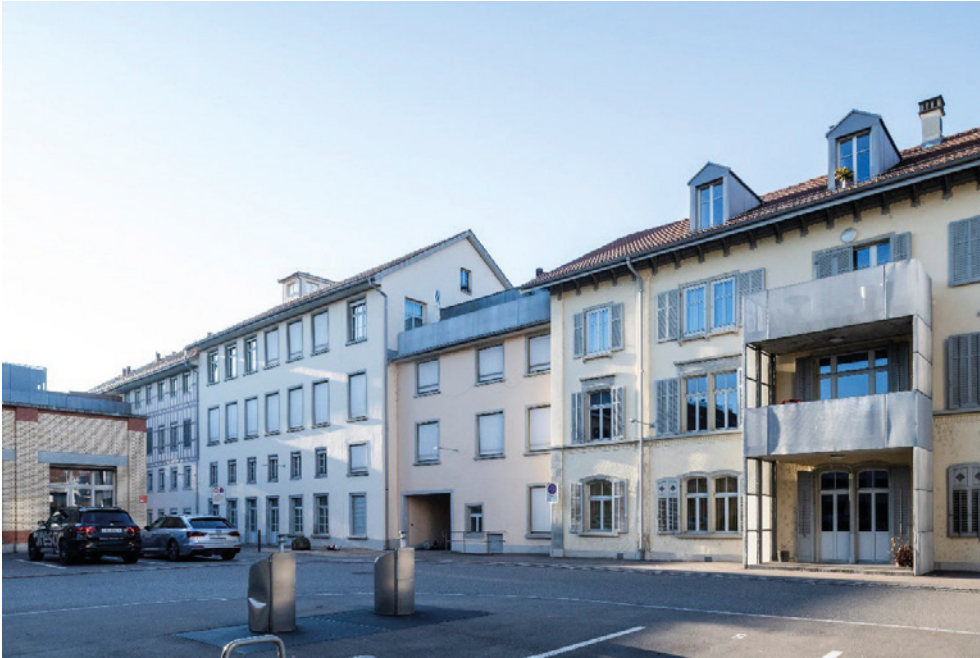
«Zwicky», von links ehem. Zwirnerie (Vers. Nr. 00191), zweite Zwirnerie (Vers. Nr. 00182), erste Zwirnerie (069ZWIRN00180), ehem. Wohnhaus (069WOHN00180), ehem. Fabrikantenwohnhaus «Zum Neugut» (Vers. Nr. 00180), Ansicht von O, 06.12.2022 (Bild Nr. D100687_76).
