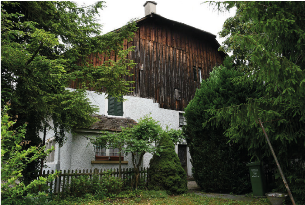
Vielzweckbauernhaus, Südfassade mit Vorbau von 1924 und Viertelwalm, Ansicht von SW, 09.06.2017 (Bild Nr. D100583_85).
