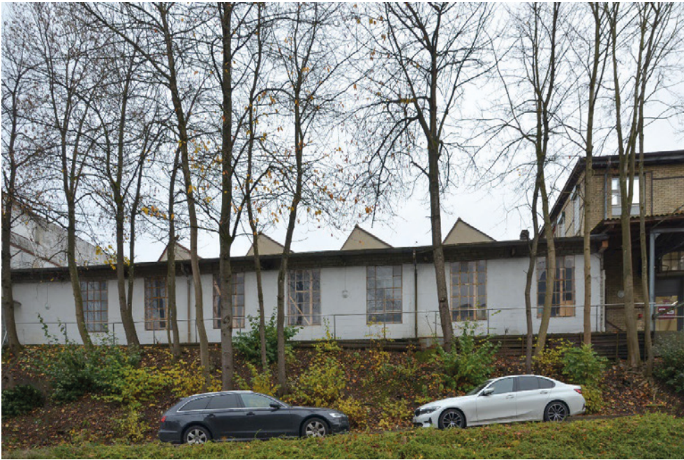
Fabrikhallen der ehem. Eisenbaugesellschaft Zürich, Anbau, Ansicht von N, 17.11.2021 (Bild Nr. D101361_96).
