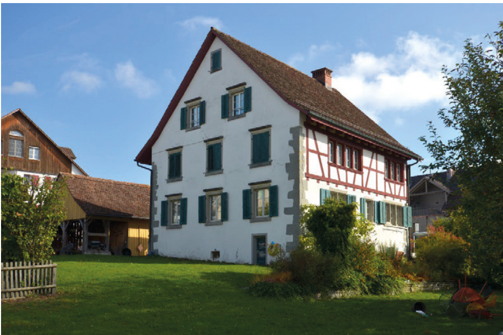
Ref. Pfarrliegenschaft, Pfarrhaus (Vers. Nr. 00200), links Holzschopf am ehem. Waschhaus (Vers. Nr. 00199), Ansicht von SW, 31.10.2021 (Bild Nr. D101385_05).
