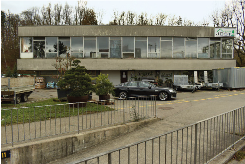
Ehem. Swissair-Lehrlingswerkstatt, Ansicht von NW, 11.01.2023 (Bild Nr. D100693_20).
