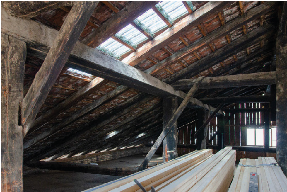
Ehem. Vielzweckbauernhaus, Dachtragkonstruktion mit bis unter das Dach reichenden Innenständern und verblatteten Sperrafen, Blick nach NO, 19.10.2022 (Bild Nr. D100694_05).
