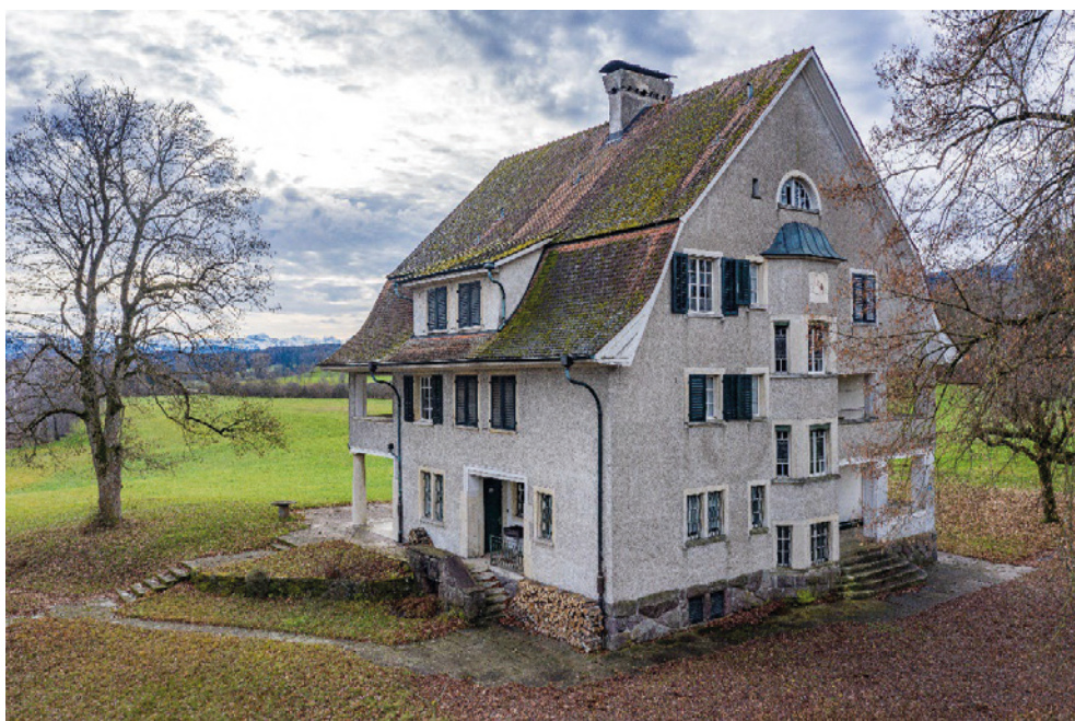
Landsitz Fluh, Landhaus (Vers. Nr. 00372), Nordwest- und Nordostfassade, Umgebung (195UMGEBU00372) mit Architekturgarten vor dem Haus, Ansicht von N, 03.12.2020 (Bild Nr. D101971_69).
