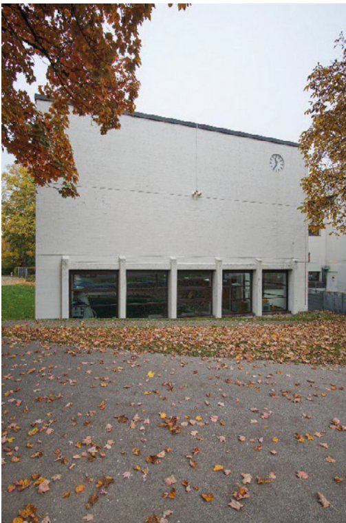
Schulanlage Feldhof, Turn- und Schwimmhalle (Vers. Nr. 01045), Ansicht von S, 09.11.2021 (Bild Nr. D104015_46).
