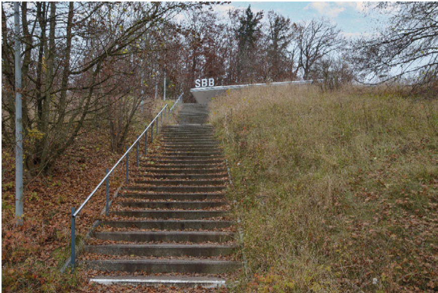
Haltestelle Kloten Balsberg, ehem. Kloten Flughafen, Treppe von der Balz-Zimmermann-Strasse hinauf zur Haltestelle, Ansicht von NW, 23.11.2021 (Bild Nr. D104016_55).
