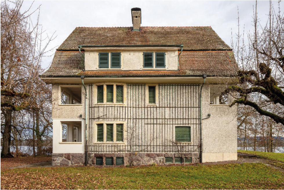
Landsitz Fluh, Landhaus (Vers. Nr. 00372), Südwestfassade mit Rundrisalit, Holzspalier und Lauben, 03.12.2020 (Bild Nr. D101971_28).
