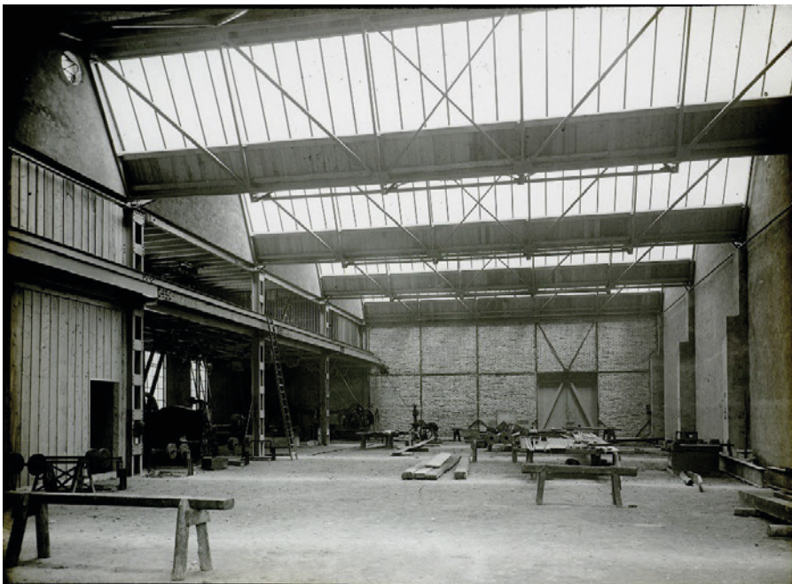
Fabrikhallen der ehem. Eisenbaugesellschaft Zürich, Innenaufnahme der Montagehalle, Blick nach O, Bild: ETH-Bibliothek Zürich, Bildarchiv, Dia_258-011, 01.01.1902 (Bild Nr. D101361_82).
