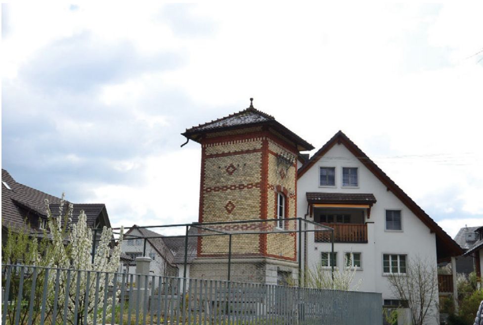
Transformatorstation Im Kirchbrunnen, Ansicht von NW, 06.04.2021 (Bild Nr. D101359_01).
