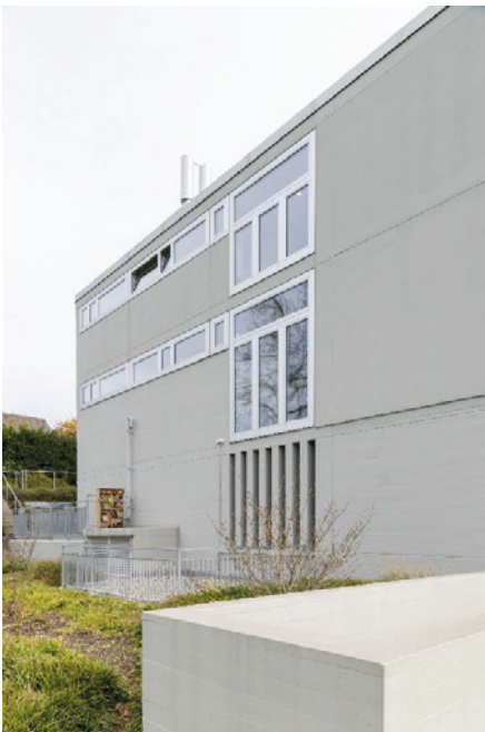
Schulanlage Hinterwiden, Schultrakt D mit Abwartswohnung (Vers. Nr. 01367), Ansicht von SW, 02.11.2022 (Bild Nr. D101362_41).
