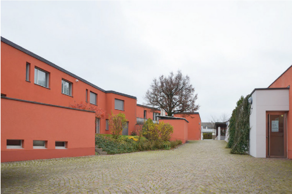
Kath. Kirchenzentrum Kloten, links Pfarreizentrum (Vers. Nr. 01732), rechts Seiteneingang zur Nebenkirche (062NEBKIR01731), im Vordergrund gepflasterter Kirchplatz und Weg (062UMGEBU01731), Ansicht von SW, 23.11.2021 (Bild Nr. D102651_67).
