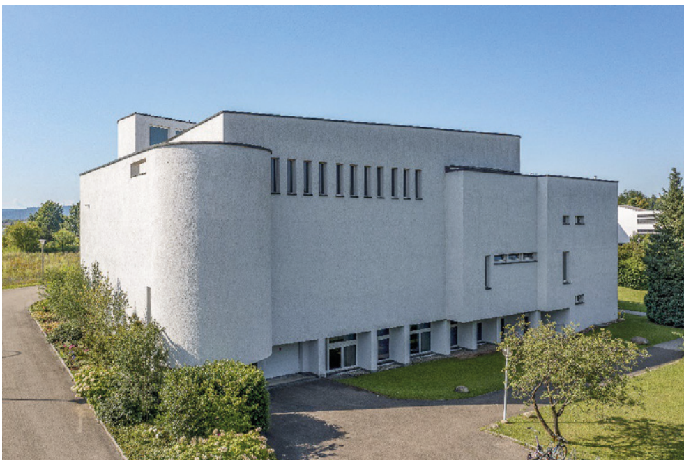
Kath. Kirche St. Peter, unten Pfarrsaal, oben Kirchensaal mit Fensterschlitz, links halbrunde Andachtsnische, rechts Tageskirche im abgetreppten Gebäudeteil, Ansicht von NO, 06.07.2022 (Bild Nr. D102390_19).
