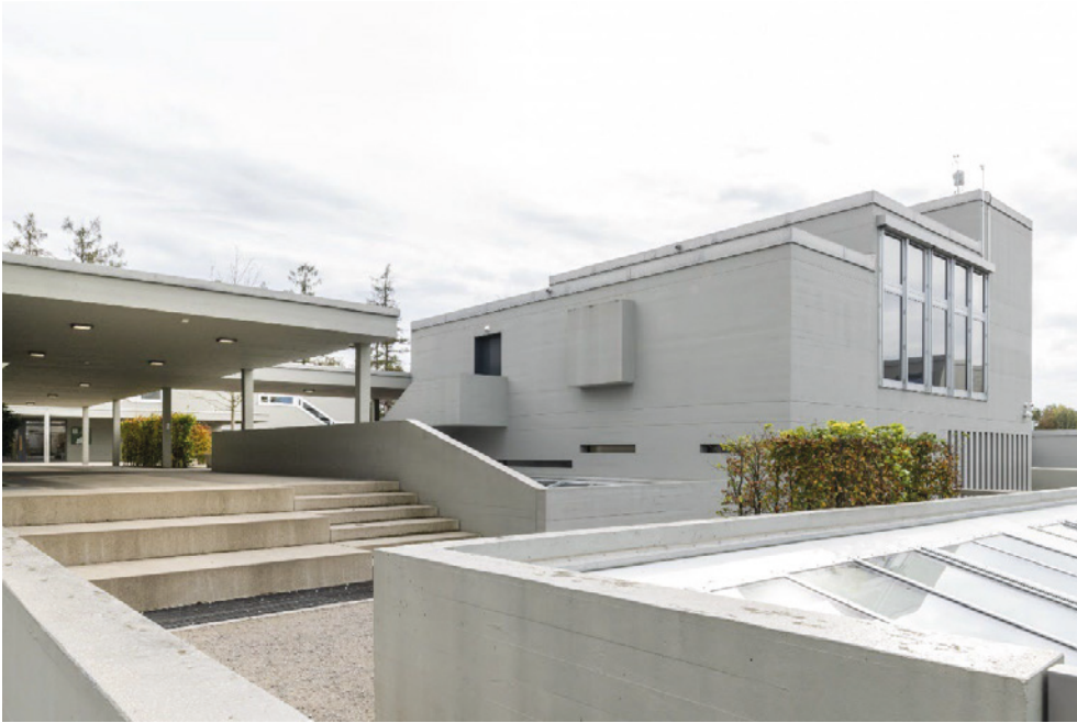
Schulanlage Hinterwiden, Singsaaltrakt (Vers. Nr. 01366) und Teil des Pausenhofs (062PAUSEN01368), Ansicht von NW, 02.11.2022 (Bild Nr. D101362_40).
