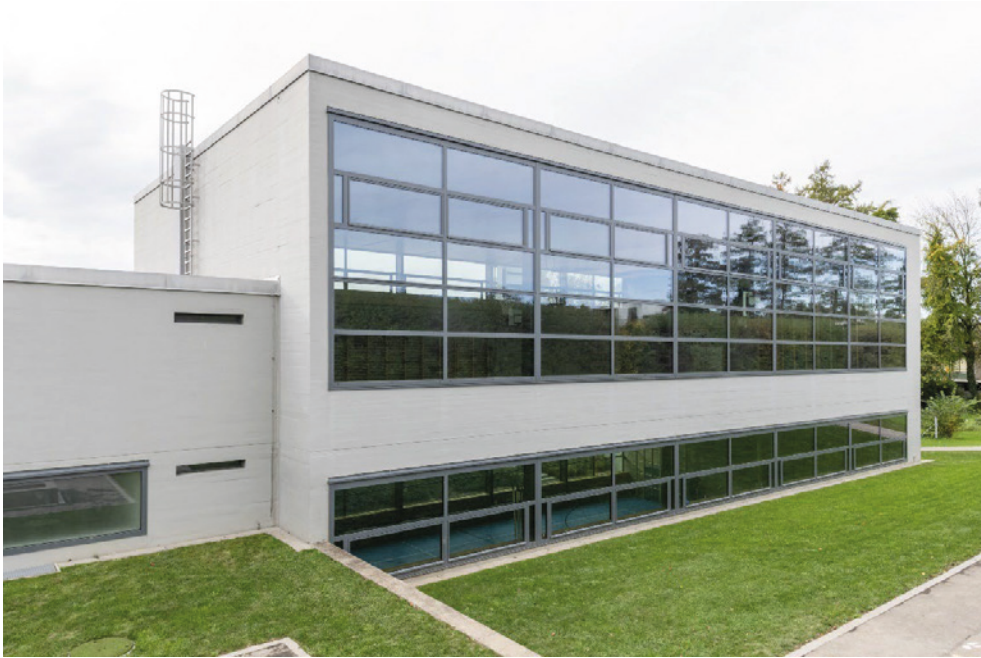
Schulanlage Hinterwiden, Turnhallentrakt (Vers. Nr. 01369), Ansicht von NO, 02.11.2022 (Bild Nr. D101362_23).
