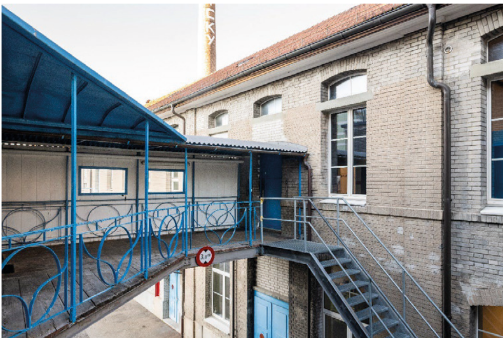
«Zwicky», Passerelle (069PASS00185) zur ehem. Färberei (Vers. Nr. 00185), Ansicht von S, 06.12.2022 (Bild Nr. D100688_08).
