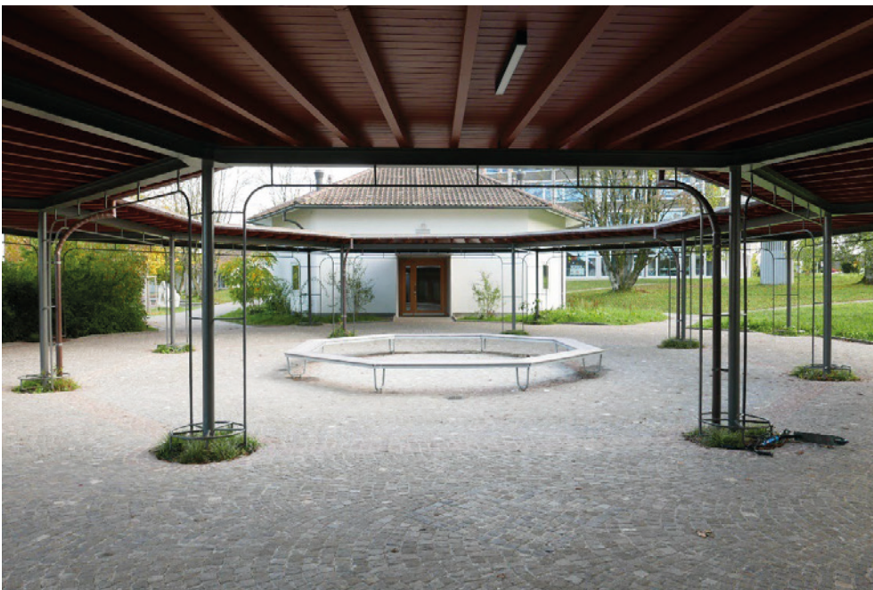
Schulanlage Halden, Pausenplatz unter Dach (066PAUSEN00743), im Hintergrund Singsaal (066SING00743), Ansicht von NW, 01.11.2022 (Bild Nr. D100693_37).
