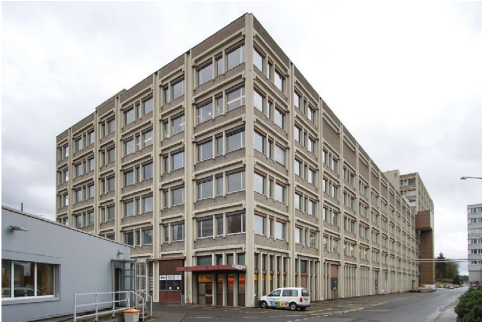
Ehem. Zentrallager, Büro- und Verwaltungstrakt, Ansicht von N, 22.11.2022 (Bild Nr. D104015_91).
