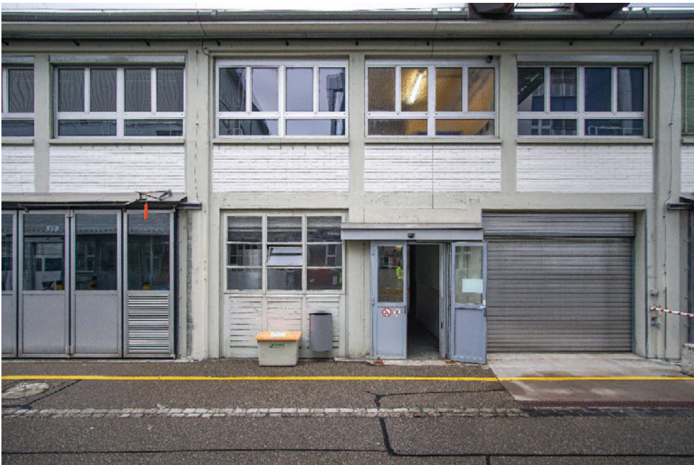
Bogenhangar, südöstlicher Werkstatt- und Magazintrakt, Ansicht von SO, 29.11.2022 (Bild Nr. D102652_64).
