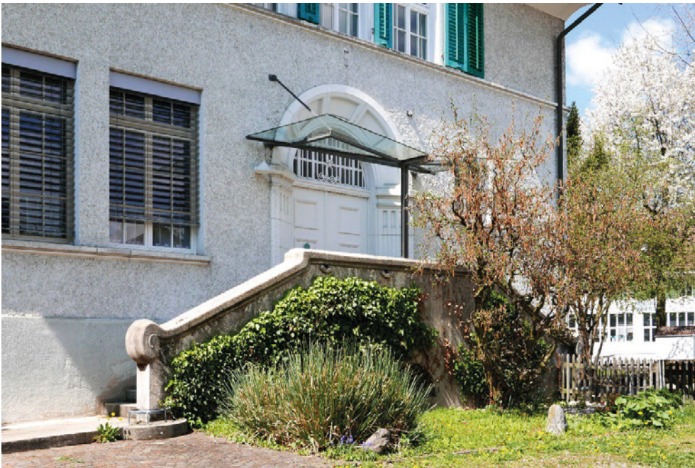
Ehem. Schulhaus, Haupteingang an der Südostfassade, 19.04.2016 (Bild Nr. D101386_06).
