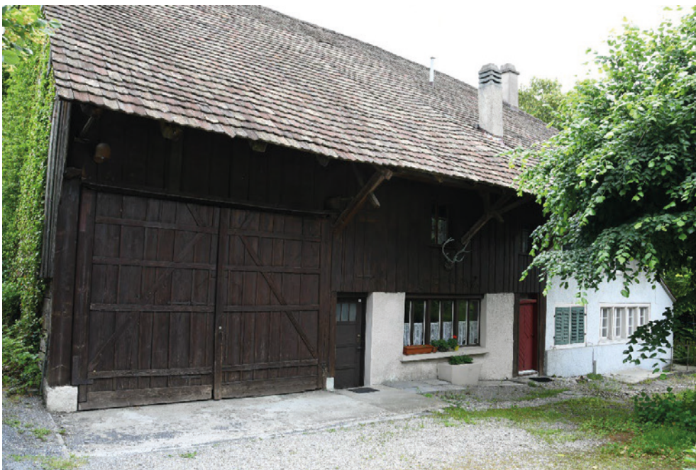
Vielzweckbauernhaus, Hausteil West (Vers. Nr. 00883), Tenn, ehem. Stall, Wohnteil, Ansicht von NW, 09.06.2017 (Bild Nr. D100583_84).
