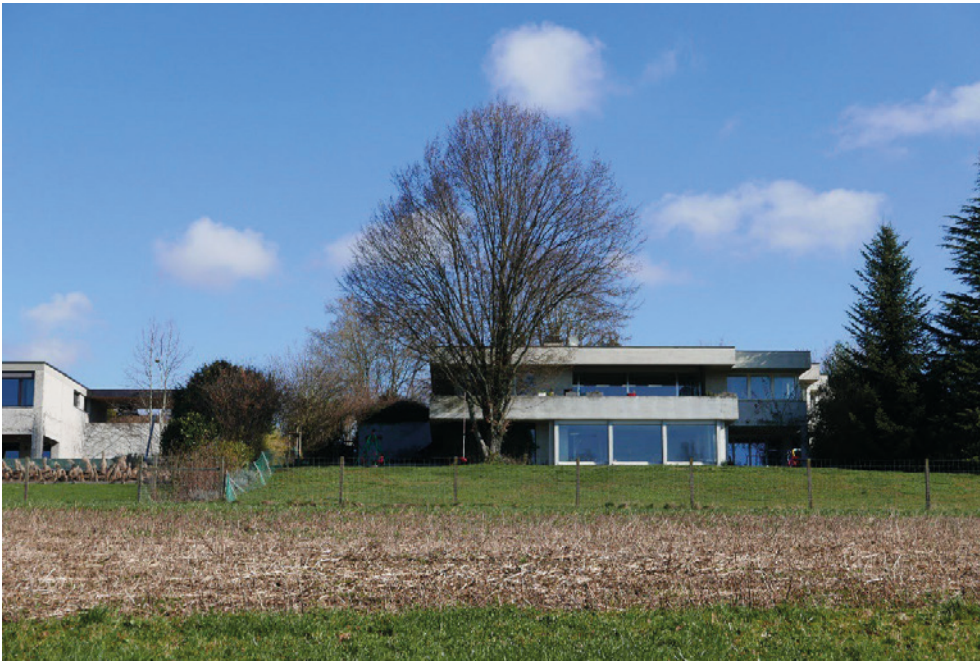
Wohnhaus Schader, Ansicht von S, 07.03.2016 (Bild Nr. D100594_47).
