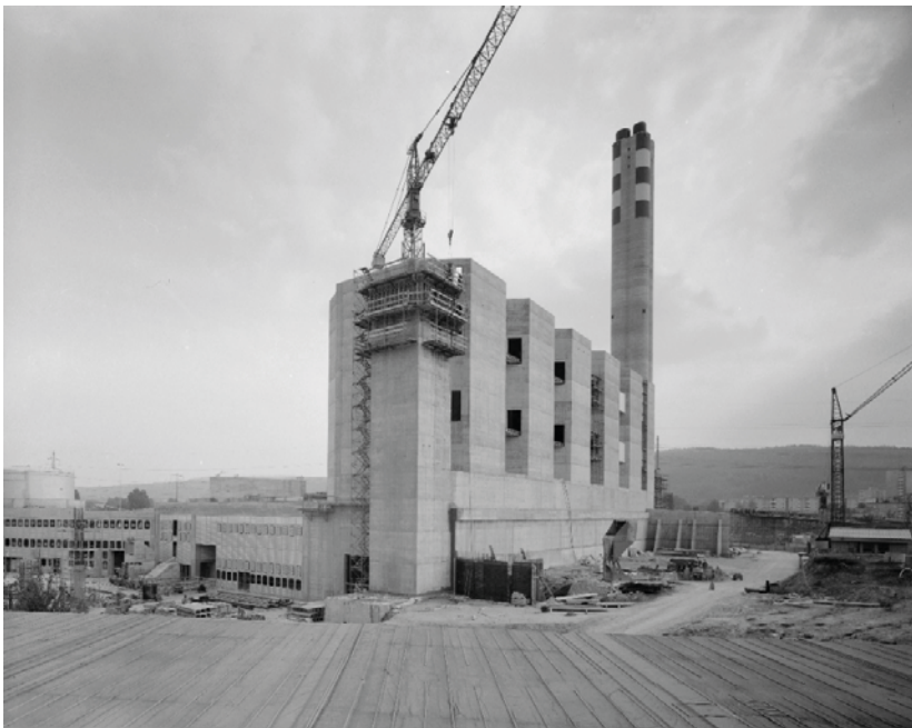
Heizkraftwerk Aubrugg, v. l. n. r. Dienstgebäude (Vers. Nr. 01953), Maschinenhalle (069HALLE01953), Kesselhaus (069KESSEL01953), Hochkamin (069KAMIN01953), rechts ist an der Fassade des Kesselhauses die Schalung für die Stützmauern zur Terrainauffüllung sichtbar, Ansicht von N, 16.09.1977 (Bild Nr. U42735).
