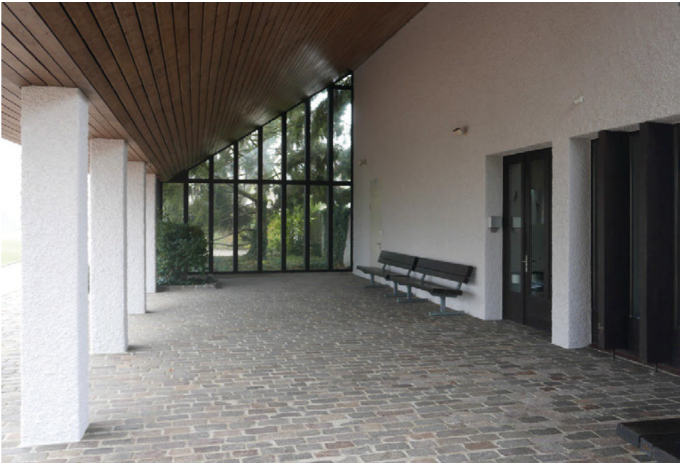
Neuer Friedhof Maur, Friedhofgebäude (Vers. Nr. 00446), offene Vorhalle mit Dach und gleicher Porphyrfpflasterung wie der Besammlungsplatz, Ansicht von SO, 11.11.2021 (Bild Nr. D101104_11).
