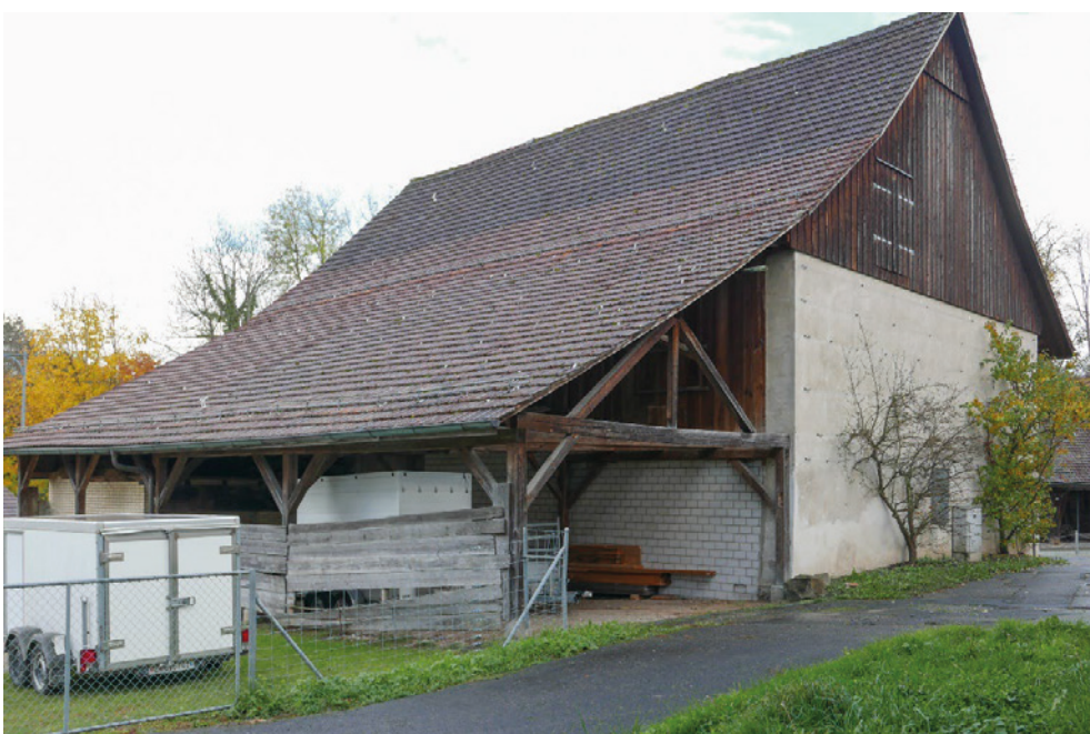
Mühle Maur, Mühlescheune (Vers. Nr. 00297), Ansicht von W, 05.11.2021 (Bild Nr. D101361_58).
