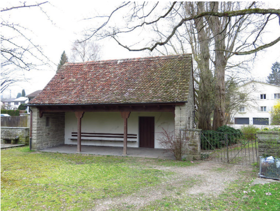
Friedhof Steinreben, Friedhofgebäude (Vers. Nr. 00454), offene Halle mit Balkendecke und Holzstützen mit Zierschnitt, Ansicht von SO, 24.03.2017 (Bild Nr. D100586_04).
