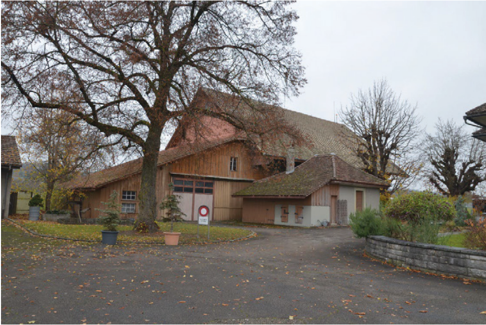
«Doktorhaus», Scheune (Vers. Nr. 00140) und Waschhaus (Vers. Nr. 00153), Ansicht von W, 16.11.2021 (Bild Nr. D102651_45).
