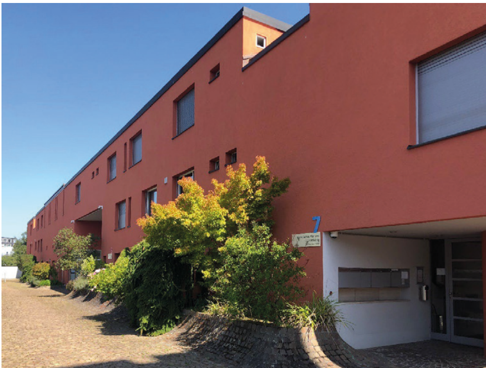
Kath. Kirchenzentrum Kloten, Pfarrezentrum (Vers. Nr. 01732), gepflasterter Weg mit Rabatte (062UMGEBU01731), Ansicht von SW, 28.08.2024 (Bild Nr. D100696_51).
