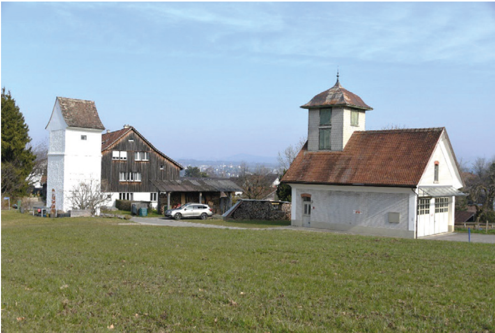
Ländliche Versorgungsbauten, Ansicht von W, links ehem. Transformatorstation «Maur-Dorf» (Vers. Nr. 00261), rechts Spritzenhaus (Vers. Nr. 00260), 08.03.2022 (Bild Nr. D101104_59).
