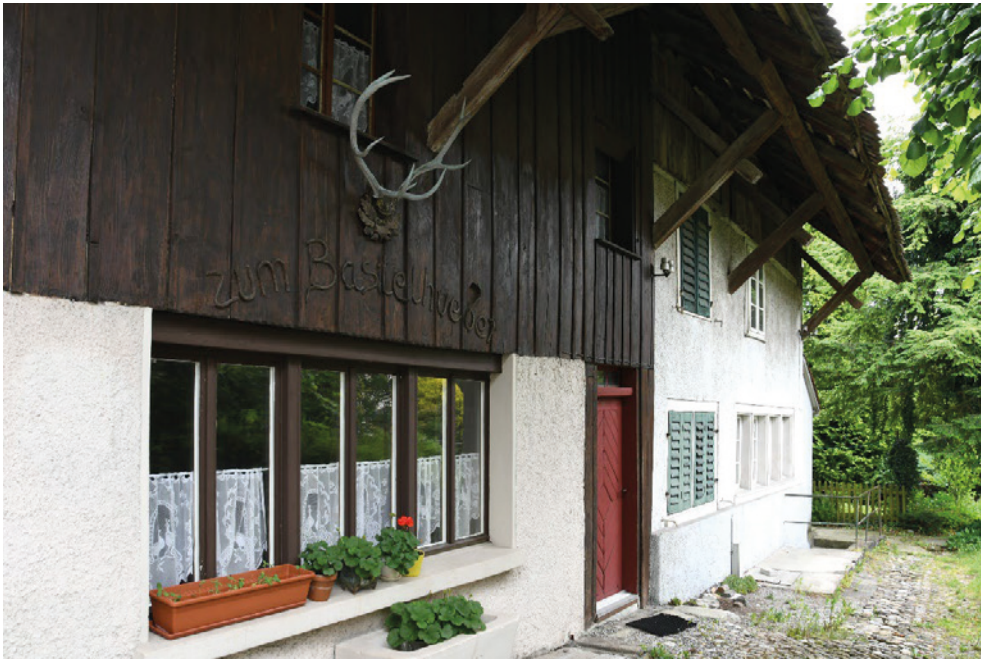
Vielzweckbauernhaus, Hausteil West (Vers. Nr. 00883), Trauffassade, von Bughölzern (Streben) mit Zugbändern gestützte Flugpfetten tragen das Vordach, 09.06.2017 (Bild Nr. D100691_79).
