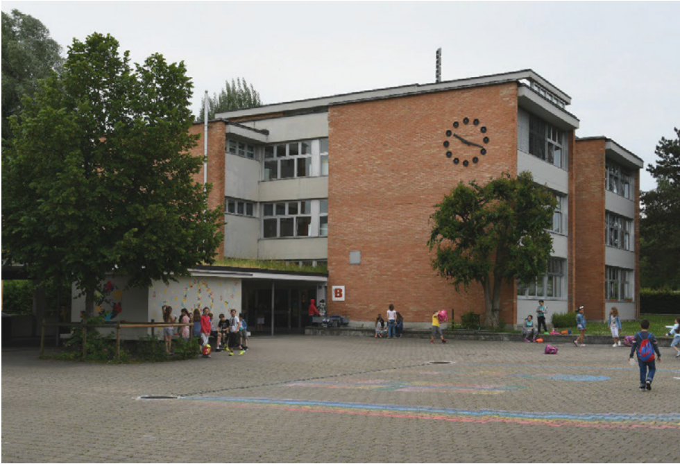
Schulanlage Im Mösli, Schulhaus, Trakt B (Vers. Nr. 01534), links Verbindungsgang (069GANG01534) Ansicht von NW, 09.06.2017 (Bild Nr. D100583_23).
