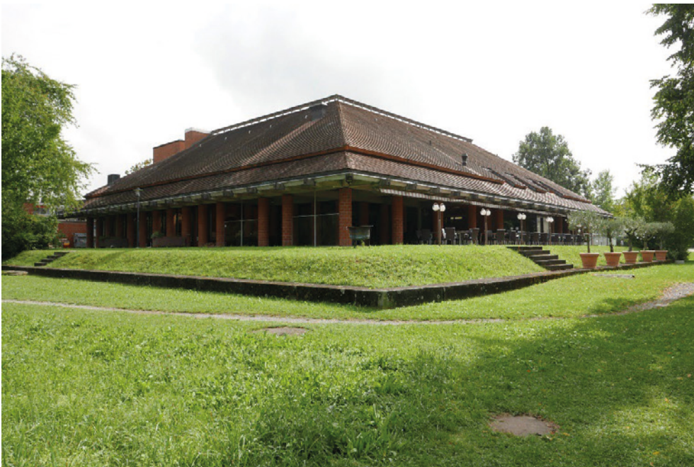
«Wallberg», Restaurant und Hotel mit Saal (Vers. Nr. 00439), Böschung mit Betonschwelle, Ansicht von W, 13.09.2023 (Bild Nr. D101372_60).
