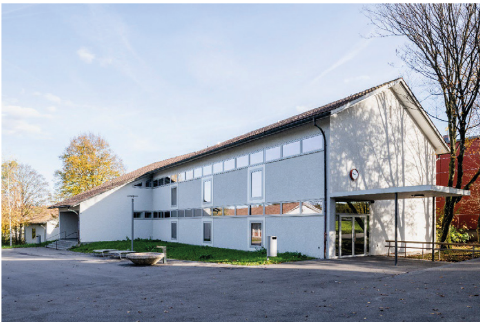
Schulanlage Halden, Sekundarschulhaus Trakt D (Vers. Nr. 00882), Pausen- und Spielplatz mit Rundbrunnen (066UMGEBU00743), Ansicht von SW, 07.11.2022 (Bild Nr. D100693_95).
