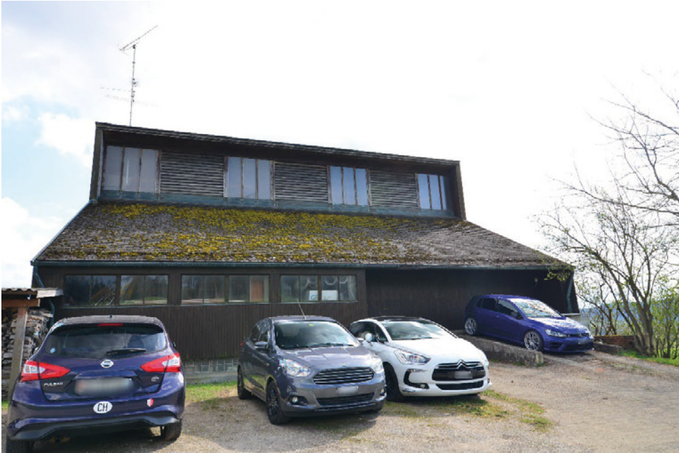
Hof Erlenhölzli, ehem. Vielzweckbauernhaus (Vers. Nr. 00941), Nordfassade, Scheune mit Hocheinfahrt, 14.04.2021 (Bild Nr. D102654_10).
