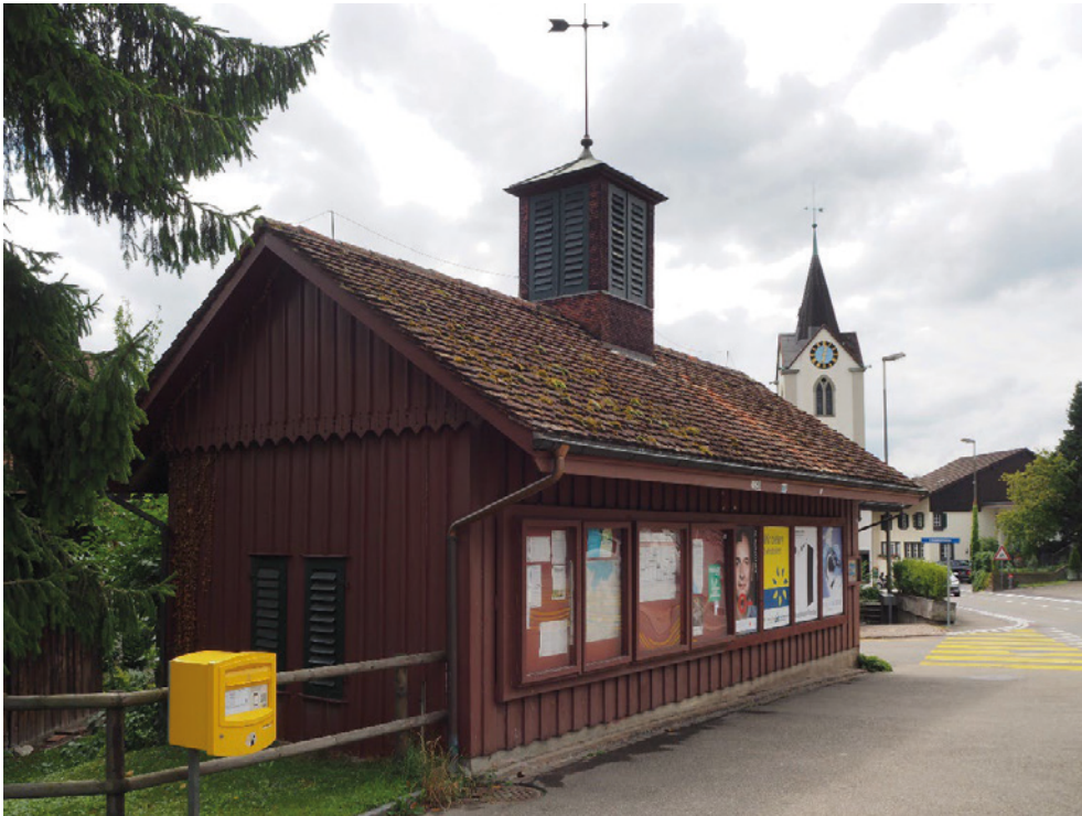
Spritzenhaus, Ansicht von N, 07.03.2022 (Bild Nr. D100583_97).
