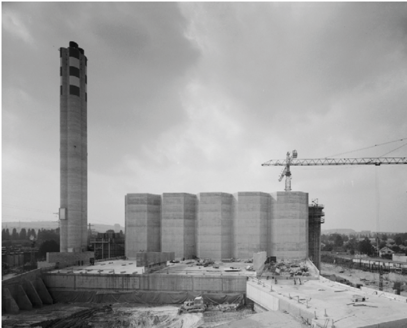
Heizkraftwerk Aubrugg, im Vordergrund Maschinenhalle (069HALLE01953) mit den drei Pfeilerschieben für die Autobahnüberwerfungen und die Grube vor dem Auffüllen des Terrains, rechts das Dach des Dienstgebäudes (Vers. Nr. 01953), Ansicht von SO, 16.09.1977 (Bild Nr. U42734).
