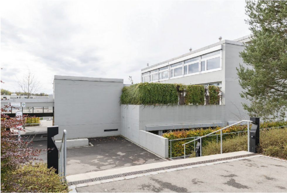
Schulanlage Hinterwiden, Schultrakt D mit Abwartswohnung (Vers. Nr. 01367), Ansicht von NO, 02.11.2022 (Bild Nr. D101362_43).
