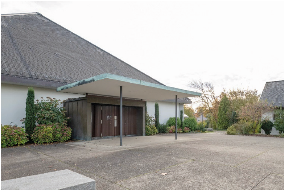
Ref. Kirchenanlage Halden, ref. Kirche (Vers. Nr. 00025), überdachter Eingang und Kirchhofplatz mit Steinplatten (066HOFPLA00025), Ansicht von NO, 07.11.2022 (Bild Nr. D100676_45).
