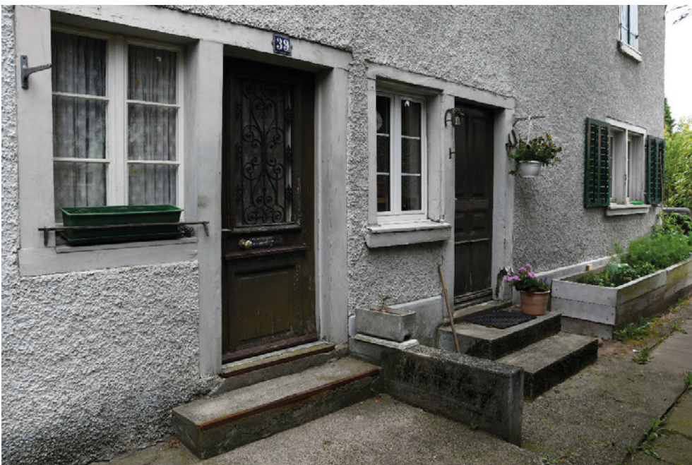
Vielzweckbauernhaus, Südfassade mit Hauseingängen, Ansicht von SW, 09.06.2017 (Bild Nr. D100583_86).
