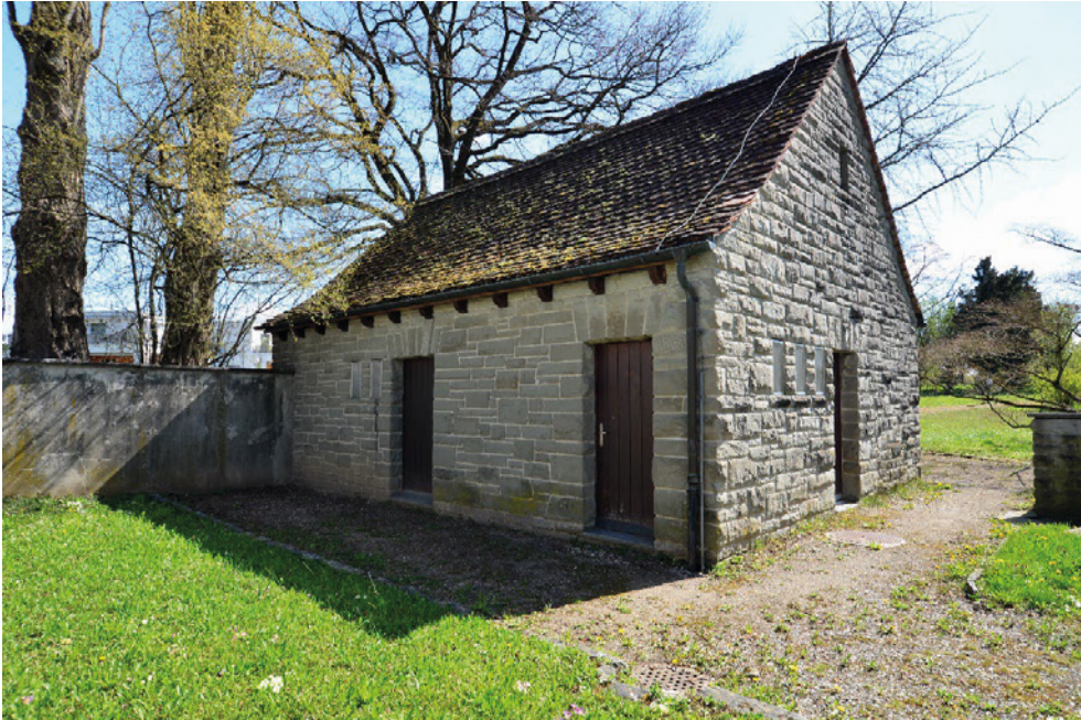
Friedhof Steinreben, Friedhofgebäude (Vers. Nr. 00454), Ansicht von SW, 14.04.2021 (Bild Nr. D100586_10).
