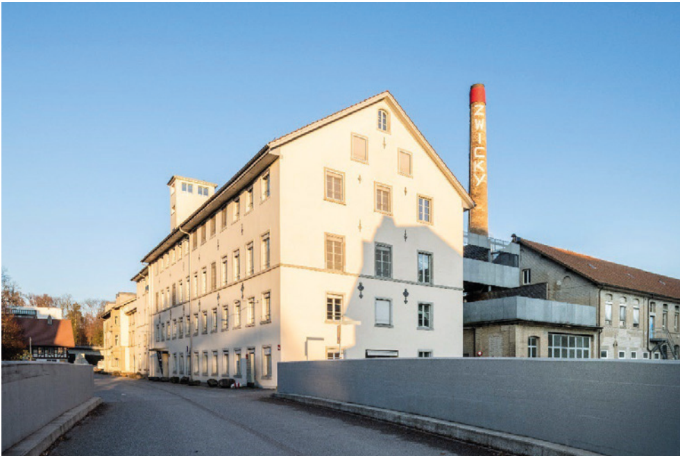
«Zwicky», von rechts ehem. Färberei mit Hochkamin (Vers. Nr. 00185), zweite Zwirnerie (Vers. Nr. 00182), erste Zwirnerie (069ZWIRN00180), ehem. Wohnhaus (069WOHN00180), ehem. Fabrikantenwohnhaus «Zum Neugut» (Vers. Nr. 00180), Ansicht von SW, 06.12.2022 (Bild Nr. D100687_87).
