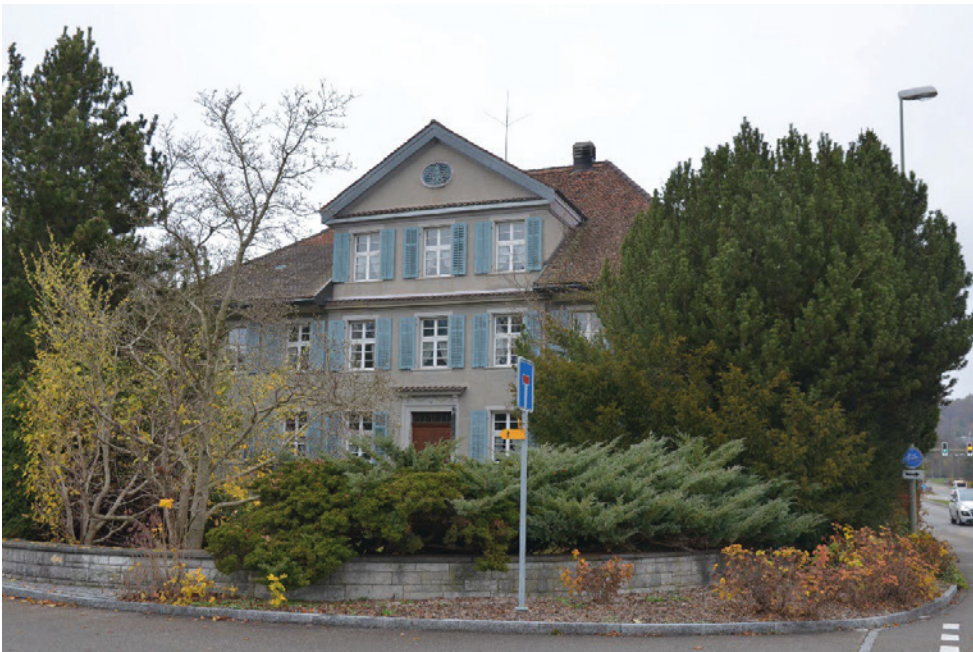
«Doktorhaus», Wohnhaus (Vers. Nr. 00139), Ansicht von SW, 16.11.2021 (Bild Nr. D102651_44).
