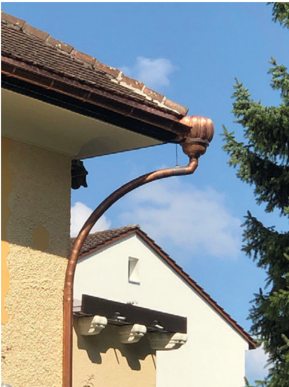
Mehrfamilienwohnhaus, Rinnenkasten und Schwanenhalsfallrohr an der Südostfassade, 15.07.2019 (Bild Nr. D101357_12).
