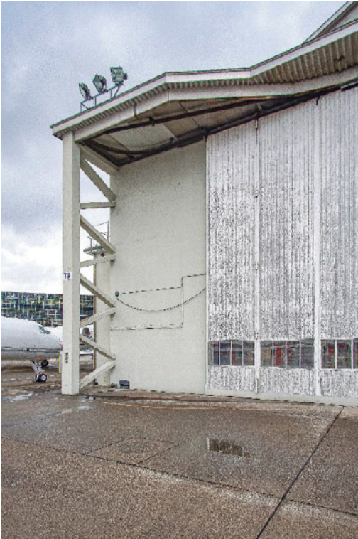
Bogenhangar, Toranlage, nordwestliche Ecknische, Ansicht von SW, 29.11.2022 (Bild Nr. D102652_59).
