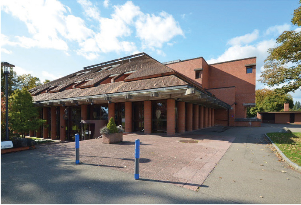
«Wallberg», Restaurant und Hotel mit Saal (Vers. Nr. 00439), links Haupteingang im UG, Ansicht von O, 13.10.2021 (Bild Nr. D101372_52).
