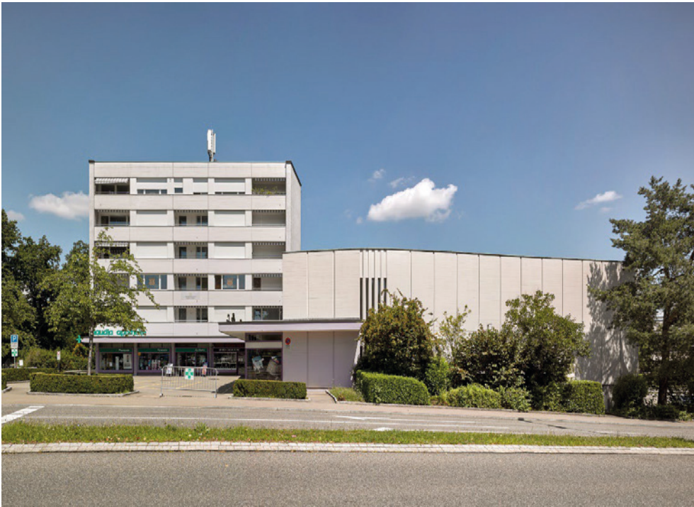
Kino «Claudia», links Wohn- und Geschäftshaus (Vers. Nr. 00400), rechts Kinogebäude (062KINO00400), Ansicht von S, 26.09.2019 (Bild Nr. D100671_28).
