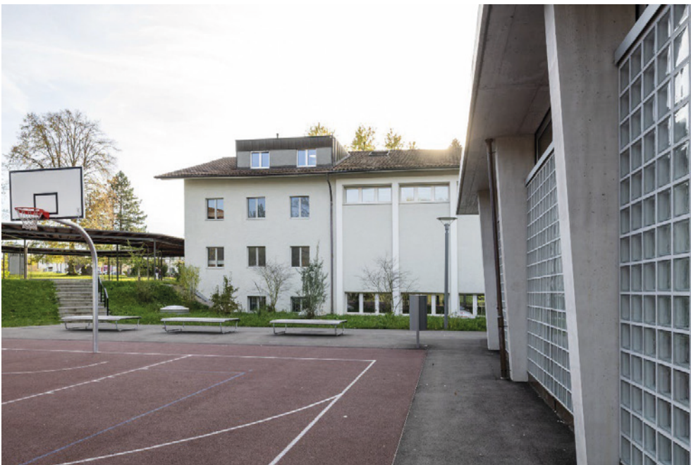
Schulanlage Halden, Turnhallegebäude (066TURN00743), Pausenplatz unter Dach (066PAUSEN00743, rechts die Turnhalle von 2018 (Oberhauserstrasse 47.1; Vers. Nr. 00743), Ansicht von NO, 07.11.2022 (Bild Nr. D100693_90).
