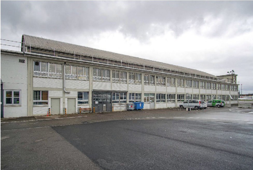
Bogenhangar, nordwestlicher Werkstatt- und Magazintrakt, Ansicht von N, 29.11.2022 (Bild Nr. D102652_58).
