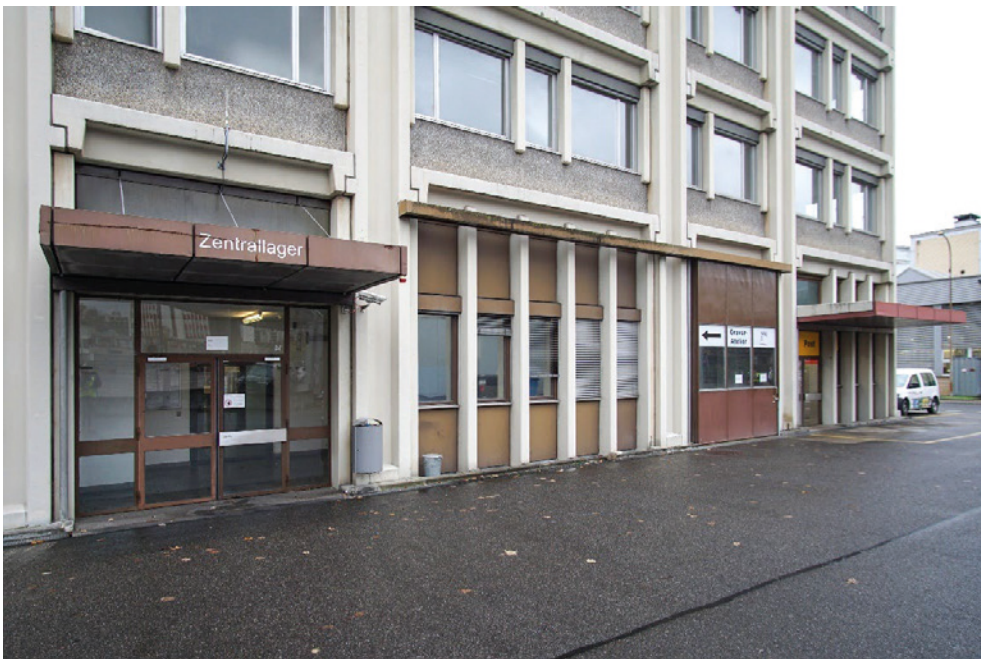
Ehem. Zentrallager, Büro- und Verwaltungstrakt, Haupteingang (links) und Eingang zum Postlokal (rechts), Ansicht von N, 22.11.2022 (Bild Nr. D104015_95).
