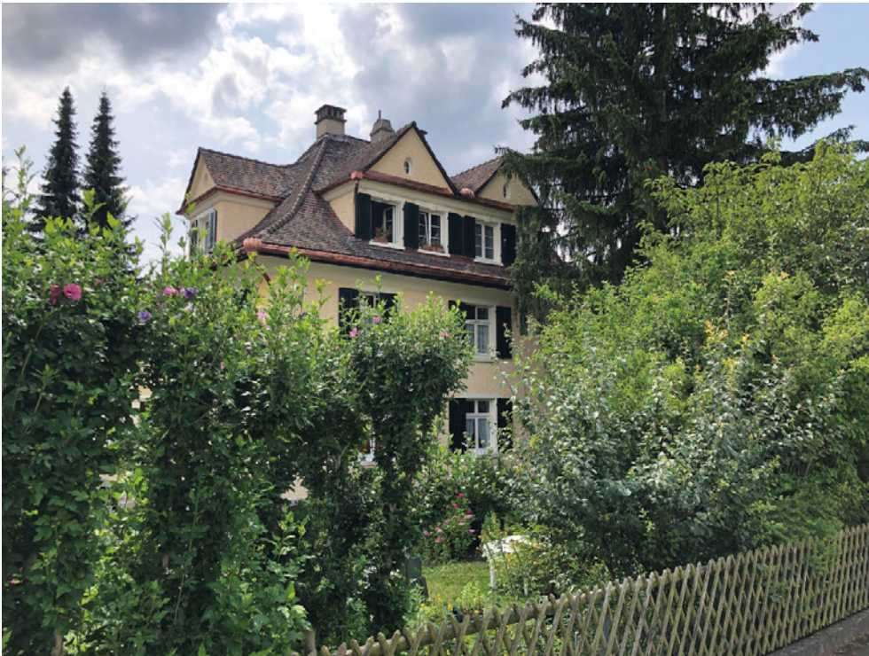
Mehrfamilienwohnhaus, Ansicht von NO, 15.07.2019 (Bild Nr. D101357_11).
