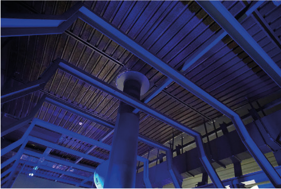
Bahnhof Zürich Flughafen, Perronanlage (062PERRON02732), Perron 1, Perrondachkonstruktion (Untersicht), 26.10.2022 (Bild Nr. D104016_13).
