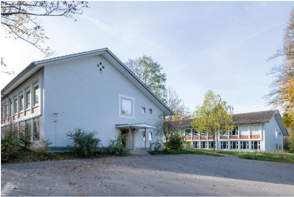
Schulanlage Halden, Sekundarschulhaus Trakt D (Vers. Nr. 00882), Nordostflügel, Primarschulhaus Trakt C (Vers. Nr. 00868), Ansicht von O, 07.11.2022 (Bild Nr. D100686_34).
