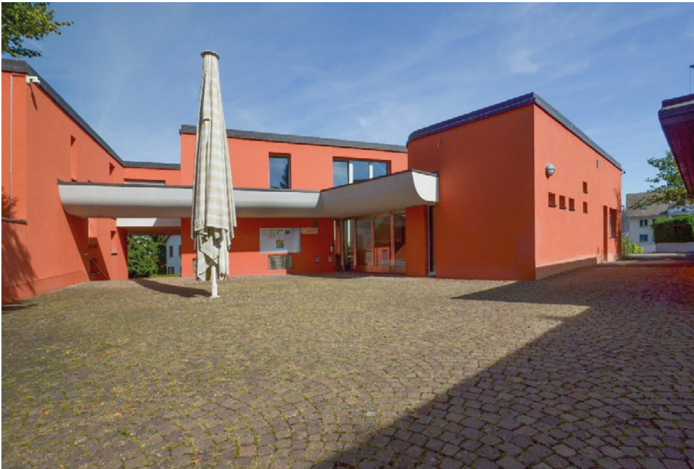
Kath. Kirchenzentrum Kloten, Pfarreizentrum (Vers. Nr. 01732), Ansicht von SW, 24.08.2022 (Bild Nr. D102651_58).
