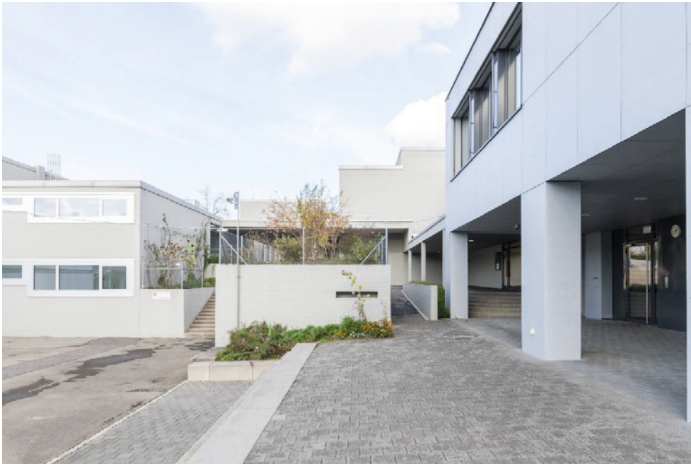
Schulanlage Hinterwiden, in der Mitte Magazin (Vers. Nr. 01375) mit südlichem Teil des Pausenhofs (062PAUSEN01368), links Turnhallentrakt (Vers. 01369), rechts Schultrakt E und F (Vers. Nr. 01772) sowie Ergänzungsbau der Berufswahlschule, Ansicht von SW, 02.11.2022 (Bild Nr. D101362_44).
