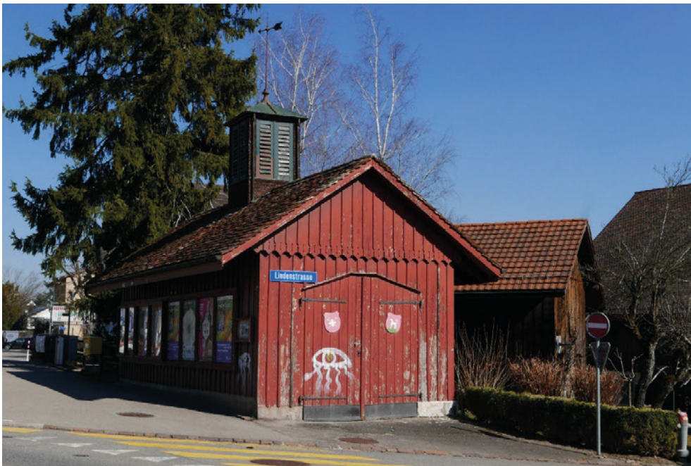
Spritzenhaus, Ansicht von SW, 04.03.2022 (Bild Nr. D100583_92).
