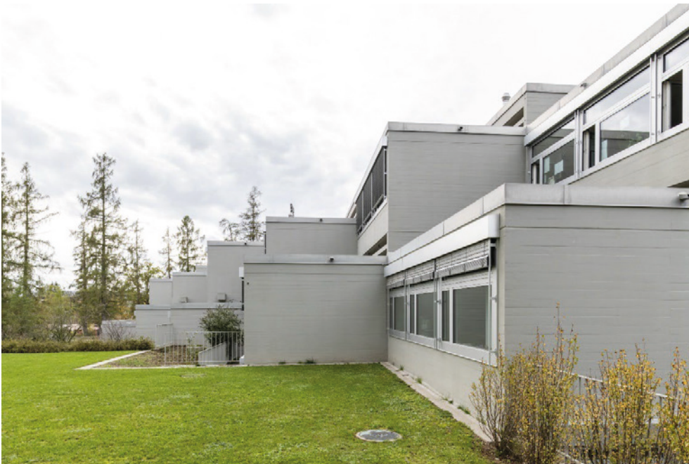
Schulanlage Hinterwiden, Schultrakte A, B und C (Vers. Nr. 01368), Ansicht von NO, 02.11.2022 (Bild Nr. D101362_28).
