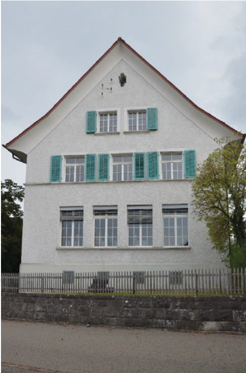
Ehem. Schulhaus, Südwestfassade, 15.09.2021 (Bild Nr. D101386_11).
