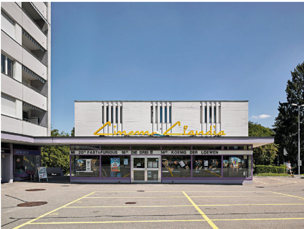
Kino «Claudia», Kinogebäude (062KINO00400), Eingangsfront mit verglastem Foyer, Ansicht von W, 26.09.2019 (Bild Nr. D100671_30).
