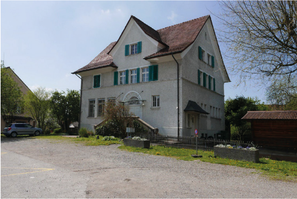
Ehem. Schulhaus, Ansicht von NO, 19.04.2016 (Bild Nr. D101386_02).
