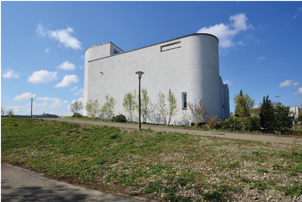
Kath. Kirche St. Peter, Nordostfassade, links turmartig aufragender Chor, rechts halbrunde Andachtsnische, 14.04.2021 (Bild Nr. D101399_48).
