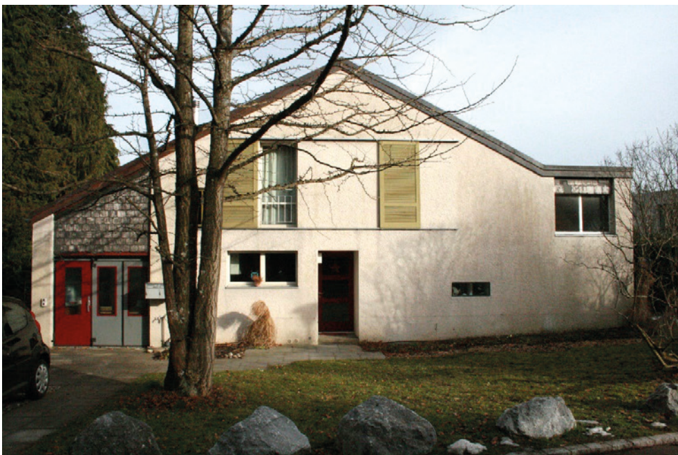
Atelierhaus, Westfassade, links Garage und Werkeingang, in der Mitte Hauseingang, rechts weitergeführte Fassade, die den Aussensitzplatz abschirmt, 27.01.2016 (Bild Nr. D101104_42).
