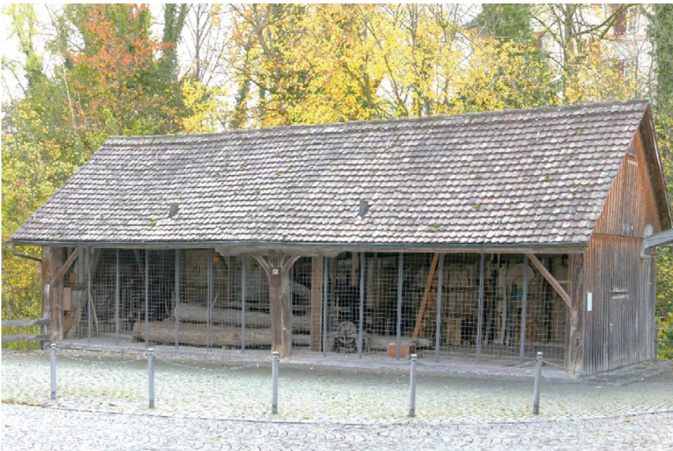
Mühle Maur, Sägerei (Vers. Nr. 00288), rechts Oberwasserkanal (195WR-g0090-03), Ansicht von W, 05.11.2021 (Bild Nr. D101361_53).
