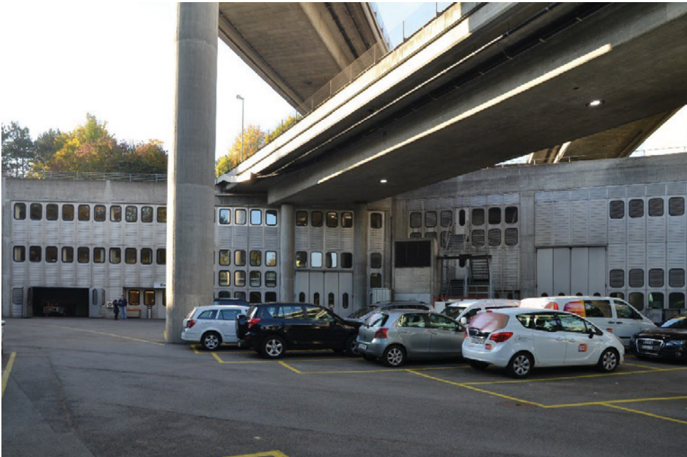
Heizkraftwerk Aubrugg, Nordhof, links Dienstgebäude (Vers. Nr. 01953), das die Autobahnunterwerfung trägt, rechts Maschinenhalle (069HALLE01953), deren Konstruktion die beiden Autobahnüberwerfungen trägt, Ansicht von N, 16.10.2017 (Bild Nr. D100580_62).
