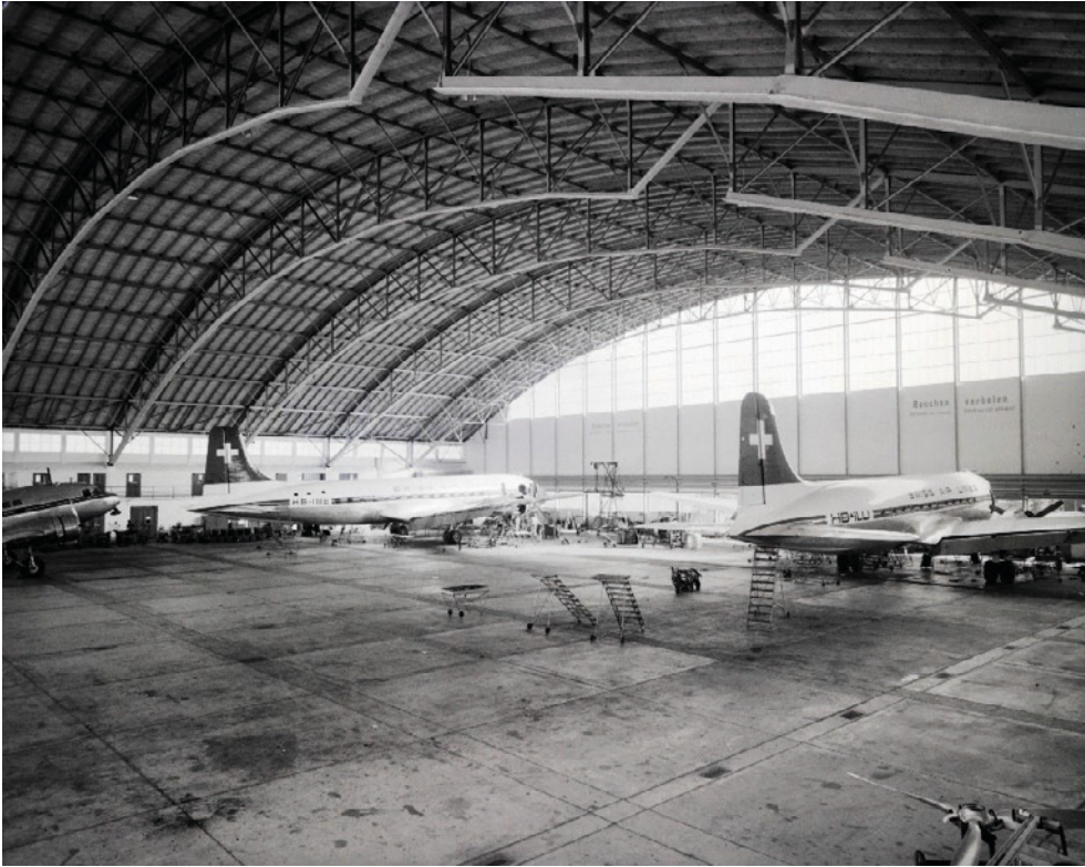
Bogenhangar, Stahlträger mit Zwischengelenk, Blick nach N, Bild: ETH Bildarchiv, Sign. LBS_SR03-06167 (Bild Nr. D102652_52).
