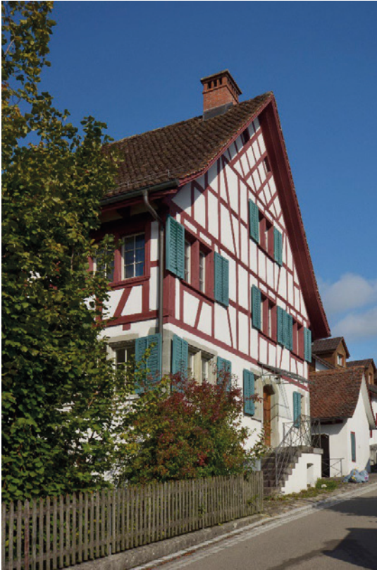
Ref. Pfarrliegenschaft, Pfarrhaus (Vers. Nr. 00200) und ehem. Waschhaus mit Holzschopf (Vers. Nr. 00199), Ansicht von SO, 31.10.2021 (Bild Nr. D101385_04).
