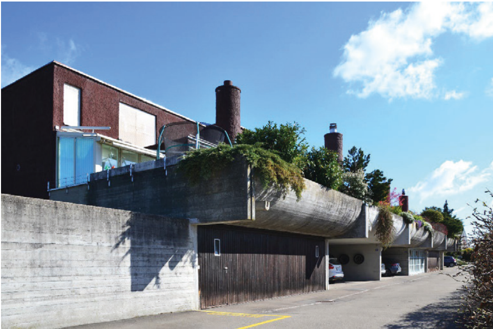
Wohnüberbauung Heuelstrasse, Garagen (Vers. Nr. 00027–00029, 00088, 00089), Ansicht von SW, 06.04.2021 (Bild Nr. D101360_02).
