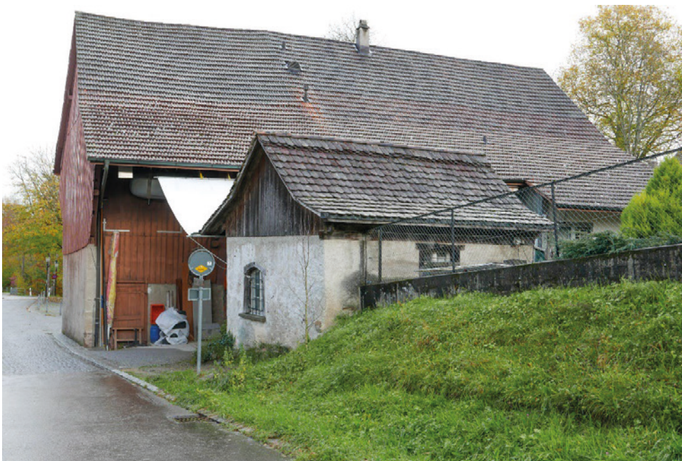
Mühle Maur, Mühlegebäude (Vers. Nr. 00285) und Waschhaus (Vers. Nr. 00287), Ansicht von SW, 05.11.2021 (Bild Nr. D101361_51).
