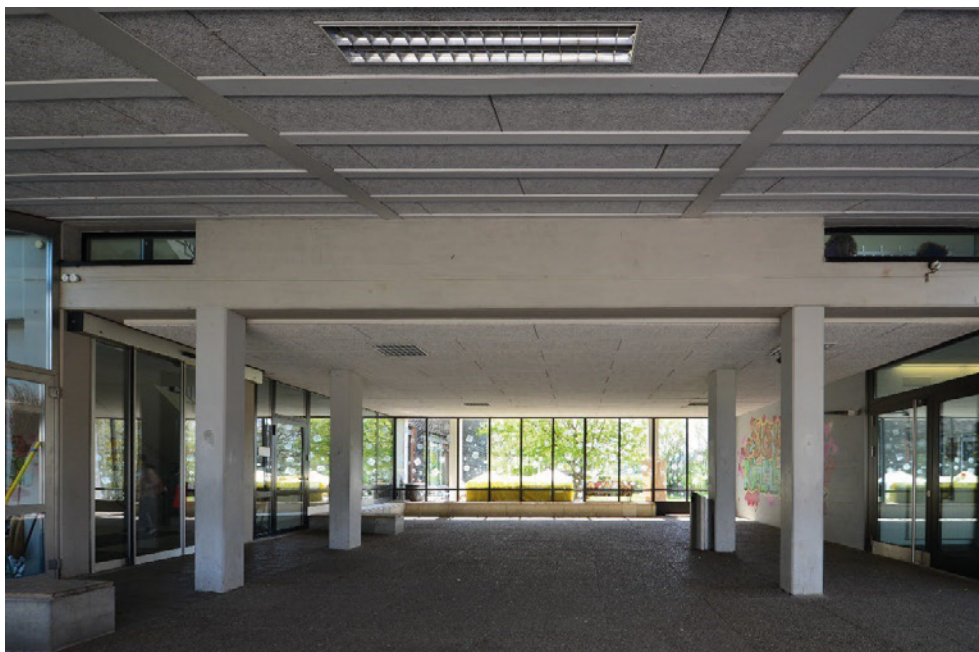
Schulanlage Rümelbach, Schulhaus mit Kindergarten (Vers. Nr. 01481), Nordosttrakt, Blick nach N in die Pausenhalle, 14.04.2021 (Bild Nr. D100586_43).
