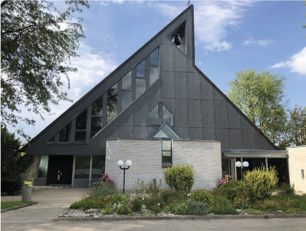
Kath. Kirche Bruder Klaus, südöstliche Giebelfassade mit 1995 angebaute Werktagkapelle und seitlich dahinter liegenden Eingängen, 29.08.2018 (Bild Nr. D101399_12).
