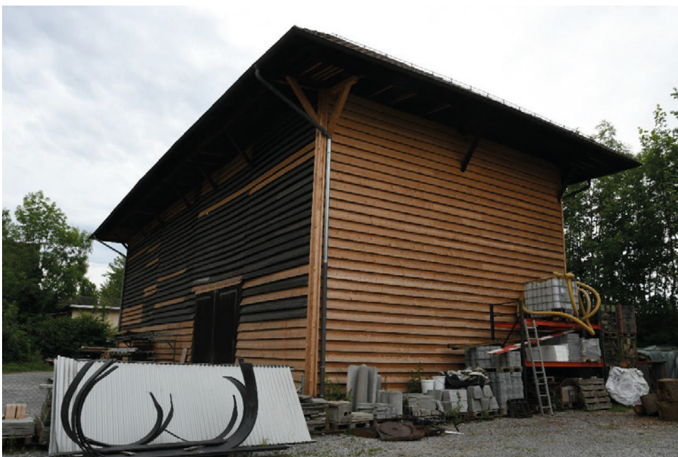
Trocknungsgebäude, Ansicht von NW, 09.06.2017 (Bild Nr. D100583_54).
