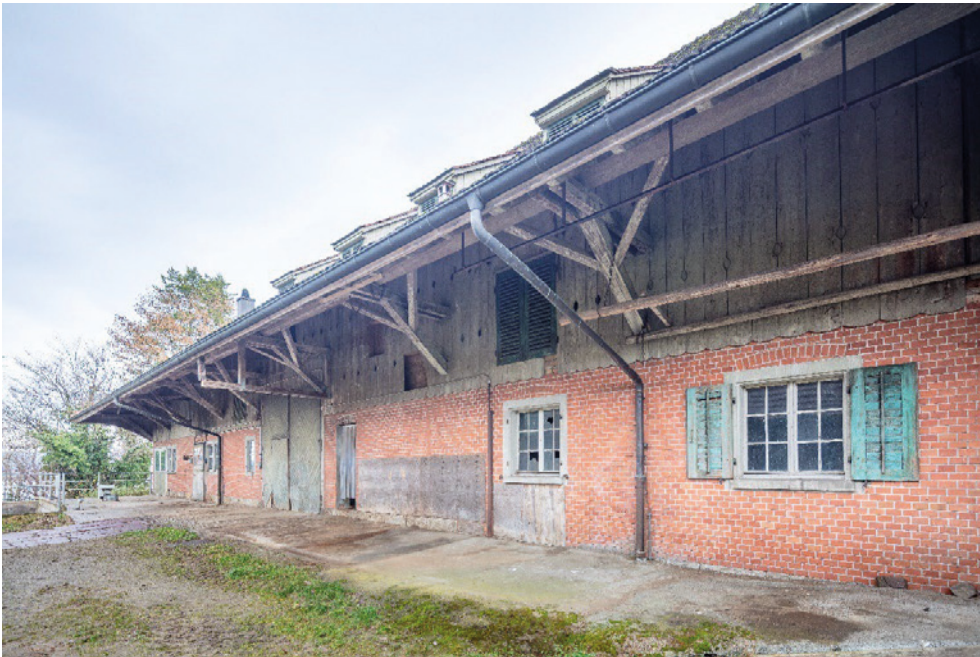
Landsitz Fluh, Ökonomie- und Verwaltergebäude (Vers. Nr. 00374), Ökonomiegebäude, hofabgewandte Nordwestfassade, 03.12.2020 (Bild Nr. D101970_93).
