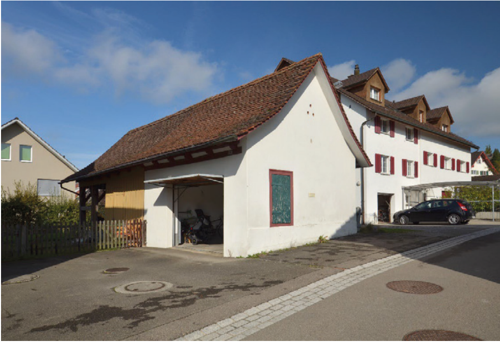
Ref. Pfarriiegenschaft, ehem. Waschhaus mit Holzschopf (Vers. Nr. 00199), Ansicht von SO, 31.10.2021 (Bild Nr. D101385_06).
