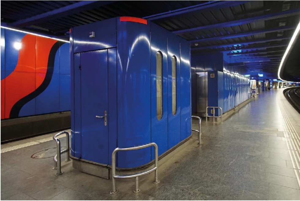
Bahnhof Zürich Flughafen, Perronanlage (062PERRON02732), Perron 1, ehem. Diensthäuschen mit Telefonkabine, dahinter der mittlere Nottreppenaufgang, Blick nach N, 26.10.2022 (Bild Nr. D104016_09).
