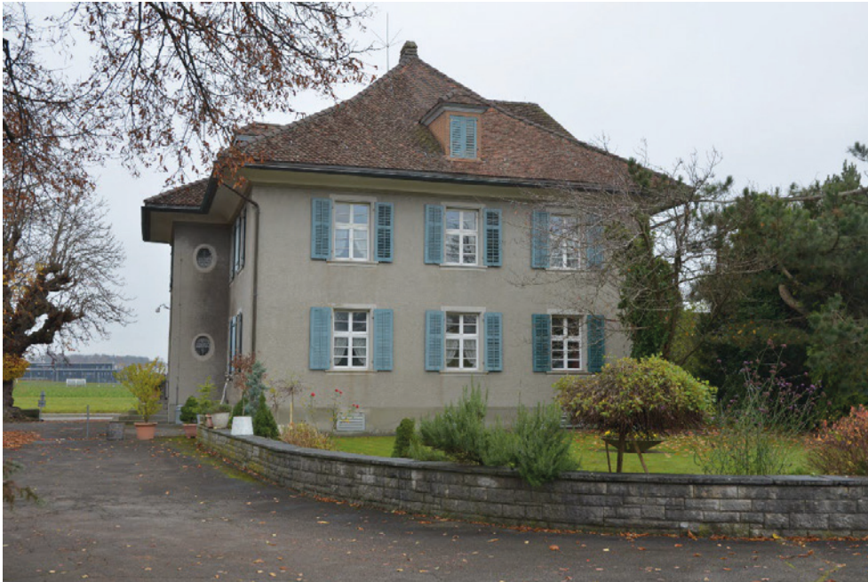
«Doktorhaus», Wohnhaus (Vers. Nr. 00139), Ansicht von NW, 16.11.2021 (Bild Nr. D102651_46).
