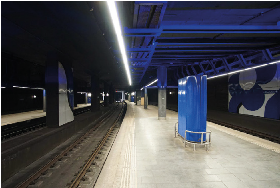
Bahnhof Zürich Flughafen, Perronanlage (062PERRON02732), Perron 1, südwestliches Perronende, Blick nach SW, 26.10.2022 (Bild Nr. D104016_05).
