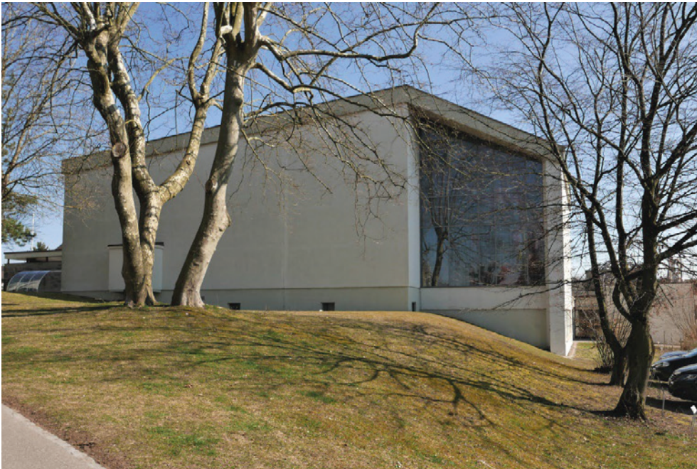
Kath. Kirche St. Antonius, kath. Kirche (Vers. Nr. 01506) mit ausgebautem UG, darüber Altarraum mit wandhohem Glasfenster, Ansicht von W, 08.03.2022 (Bild Nr. D100583_04).
