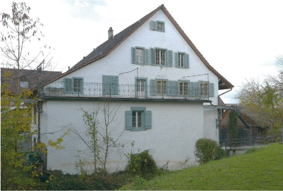
Mühle Maur, Mühlegebäude (Vers. Nr. 00285), vorne Radhaus, rechts rekonstruierter Oberwasserkanal (195WR-g0090-03), der das Wasser in die Sägerei (Vers. Nr. 00288) führt, Ansicht von SO, 05.11.2021 (Bild Nr. D101361_47).
