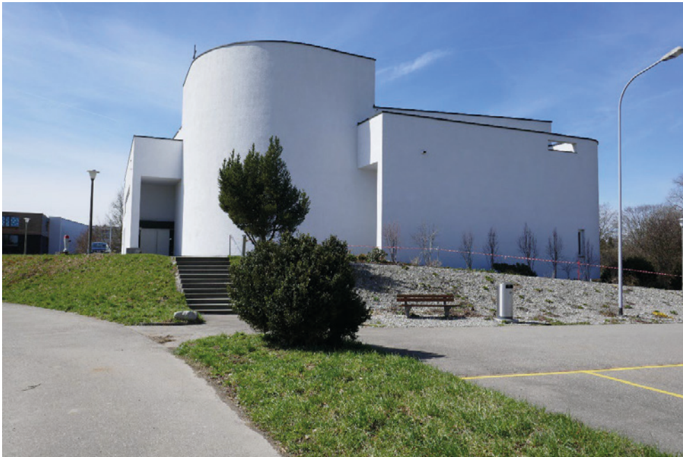
Kath. Kirche St. Peter, Kirchenvorplatz mit abgerundetem, turmartig aufragendem Chor und seitlich angefügten Zugängen, Ansicht von O, 02.04.2018 (Bild Nr. D101399_01).
