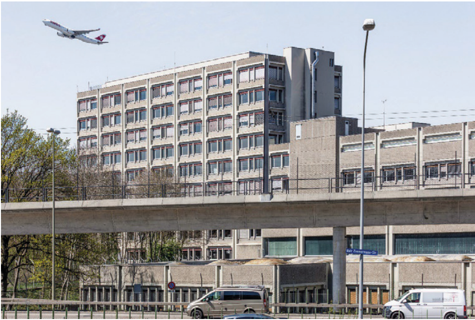
Ehem. Zentrallager, Werkstatttrakt, dahinter südwestlicher Bürotrakt, Ansicht von S, 18.04.2019 (Bild Nr. D104015_75).
