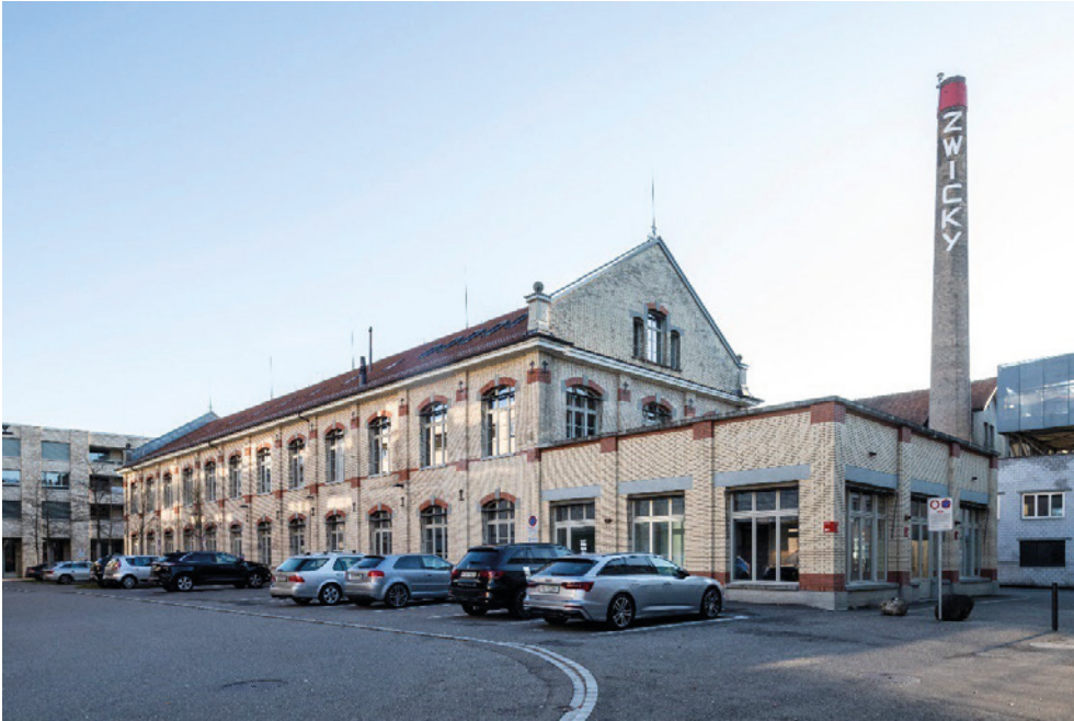
«Zwicky», ehem. Zwirnerie (Vers. Nr. 00191), rechts 1962 angebauter Zwirnerisaal, im Hintergrund Hochkamin der ehem. Färberei (Vers. Nr. 00185), Ansicht von N, 06.12.2022 (Bild Nr. D100688_32).
