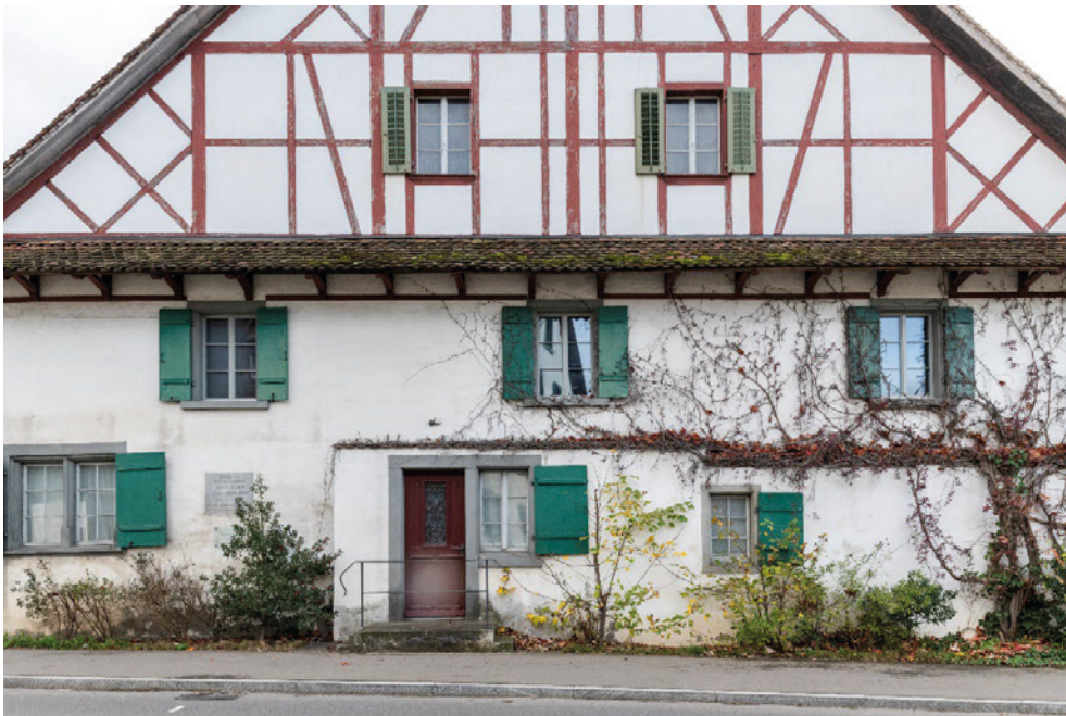
«Katzenrütihof», «Kleinjogg-Haus» (Vers. Nr. 00930), Nordfassade, 01.11.2022 (Bild Nr. D102651_83).
