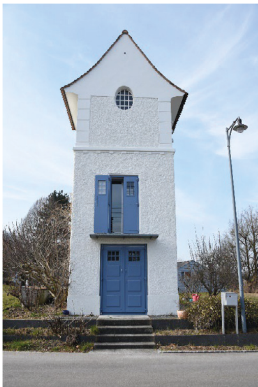
Ländliche Versorgungsbauten, ehem. Transformatorenstation «Maur-Dorf» (Vers. Nr. 00261), Ansicht von SO, 08.03.2022 (Bild Nr. D101104_71).
