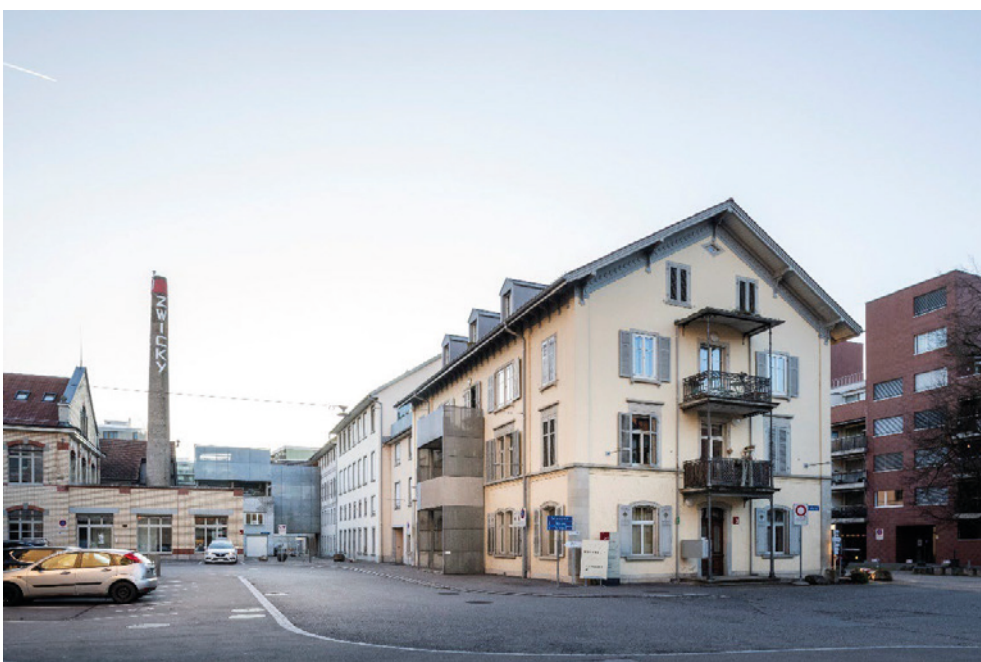
«Zwicky», von links ehem. Zwirnerie (Vers. Nr. 00191), Hochkamin der ehem. Färberei (Vers. Nr. 00185), zweite Zwirnerie (Vers. Nr. 00182), erste Zwirnerie (069ZWIRN00180), ehem. Wohnhaus (069WOHN00180), ehem. Fabrikantenwohnhaus «Zum Neugut» (Vers. Nr. 00180), Ansicht von NO, 06.12.2022 (Bild Nr. D100687_69).
