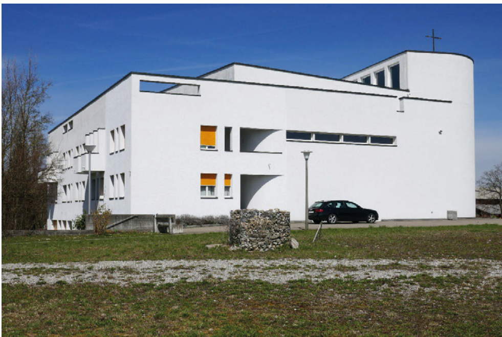
Kath. Kirche St. Peter, links wie ein Wohnhaus gestaltetes Pfarreizentrum und Pfarrhaus, rechts Kirche mit Oberlichtband des seitlichen Zugangs, Ansicht von S, 02.04.2018 (Bild Nr. D101399_02).
