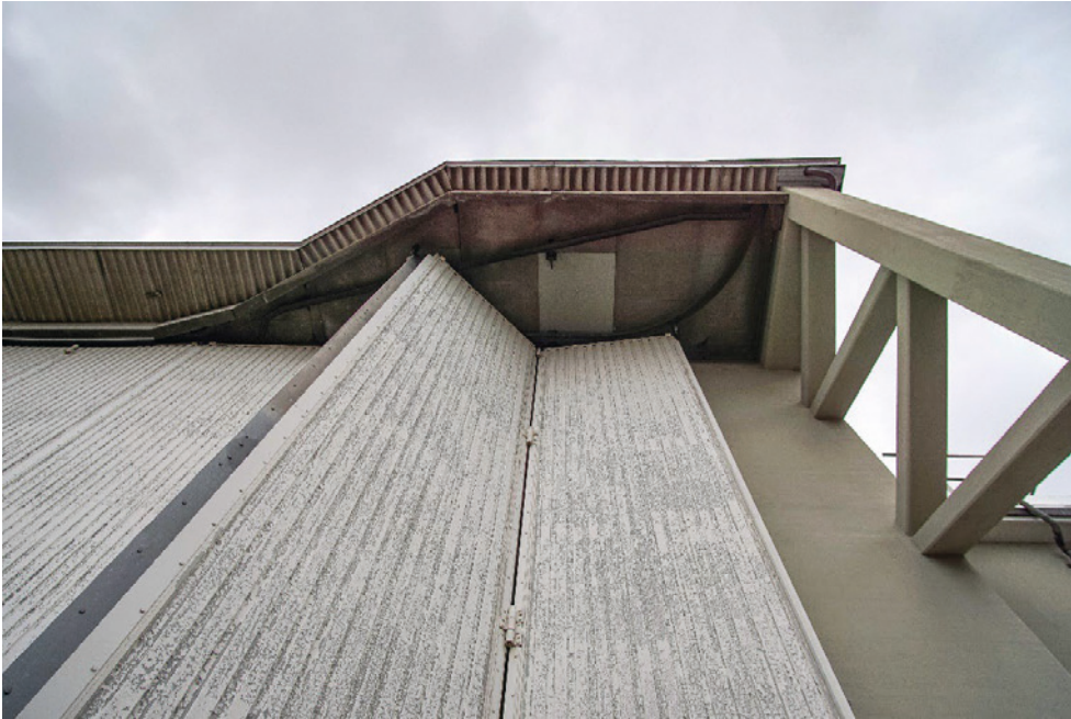
Bogenhangar, Toranlage, südliche Ecknische, Ansicht von unten an die Führungswalzen, 29.11.2022 (Bild Nr. D102652_62).
