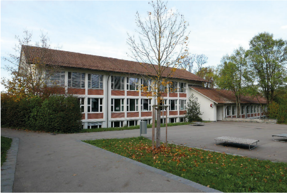
Schulanlage Halden, Sekundarschulhaus Trakt A (Vers. Nr. 00743), Ansicht von S, 01.11.2022 (Bild Nr. D100693_45).
