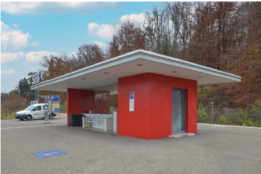
Haltestelle Kloten Balsberg, ehem. Kloten Flughafen, Ansicht von W, 23.11.2021 (Bild Nr. D104016_53).
