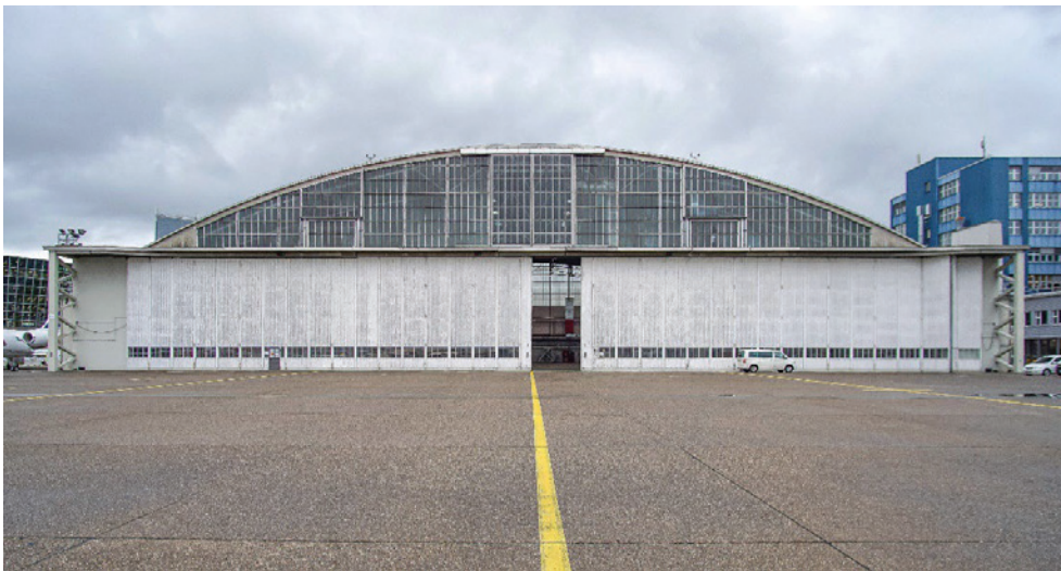
Bogenhangar, Ansicht von SW, 29.11.2022 (Bild Nr. D102652_55).
