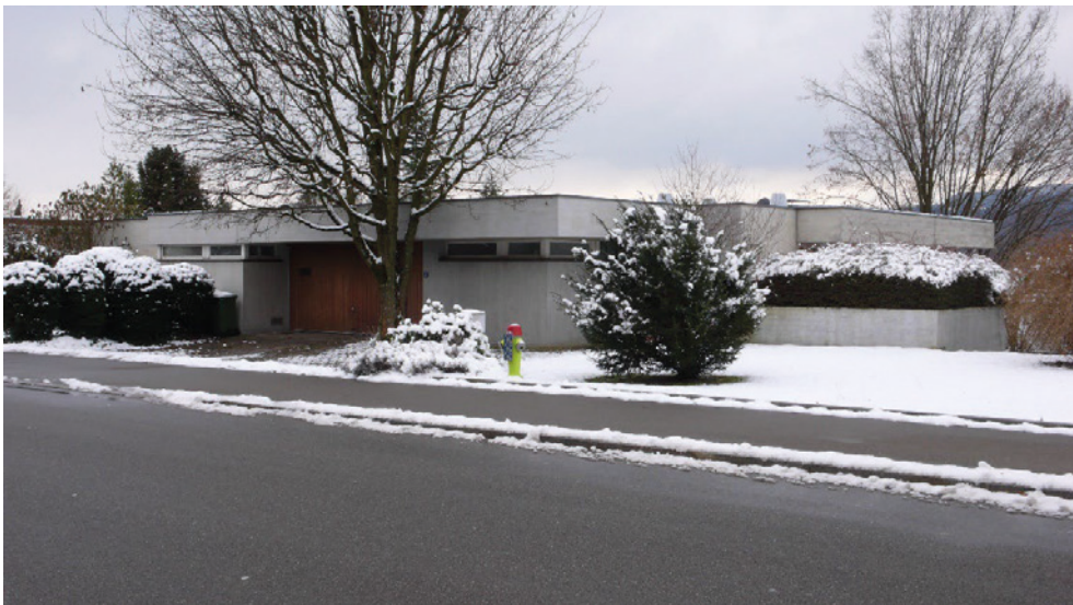
Wohnhaus Schader, Ansicht von NW, 21.01.2011 (Bild Nr. D100594_02).
