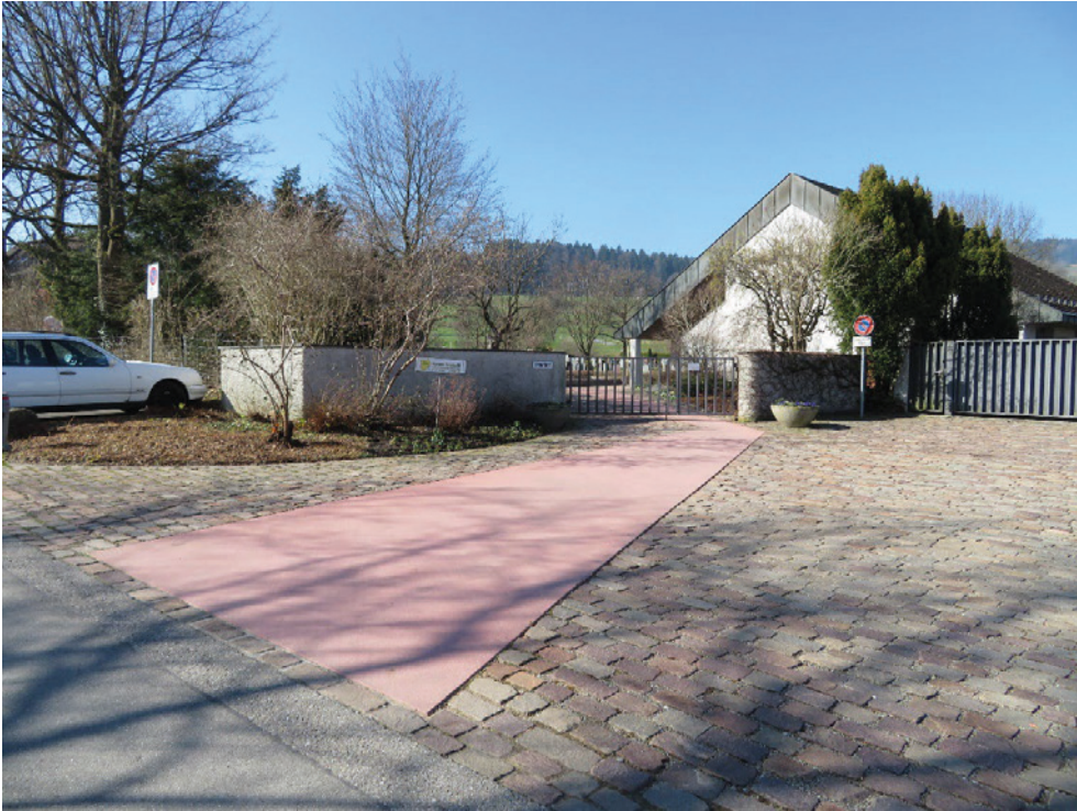
Neuer Friedhof Maur, Eingang und Zugangsweg mit rötlich eingefärbten Zementplatten, Ansicht von NO, 16.03.2017 (Bild Nr. D101104_33).
