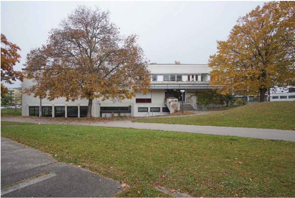
Schulanlage Feldhof, Turn- und Schwimmhalle (Vers. Nr. 01045), Ansicht von S, 09.11.2021 (Bild Nr. D104015_37).
