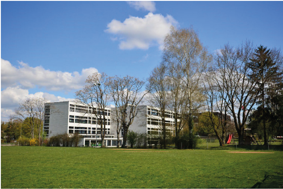
Schulanlage Rümelbach, Schulhaus mit Kindergarten (Vers. Nr. 01481), Südwest- und Nordosttrakt, Ansicht von S, 14.04.2021 (Bild Nr. D100586_40).
