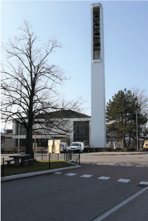
Kath. Kirche St. Antonius, Ansicht von N, 08.03.2022 (Bild Nr. D100583_02).
