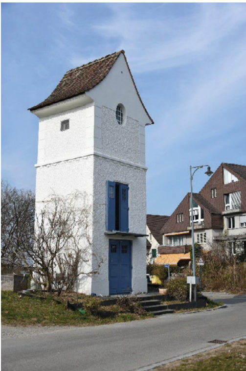
Ländliche Versorgungsbauten, ehem. Transformatorstation «Maur-Dorf» (Vers. Nr. 00261), Ansicht von S, 08.03.2022 (Bild Nr. D101104_68).
