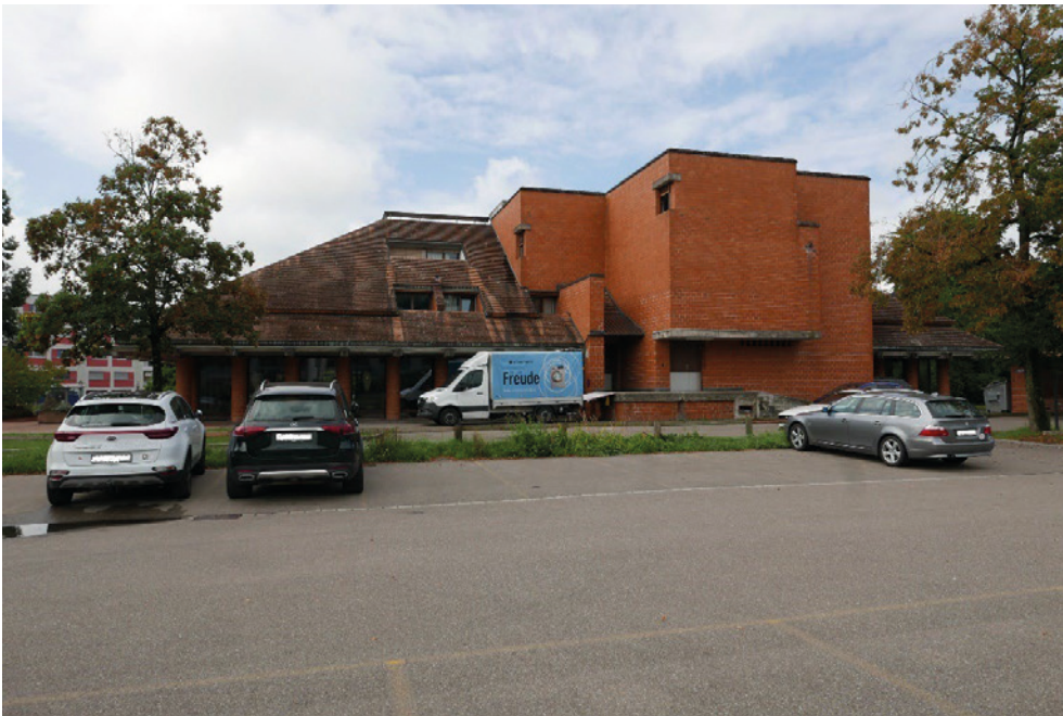
«Wallberg», Restaurant und Hotel mit Saal (Vers. Nr. 00439), rechts Bühnenbereich, Ansicht von NO, 13.09.2023 (Bild Nr. D101372_62).
