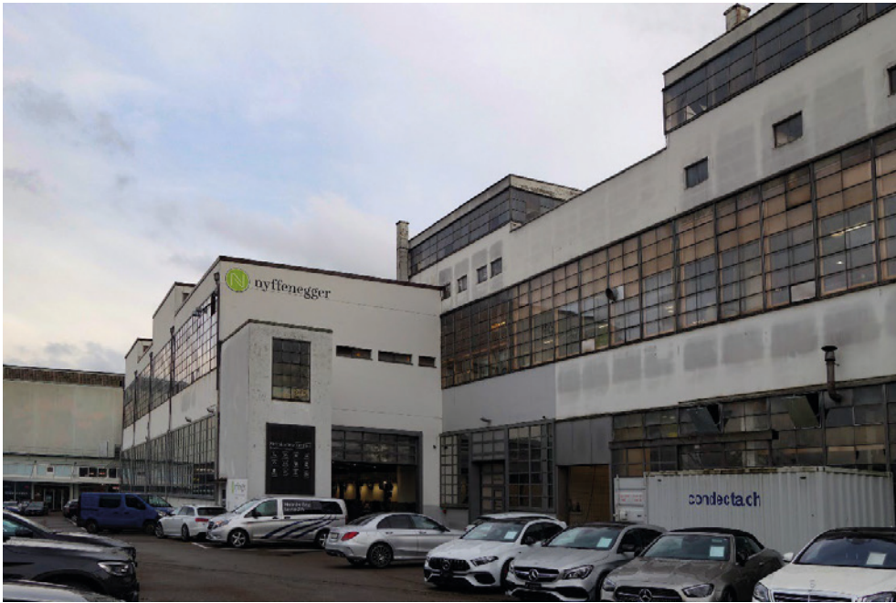
Fabrikhallen der ehem. Eisenbaugesellschaft Zürich, Querhallen, Ansicht von NW, 05.12.2022 (Bild Nr. D101361_99).
