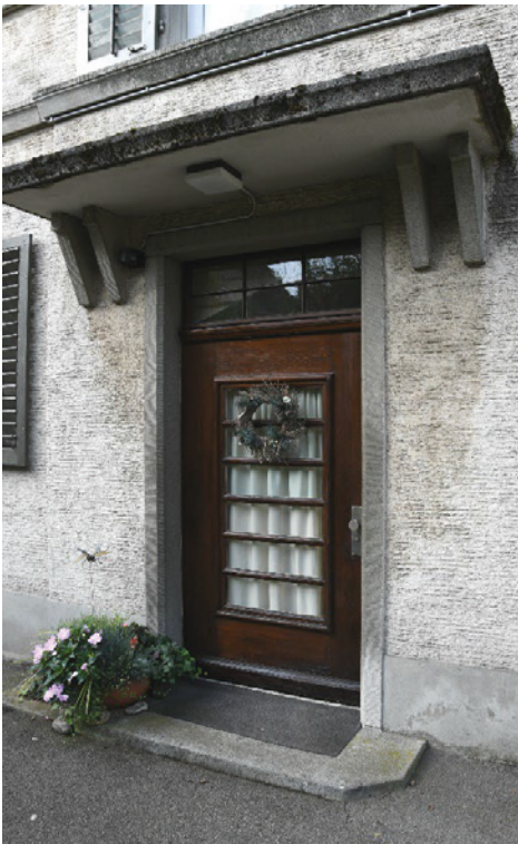
Wohn- und Geschäftshaus, Nordostfassade, Hauseingang zu den Wohnungen, 04.09.2017 (Bild Nr. D100587_80).
