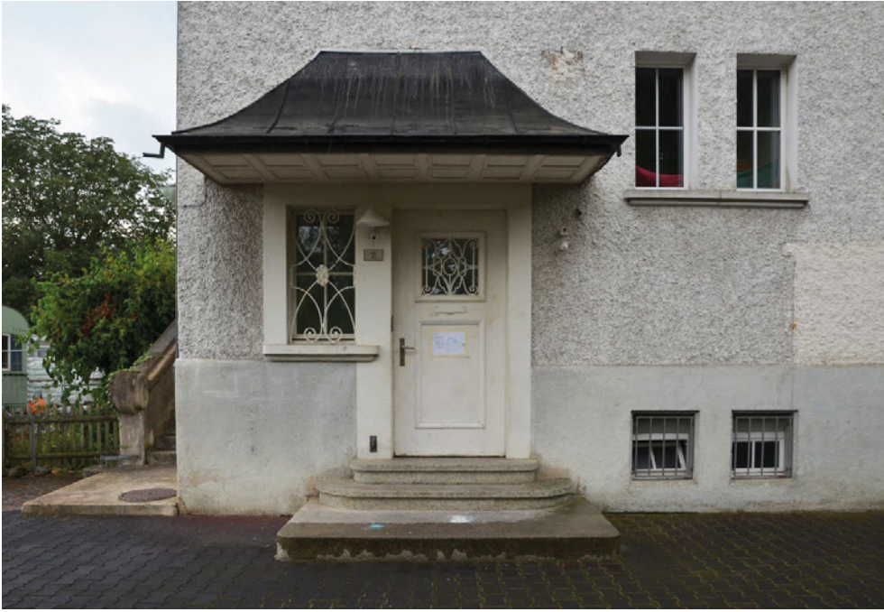
Ehem. Schulhaus, Nebeneingang an der Nordostfassade, 15.09.2021 (Bild Nr. D101386_12).
