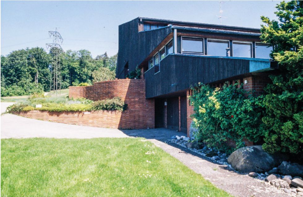
Hof Erlenhölzli, ehem. Vielzweckbauernhaus (Vers. Nr. 00941), Umgebung (097UMGEBU00941) mit Stützmauern zwischen Garagen und Scheunentor vor der Westfassade, Ansicht von SW, 07.06.2006 (Bild Nr. L53016_04).
