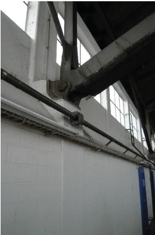
Bogenhangar, Widerlager eines Stahlbogenträgers, 28.07.2010 (Bild Nr. D101350_16).
