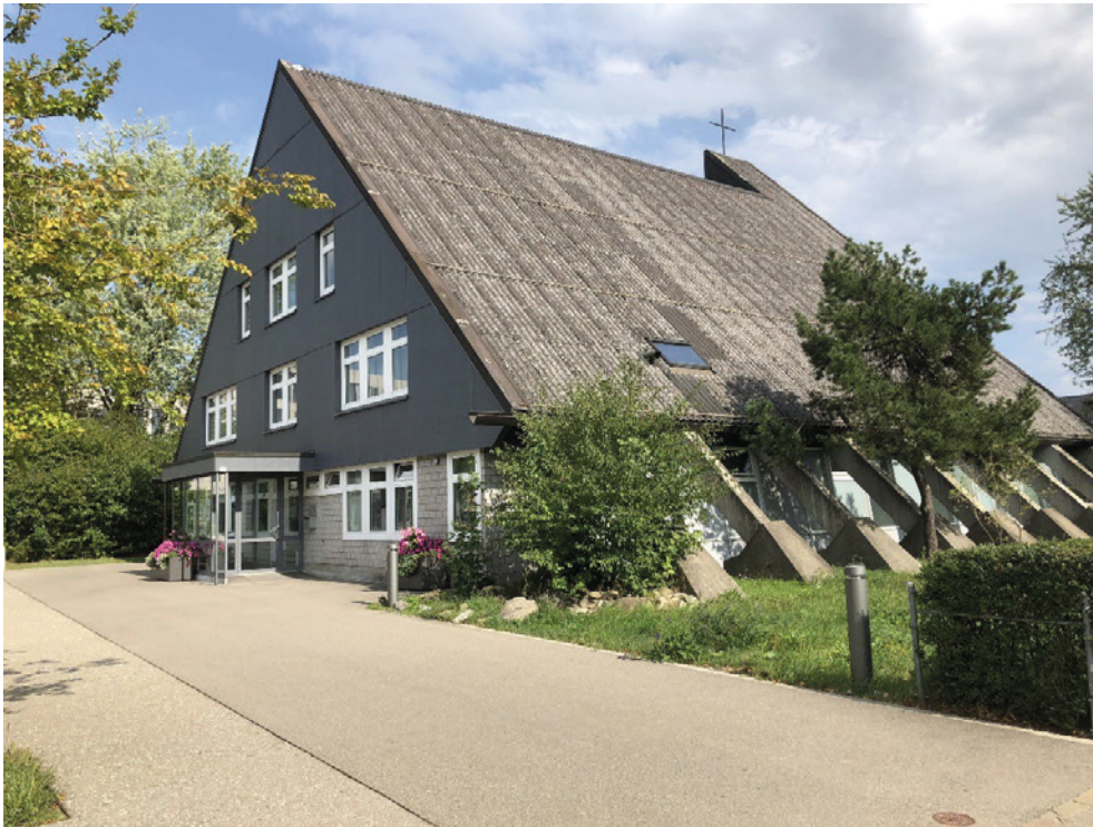
Kath. Kirche Bruder Klaus, Eingang zum Pfarrsekretariat, Ansicht von NW, 29.08.2018 (Bild Nr. D101399_14).
