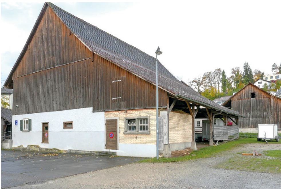
Mühle Maur, Mühlescheune (Vers. Nr. 00297), Ansicht von NO, 05.11.2021 (Bild Nr. D101361_57).
