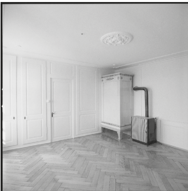
«Doktorhaus», Wohnhaus (Vers. Nr. 00139), Stube im OG mit Täfer, Stuckatur, Ofen und Fischgrätparkett, Blick nach NW, 02.03.2005 (Bild Nr. L51298_01).
