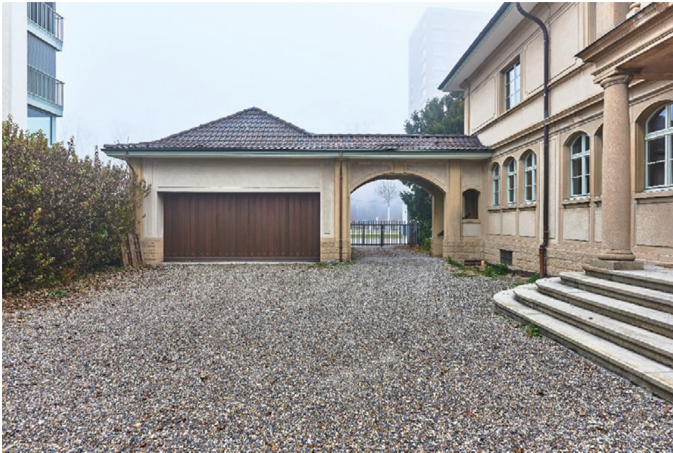
«Zwicky», Garage (069GARAGE00763), Fabrikantenvilla (Vers. Nr. 00763), Ansicht von S, 19.11.2021 (Bild Nr. D101985_01).
