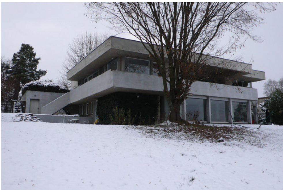
Wohnhaus Schader, Ansicht von SW, 21.01.2011 (Bild Nr. D100594_07).
