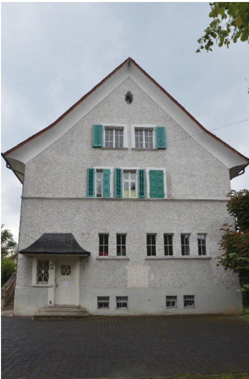
Ehem. Schulhaus, Nordostfassade, 15.09.2021 (Bild Nr. D101386_10).
