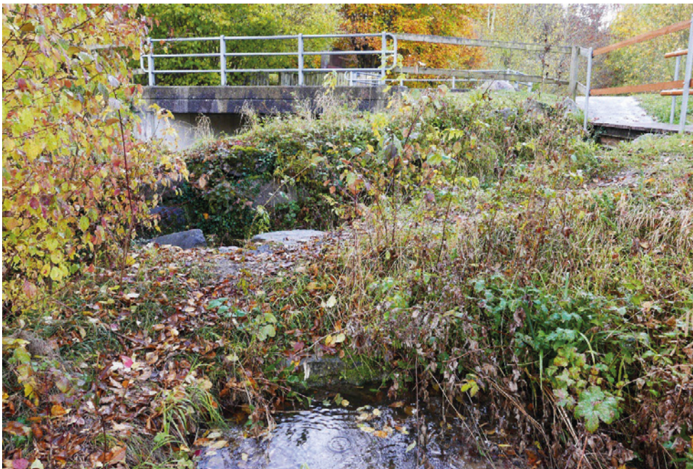
Mühle Maur, Wasserfassung (195WR-g0090-01), Ansicht von NW, 05.11.2021 (Bild Nr. D101361_59).
