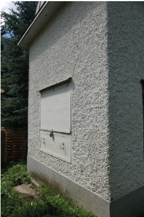
Transformatorstation Gutenswil, Ansicht von N, Detail der Bedienungsöffnung auf der Nordostseite, 12.04.2016 (Bild Nr. D101361_38).
