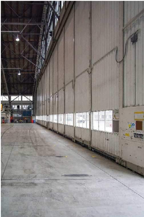
Bogenhangar, Toranlage von innen, Blick nach SO, 29.11.2022 (Bild Nr. D102652_71).
