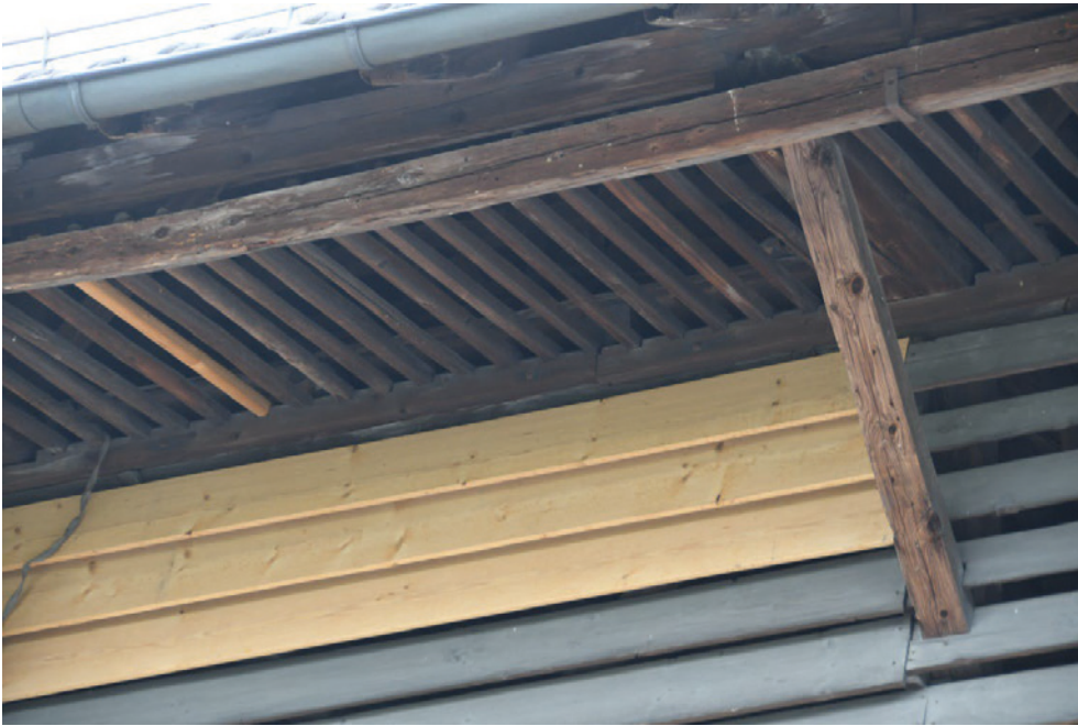
Trocknungsgebäude, Dachuntersicht mit hölzerner Tuchhängevorrichtung, 09.06.2017 (Bild Nr. D100583_56).
