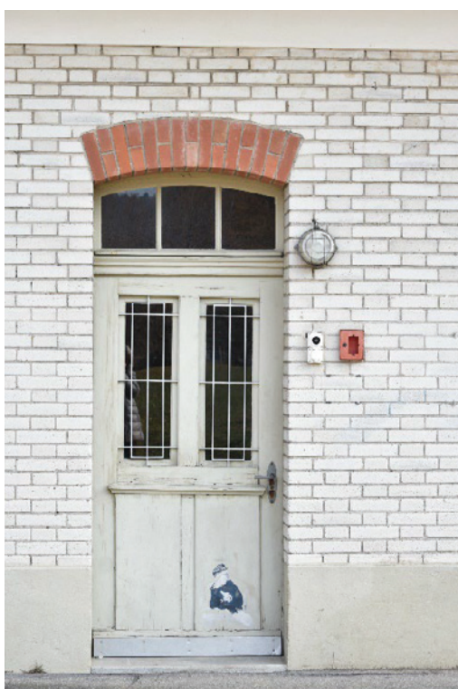
Ländliche Versorgungsbauten, Spritzenhaus (Vers. Nr. 00260), Eingangstür an der Nordwestfassade, 17.03.2022 (Bild Nr. D101104_66).
