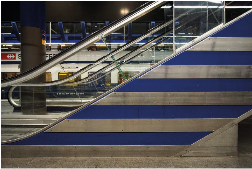
Bahnhof Zürich Flughafen, Perronanlage (062PERRON02732), Perron 1, perronseitige Rolltreppenverkleidung, 26.10.2022 (Bild Nr. D104016_18).
