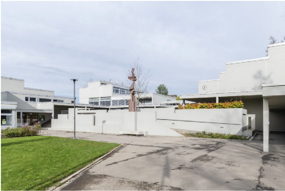
Schulanlage Hinterwiden, Pausenhof (062PAUSEN01368) mit Plastik von Silvio Mattioli sowie links Singsaaltrakt (Vers. Nr. 01366), links im Hintergrund Schultrakt D mit Abwartswohnung (Vers. Nr. 01367) und rechts Schultrakte A, B und C (Vers. Nr. 01368), Ansicht von S, 02.11.2022 (Bild Nr. D101362_20).
