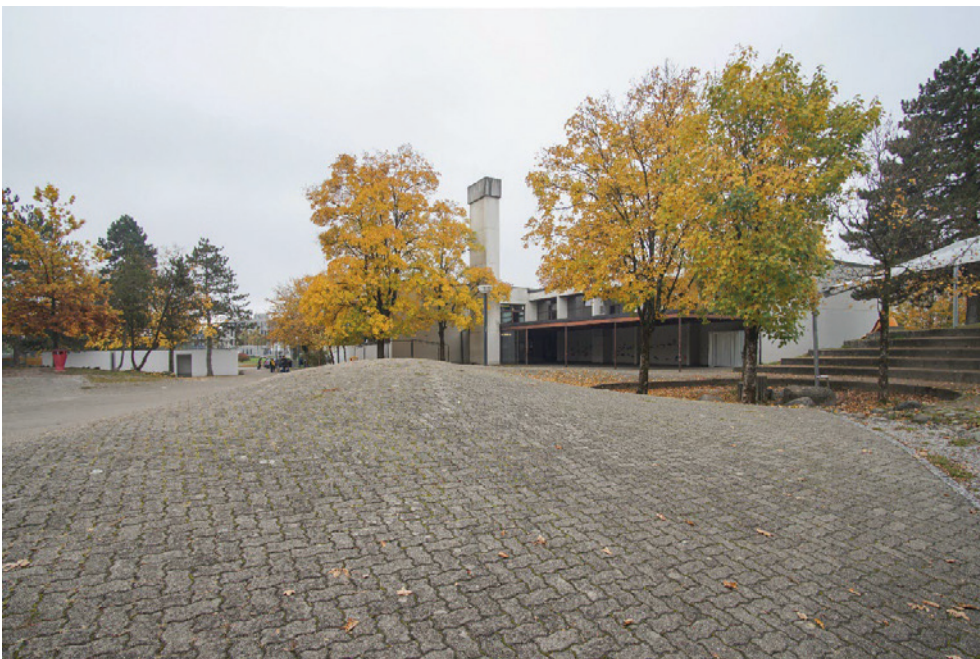
Schulanlage Feldhof, Umgebung (199UMGEBU01044), Pausenplatz mit Hügel und Arena, im Hintergrund rechts die Turn- und Schwimmhalle (Vers. Nr. 01045), links der westliche Fahrradunterstand (Vers. Nr. 01355), Ansicht von NO, 09.11.2021 (Bild Nr. D104015_65).
