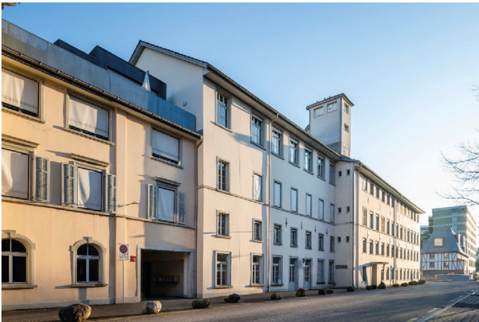
«Zwicky», von links ehem. Wohnhaus (069WOHN00180), erste Zwirnerei (069ZWIRN00180), zweite Zwirnerei (Vers. Nr. 00182), Ansicht von NW, 06.12.2022 (Bild Nr. D100687_78).
