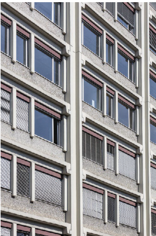
Ehem. Zentrallager, Fassadendetail, 18.04.2019 (Bild Nr. D104015_79).
