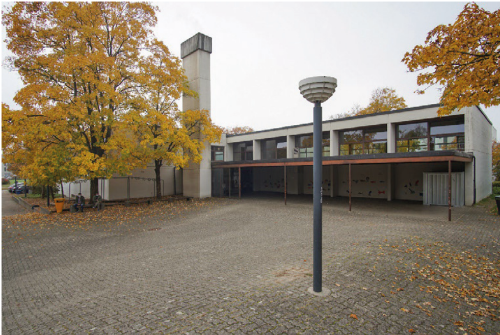
Schulanlage Feldhof, Turn- und Schwimmhalle (Vers. Nr. 01045), Eingangsbereich beim Pausenplatz, Ansicht von NO, 09.11.2021 (Bild Nr. D104015_36).
