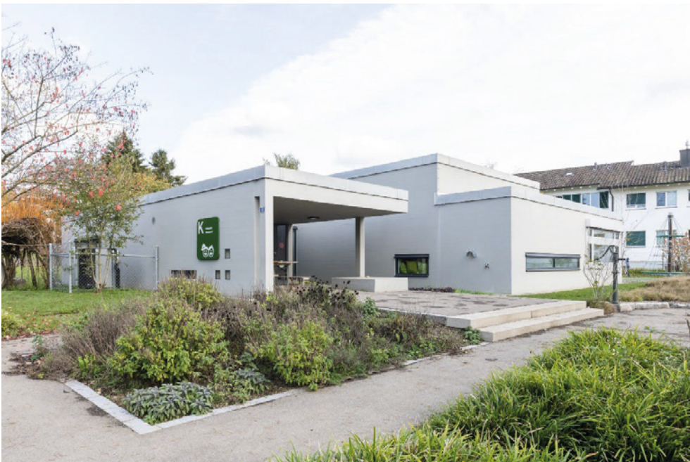
Schulanlage Hinterwiden, Kindergarten B (Vers. Nr. 01682), Ansicht von SW, 02.11.2022 (Bild Nr. D101362_35).
