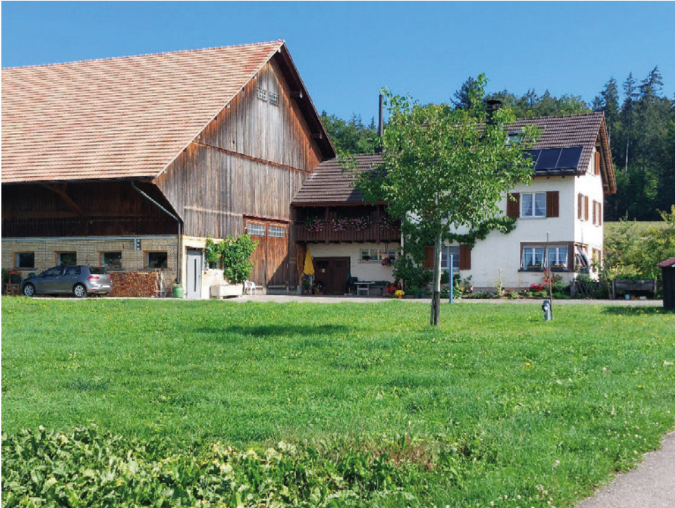
Zelglihof, grosse Stallscheune, Zwischenbau und Wohnhaus, Ansicht von S, 10.08.2022 (Bild Nr. D100692_82).
