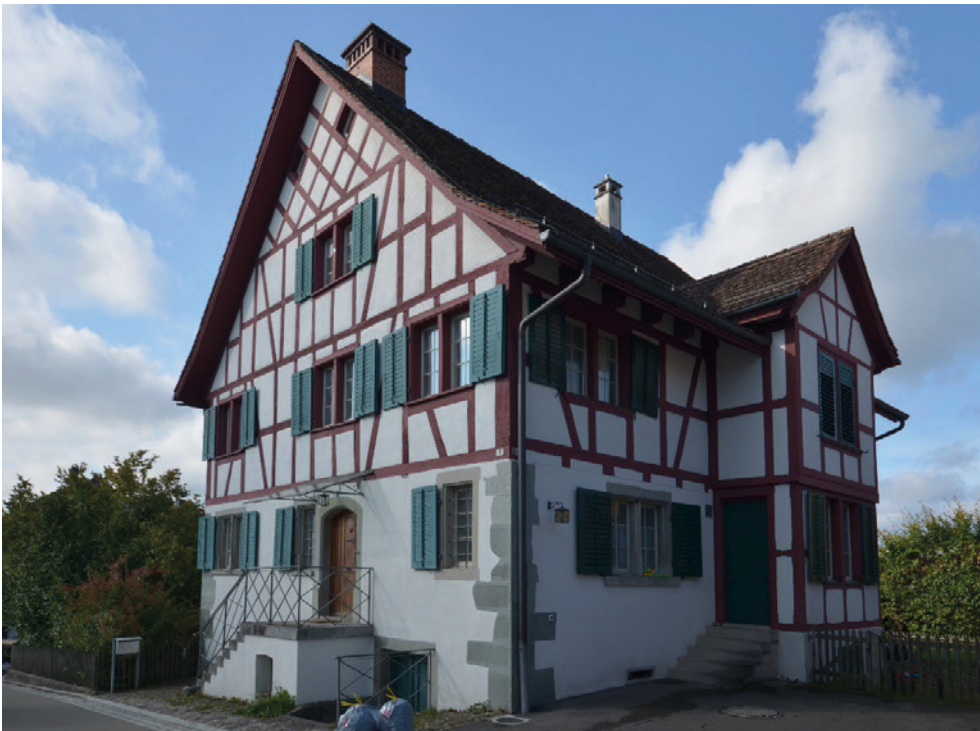
Ref. Pfarriiegenschaft, Pfarrhaus (Vers. Nr. 00200), Ansicht von NO, 31.10.2021 (Bild Nr. D101385_03).
