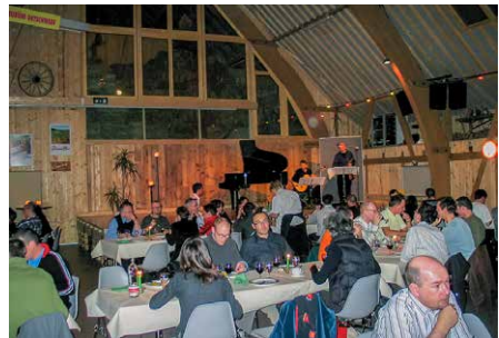
Diese in ein Kulturlokal umgenutzte Heubühne in Kirchlindach BE konnte nicht bewilligt werden.
