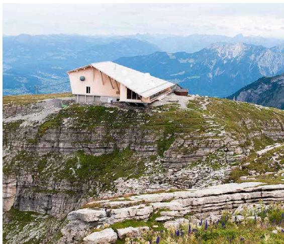
Seilbahnstationen und Bergrestaurants wie hier auf dem Chäserrugg im Toggenburg SG sind oft standortgebunden. Foto: A. Straumann, EspaceSuisse
