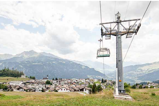
Mit dieser Mobilfunkantenne in Falera GR auf dem Masten eines Sässellift befaste sich auch das Bundesgericht. Foto: B. Jurd, EspaceSuisse
