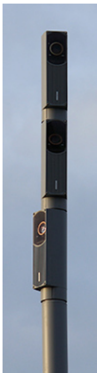
Abbildung 23: 13 Projektoren, die an sieben Standorten platziert sind und auf gegenüber liegenden Dächern sowie auf Masten der Strassenbeleuchtung (Bild links) angebracht sind, beleuchten die Heiliggeistkirche vor dem Bahnhof in Bern (Bild rechts, Quelle: Energie Wasser Bern). Durch die Verwendung von speziell angefertigten Schablonen in den Projektoren wird das Licht präzise gelenkt, es werden Helligkeitsunterschiede erzeugt sowie Details hervorgehoben, wie die Dachbrüstung mit den Vasen und Urnen auf der Längsseite der Kirche.
