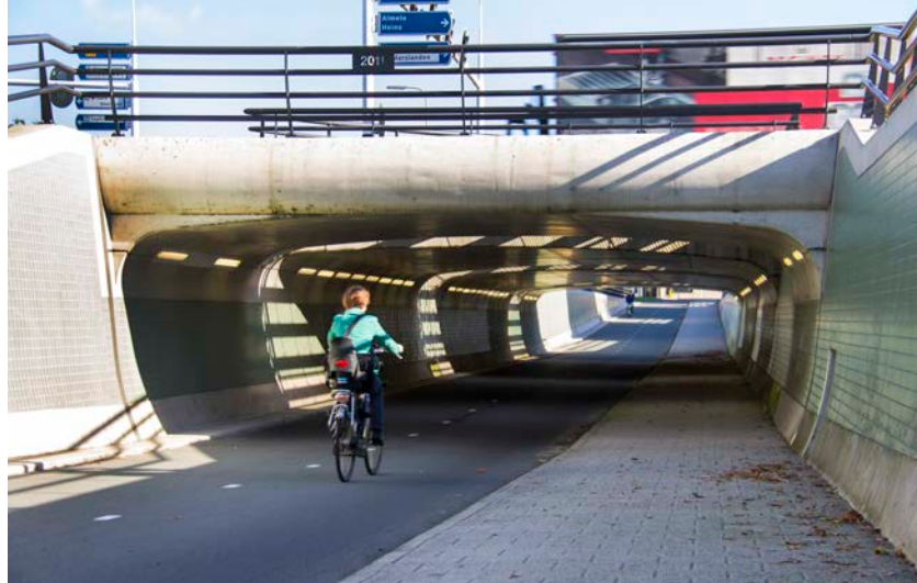
Niveaufreie Querung einer Hauptverkehrsstrasse (NL)
