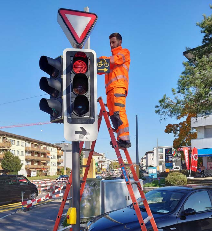
Montage der Zusatzmarkierung auf Höhe des Rotlichts
