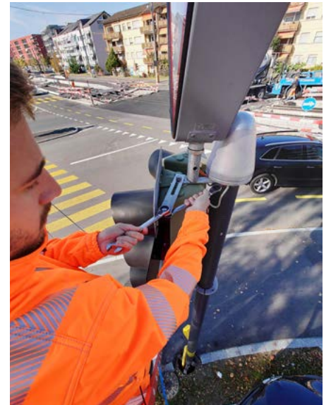
Montage der Zusatzmarkierung auf Höhe des Rotlichts
