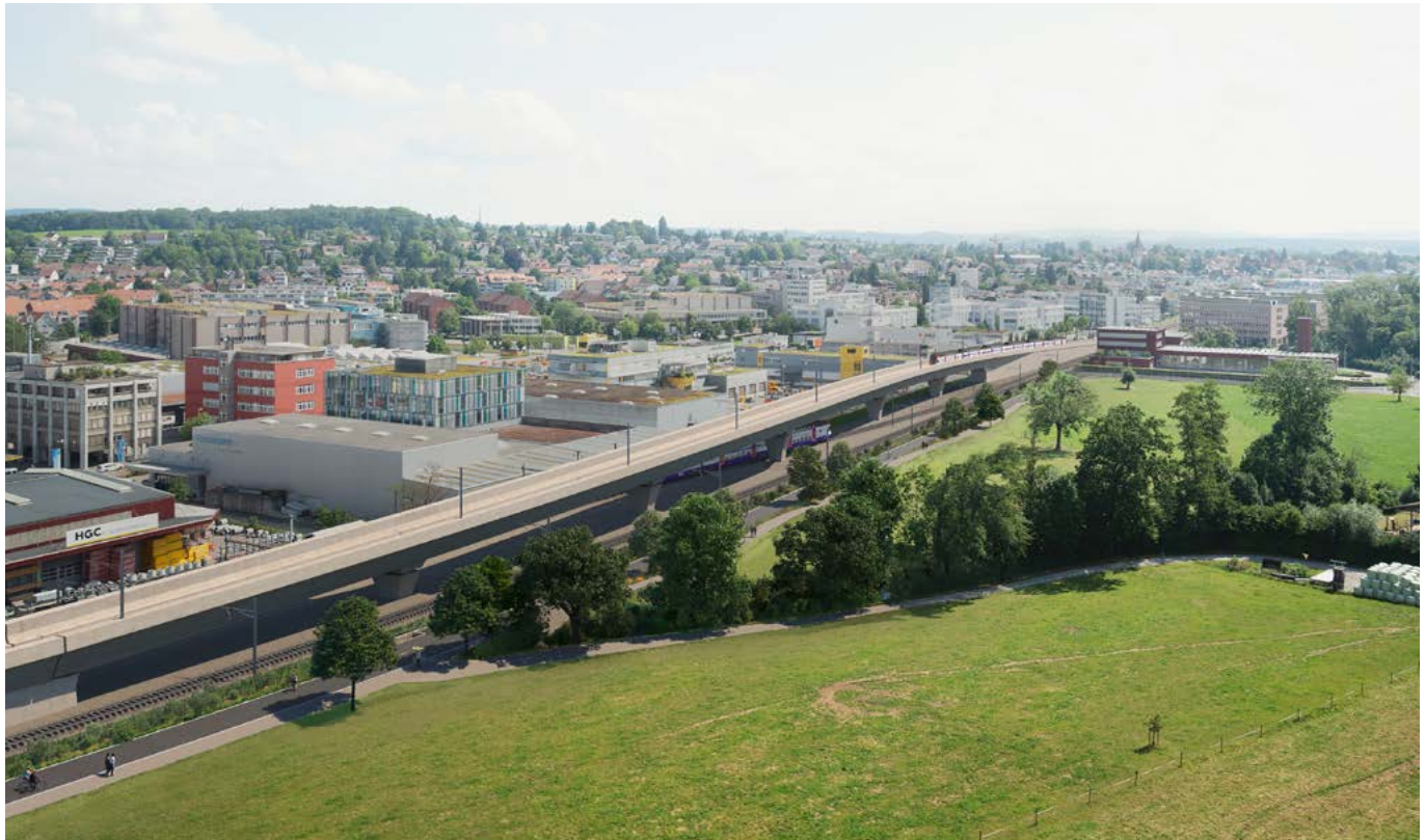
SBB-Viadukt (Überwerfung) mit Blick von der Stadtgrenze Zürich in Richtung Wallisellen.
