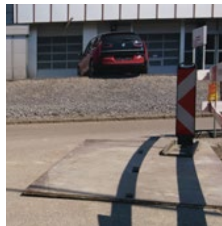
Scharfkantige Stahlplatten sind ein Sicherheitsrisiko und auch bei kurzen Baustellen zu vermeiden (Zürichstrasse Wetzikon).
