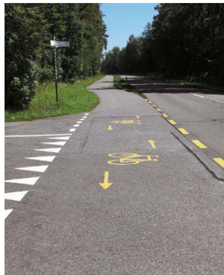
Gutes Infrastrukturbeispiel eines Rad-Gehwegs in Wallisellen.
