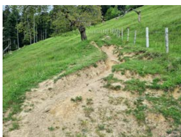
Abb. 4 Beispiel eines instabilen Wegtrassees aufgrund Erosion
