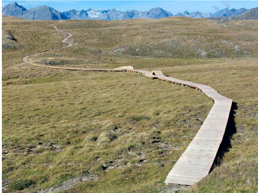
Abb. 17 Bauliche Elemente am Muot da l'Hom in Scuol
