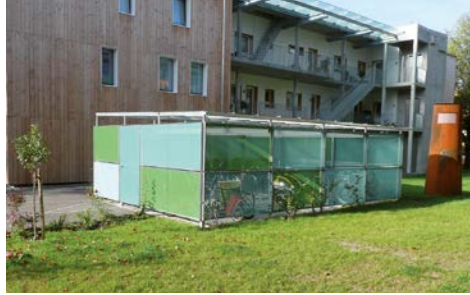
Veloparkierung in Nebengebäuden sind besser zu erreichen und günstiger zu erstellen als in Untergeschossen
