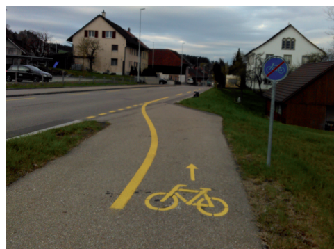
1. Querungsmöglichkeit im fließenden Verkehr als Linksabbieger (Sicht aus Gegenseite) (2. Möglichkeit siehe Bild oben, geschützter Bereich durch Mittelinsel)
