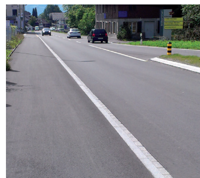
Rad-Gehweg im Bereich Eingangstor
