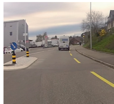
Ortseingang West: Beginn Radstreifen bei Mittelinsel
