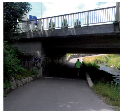
Gestreckte Linienführung der Unterführung
