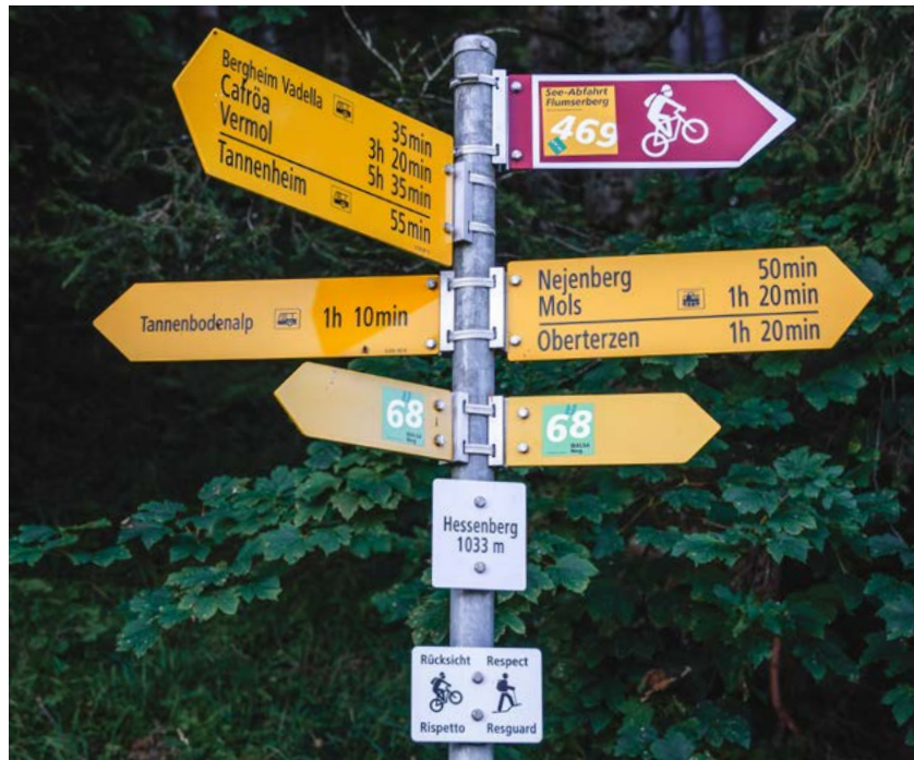
Bild 8-1: Beispiel eines Richtungszeigers mit einem Routenfeld, korrekt oberhalb der Wanderwegweisung montiert
