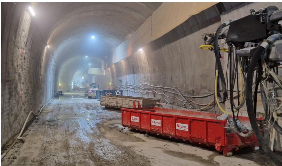
Abbildung 10: Beispiel einer Triage im Vortrieb mittels nach Materialart getrennten Mulden (Stahl, Beton)
