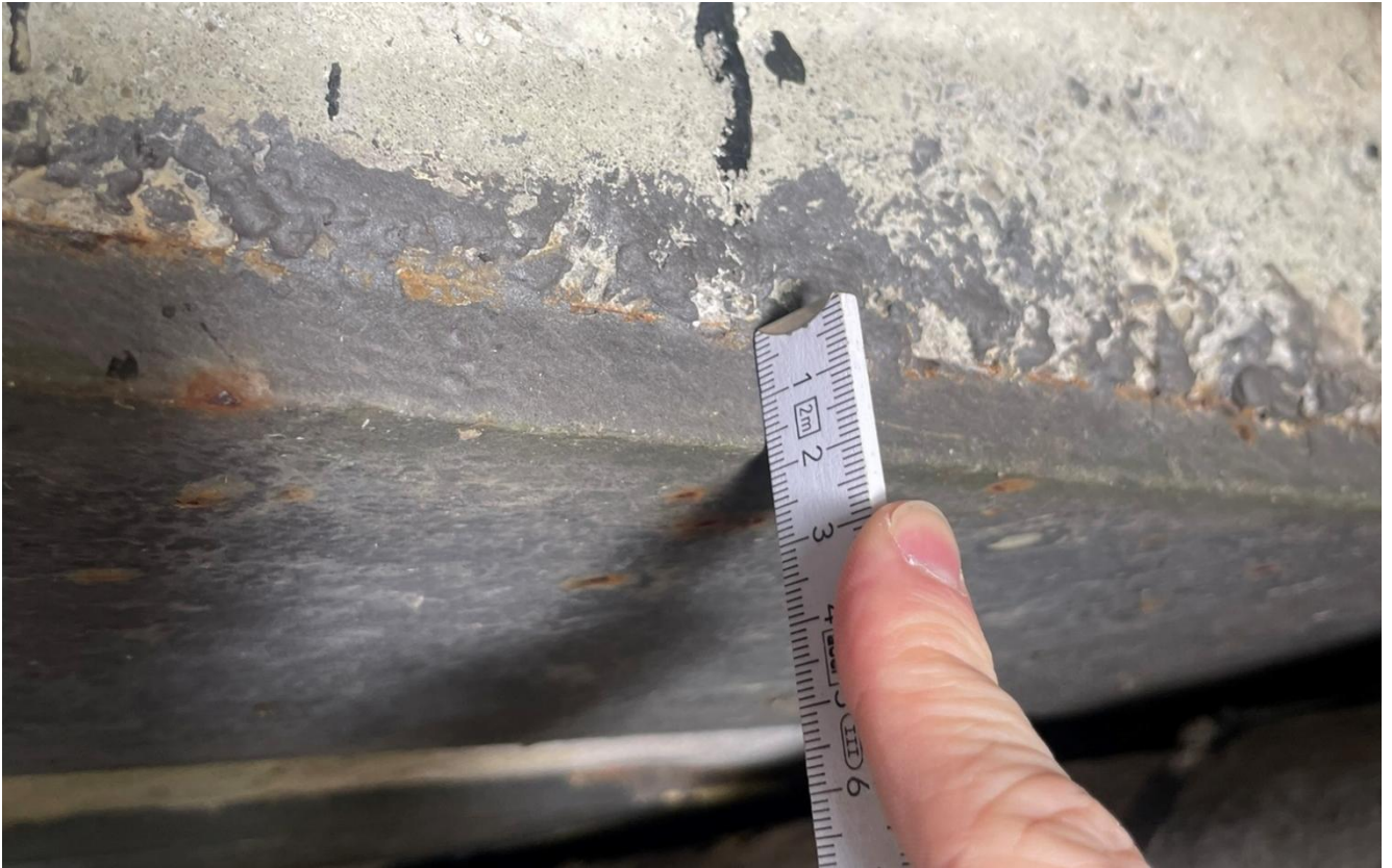
Abbildung 17: Messung Flanschdicke
