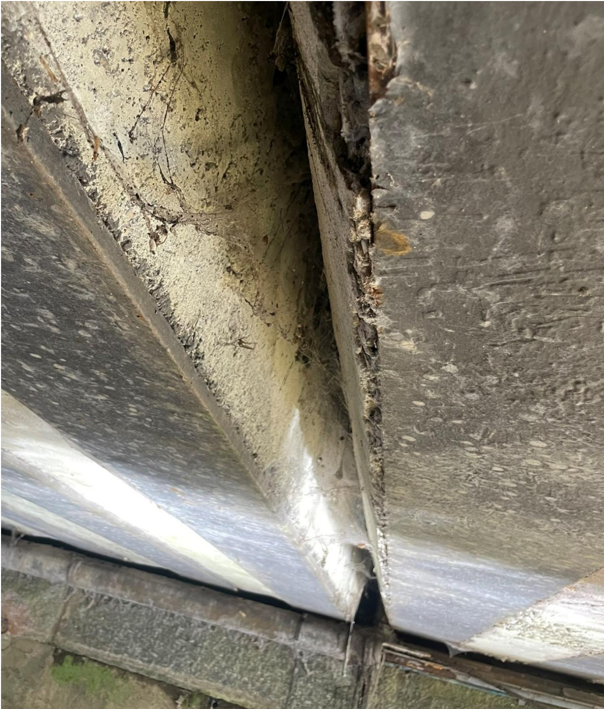
Abbildung 18: Spalt zwischen den Betonplatten
