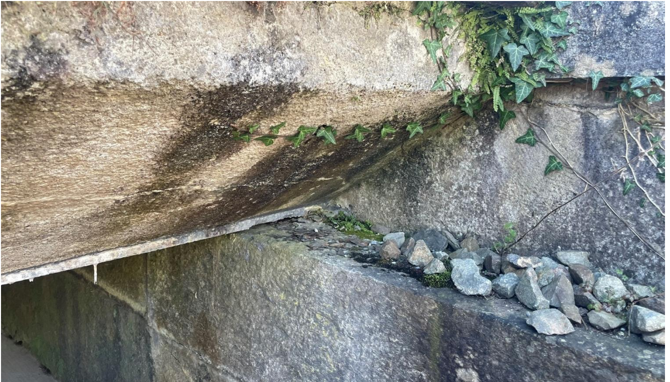
Abbildung 15: Übergang Stahlträger in Widerlager (Auflager nicht erkennbar)
