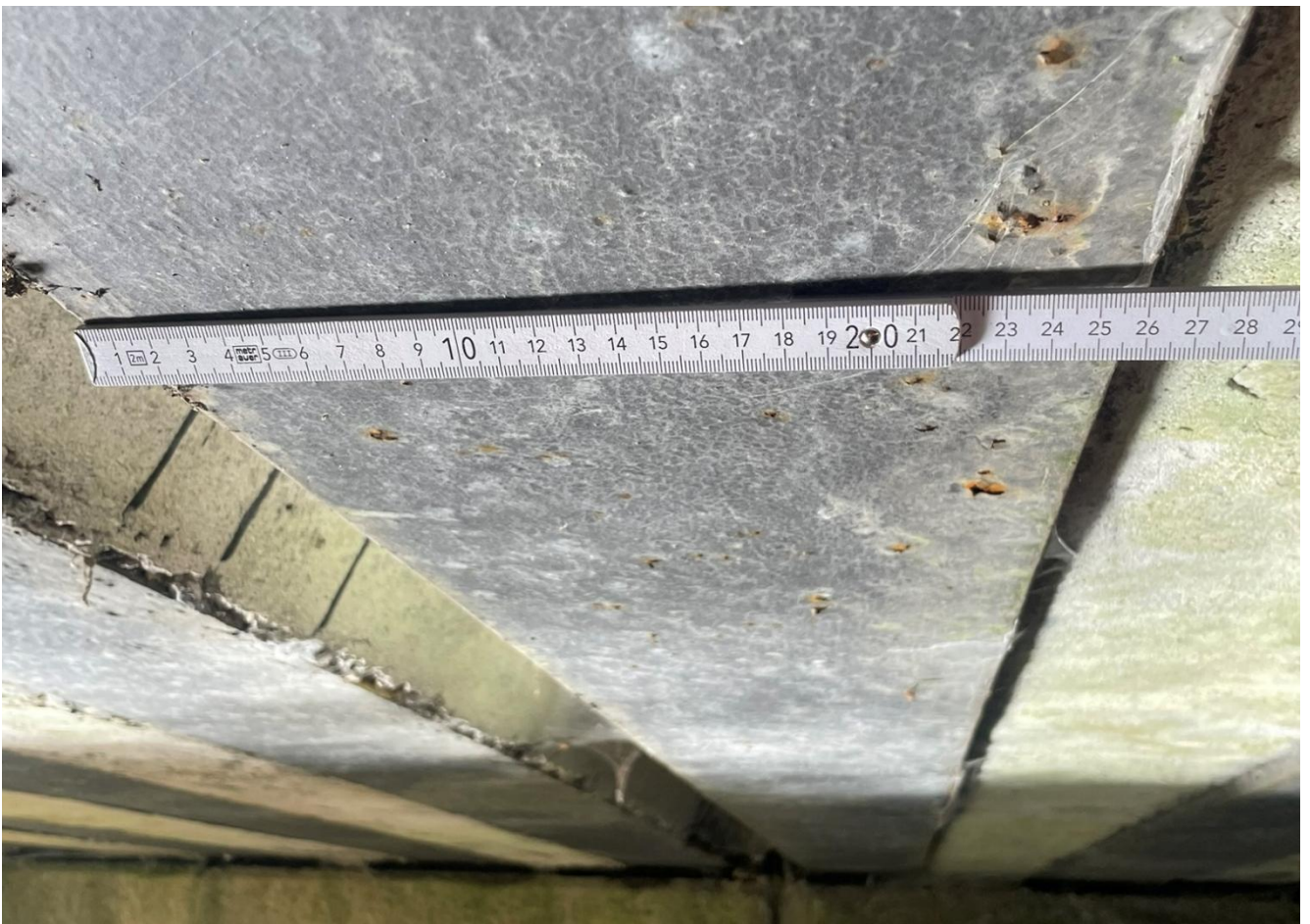
Abbildung 16: Flanschbreite Stahlträger
