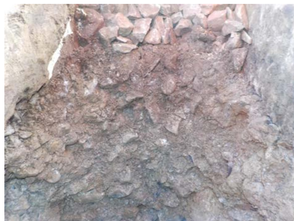
Bild 12: W 29, km 6.001: Schotter in den Schienenbereichen mittelmäßig bis stark (S2-S3) verschmutzt, gerade noch wirksam reinigbar, Stopfbarkeit allerdings bereits deutlich eingeschränkt
