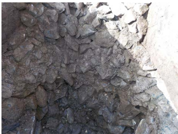
Bild 17: W 29, km 5.960, Ablenkung: Schotter in den Schienenbereichen mittelmäßig (S2) verschmutzt, wirksam stopf- und reinigbar
