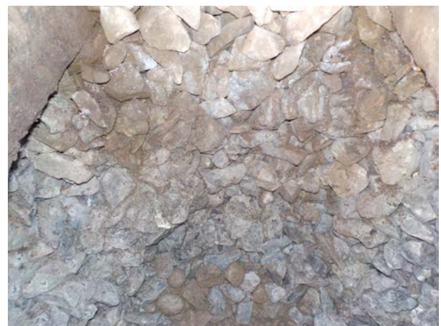
Bild 4: W 24, km 5.959: Schotter in den Schienenbereichen allenfalls gering bis mittelmässig (S1-S2) verschmutzt, gut stopf- und reinigbar
