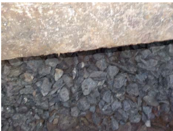
Bild 3: W 24, km 5.959: Schotter in Gleismitte nur gering (S1) verschmutzt, gut stopf- und reinigbar
