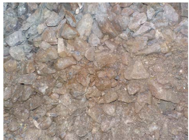
Bild 6: W 24, km 6.002, Hauptstrang: Schotter in den Schienen- bereichen mittelmässig verschmutzt (S2), wirksam stopf- und reinigbar
