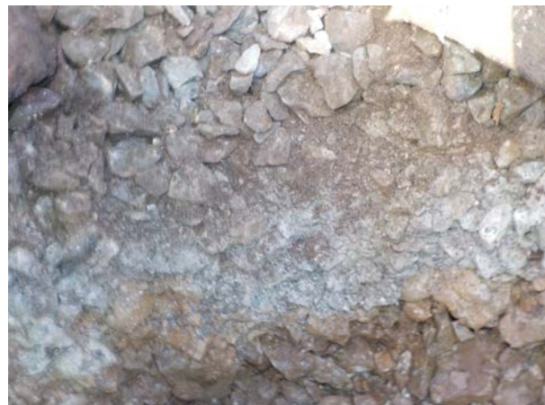
Bild 8: W 24, km 6.002, Ablenkung: Schotter in den Schienenbereichen mittelmäßig bis stark (S2-S3) verschmutzt, gerade noch wirksam reinigbar, Stopfbarkeit allerdings bereits deutlich eingeschränkt
