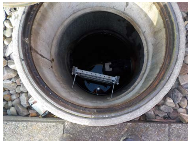
Bild 14: Blick in den Entwässerungsschacht bei ca. km 6.004; ausreichende Tiefenlage der Leitungen, nach visueller Beurteilung funktionstüchtig
