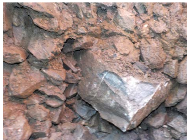
Bild 18: W 29, km 5.960, Ablenkung: im Schotterbett sind ab ca. 41 cm u. SwOK lokal Steine und Blöcke mit Kantenlängen bis zu 30 cm vorhanden
