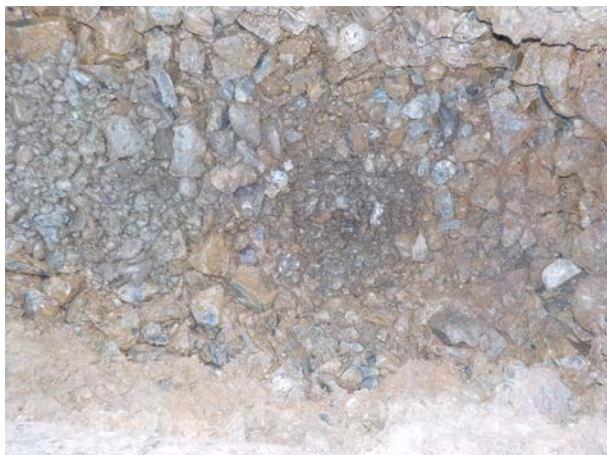
Bild 13: W 29, km 6.001: Blick in den Aufschluss, der Unterbau besteht aus leicht siltigem Kies mit wenig Sand und einzelnen Steinen (Bodengruppe GP-GM, Schichtdicke mindestens 31 cm)
