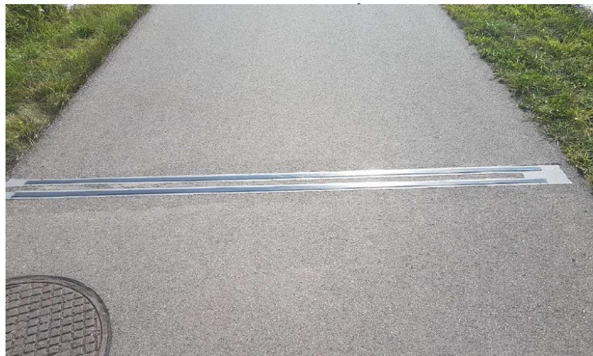
Abbildung 27: Im Strassenbelag eingebaute Sensoren A und B (hier in einem Radweg, Mindestabstand zu Detektorschacht von ca. 80 cm)
