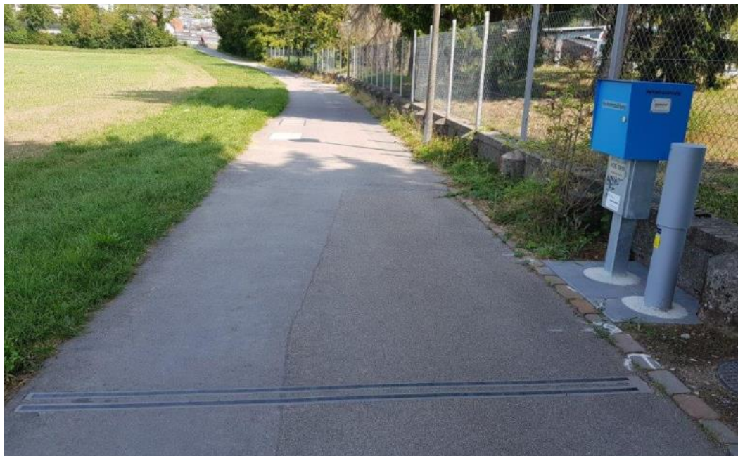
Abbildung 20: Im Strassenbelag eingebaute Sensoren (Beispiel Radweg)
