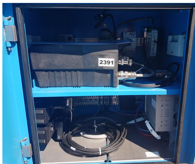
Abbildung 25: Einbau MIV- und Bike-Counter-Zählgerät in Apparateschrank
