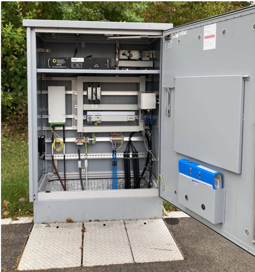
Abbildung 14: Doppelwandkabine Almatec ANK 1000 x 1250 x 550 mm
