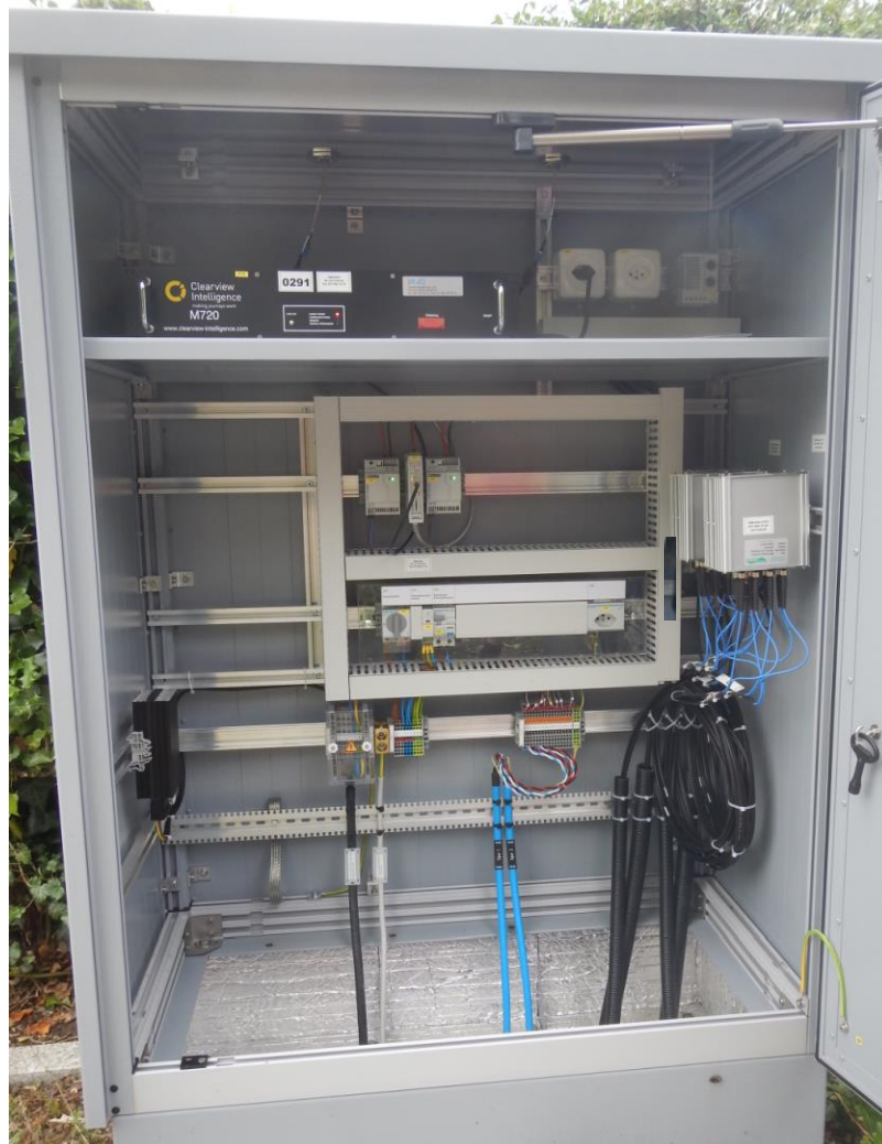
Abbildung 26: Einbau MIV- und Bike-Counter-Zählgerät in Kabine, siehe auch Einbau bei 2-teiliger Kabine (Abbildung 13)
