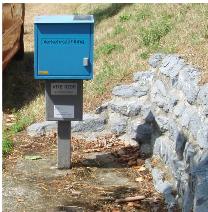
Abbildung 6: Böschungssicherung mit Natursteinen gemörtelt
