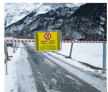
Abb. 25 Wegsperrung Winterwanderweg mittels Schranke
