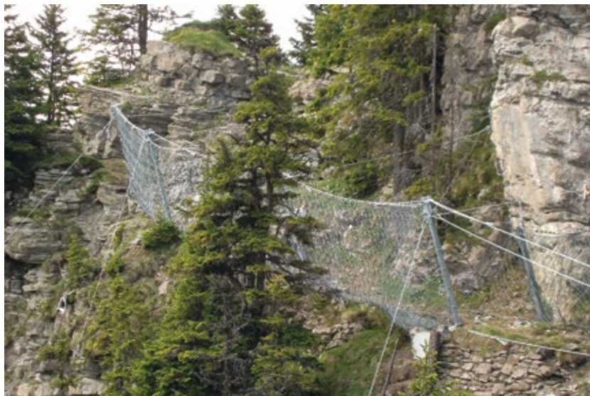
Steinschlagnetze oberhalb Bergwanderweg Schynige Platte–Breitlauenen.
