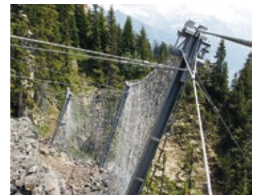
Steinschlagnetze oberhalb Bergwanderweg Schynige Platte–Breitlauenen.
