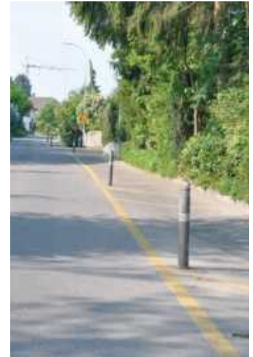
Längsstreifen, mit Pfosten gesichert.
