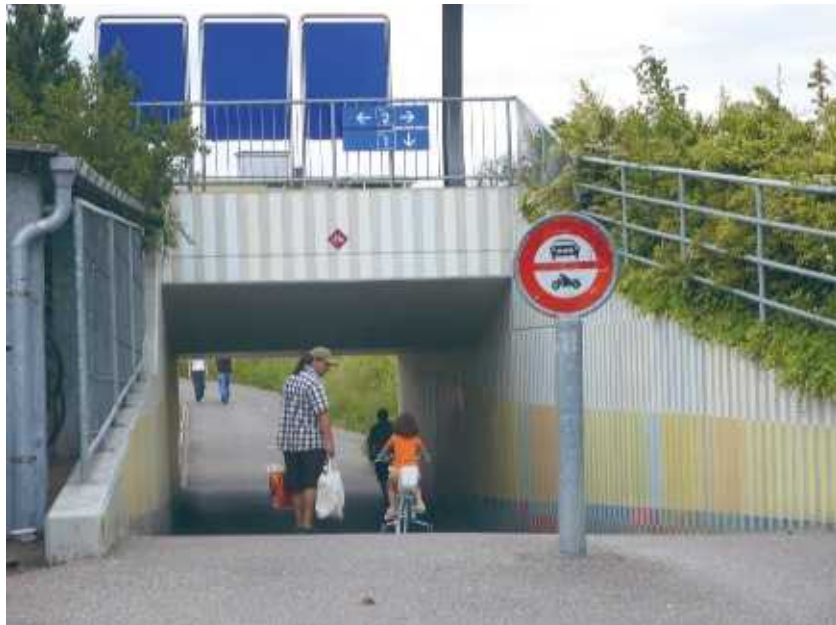
Die geradlinig geführte Unterführung ist gut einsehbar.
