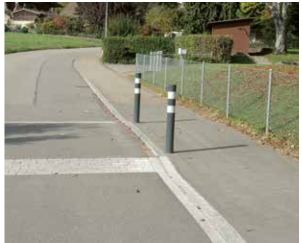
Querungsstelle mit vertikalem Versatz; Pfosten verhindern das Befahren des Wartebereichs.
