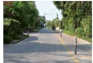
Längsstreifen für Fussgänger mit Pollern geschützt.
