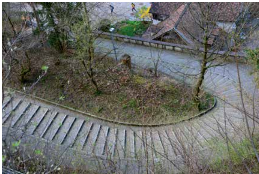
Kombinierte Rampen- und Treppenanlage.
