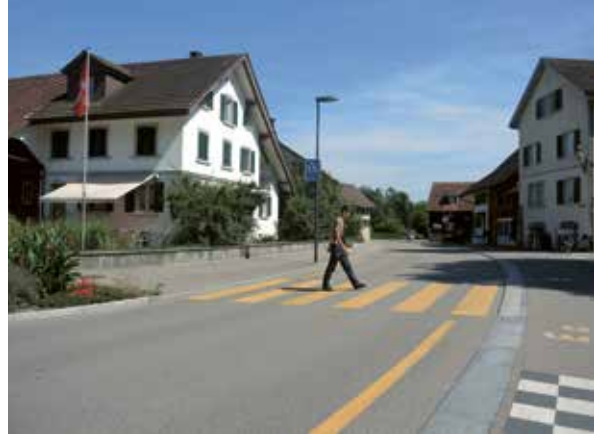
Fussgängerstreifen ohne Mittelinsel auf schwach frequentierter Strasse.
