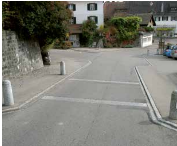
Insbesondere bei niedrigen Randabschlüssen können Pfosten als ergänzende Massnahmen zur Sicherung der Querung eingesetzt werden.
