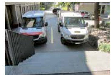
Parkplätze versperren den Zugang zur Treppe.
