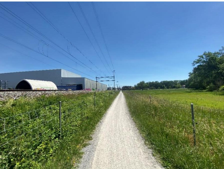
Geplante Veloschnellroute Glatttal-Oberland: bestehender Weg in Wallisellen
