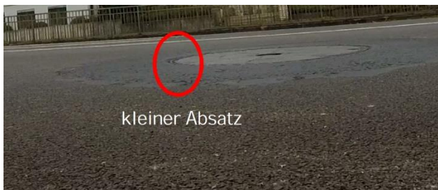
Abbildung 2: Schachtdeckel nach den Nachbesserungsarbeiten
