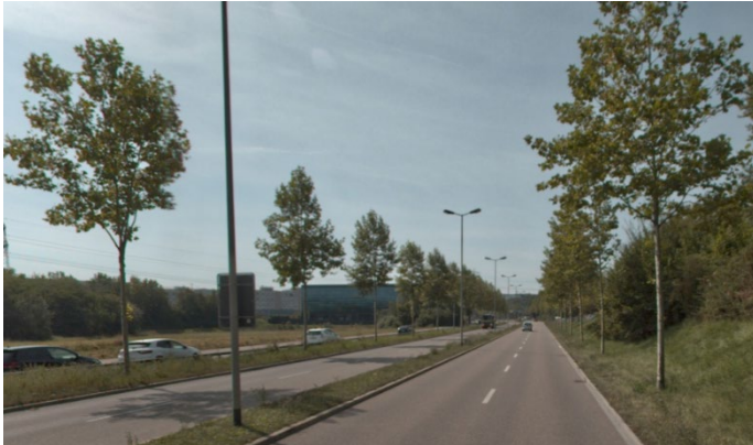
Thurgauerstrasse, Opfikon vorher
